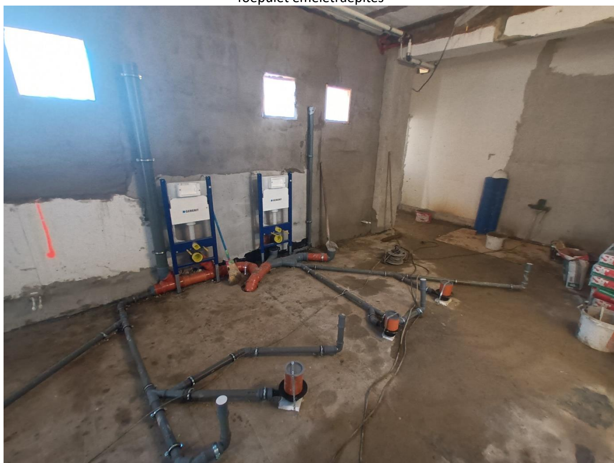
Főépület gépészeti alapszerelés
