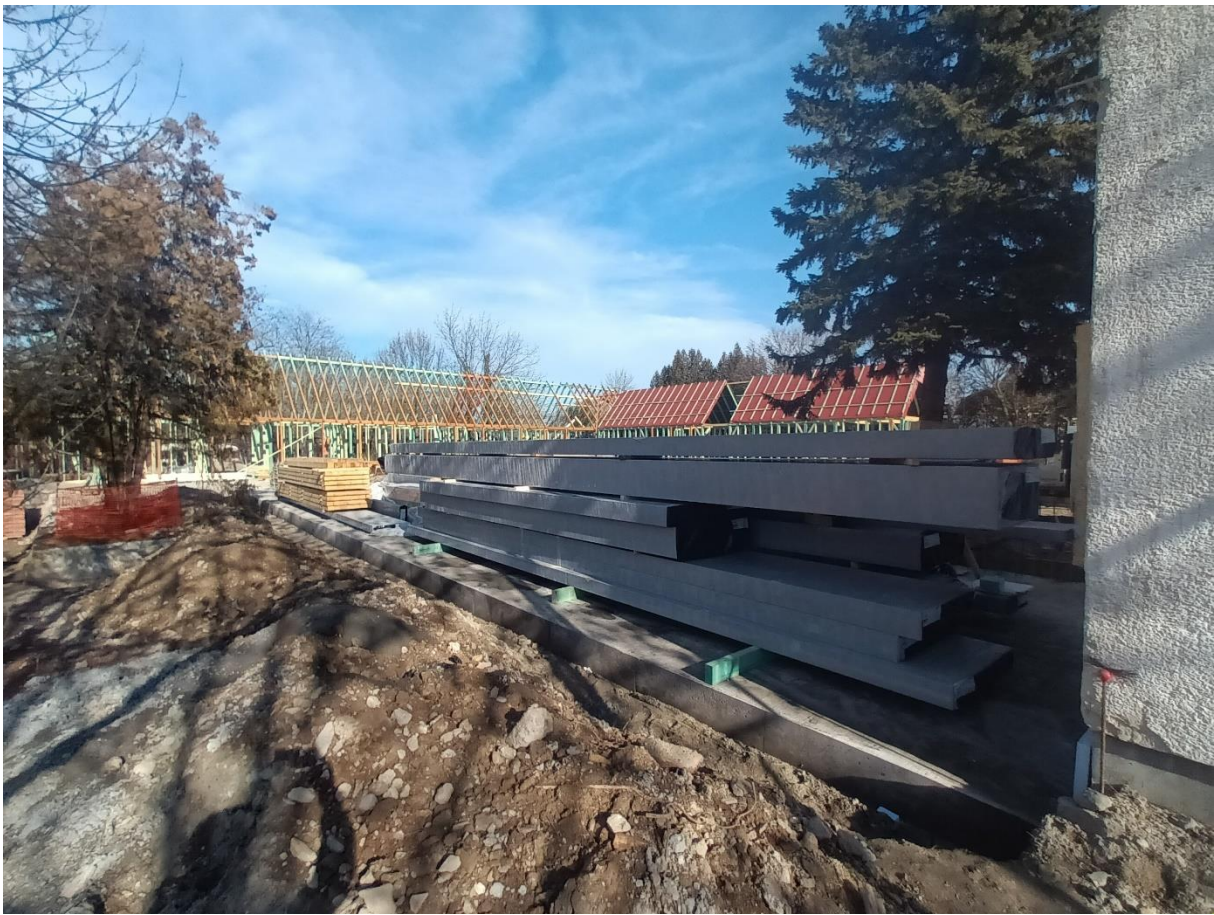
Csűr alapozás, faszkerkezeti elemek
