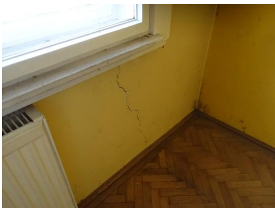
33. repedés a felmenő falazaton
