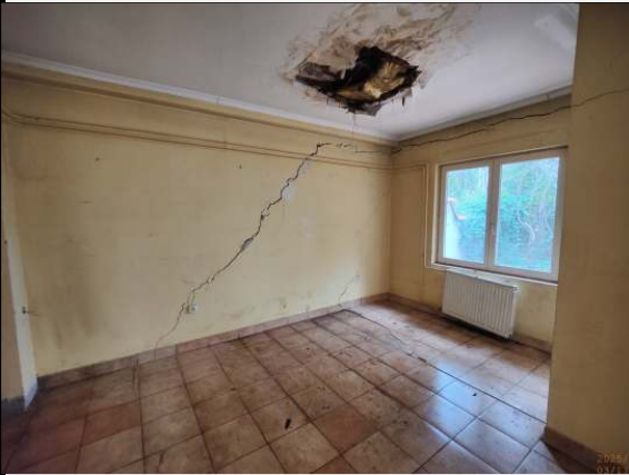
nappali-konyha-étkező (beázás, repedés)
