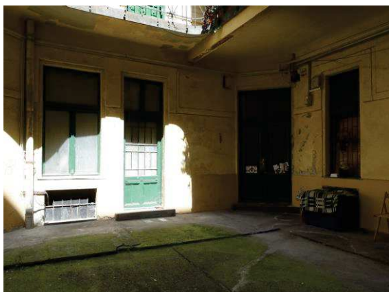
09. értékelt lakás bejáratai és udvari ablaka
