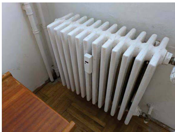
11. öntöttvas radiátor hőmennyiségmérővel
