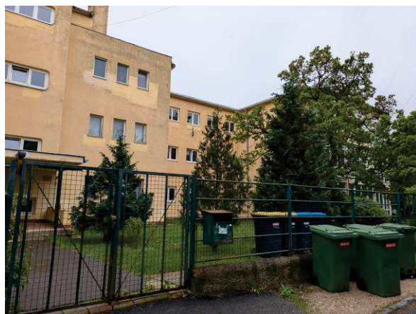
04. értékelt ingatlant befogadó épület
