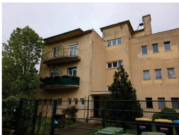
03. értékelt ingatlant befogadó épület
