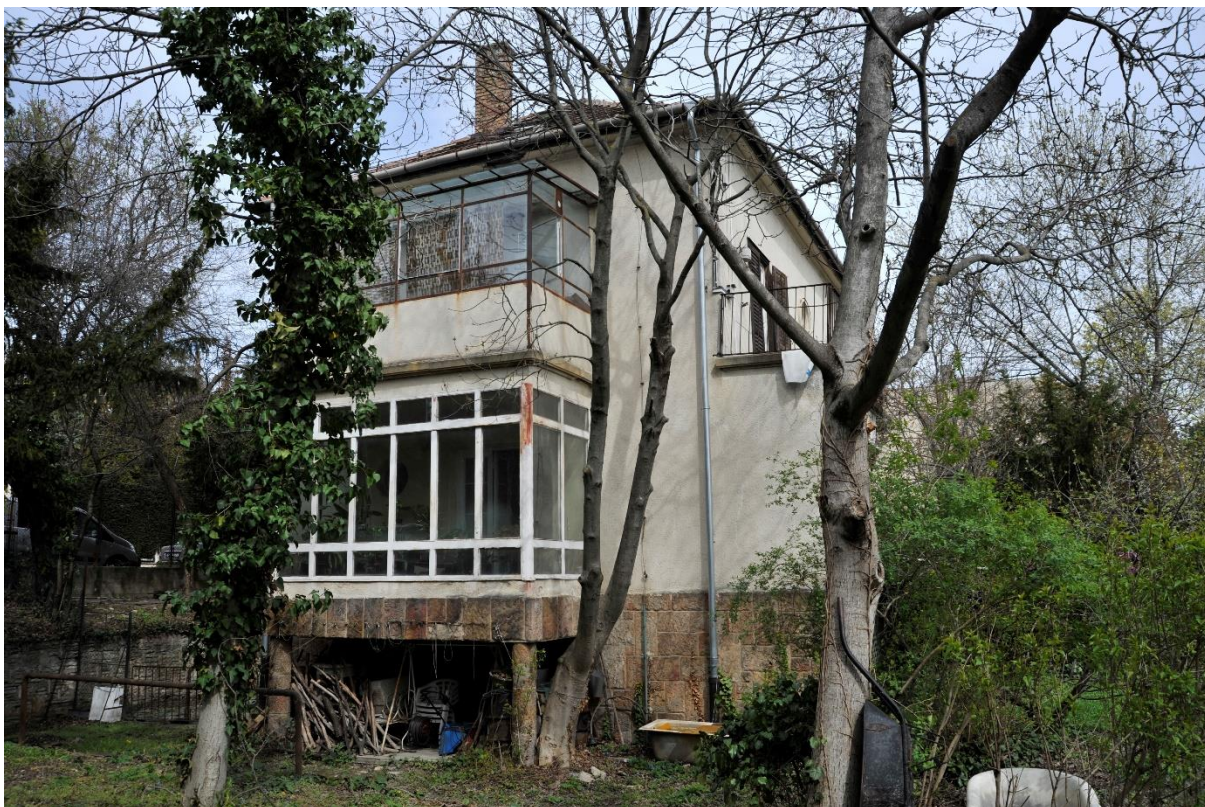
19. kép Az épület déli homlokzata
