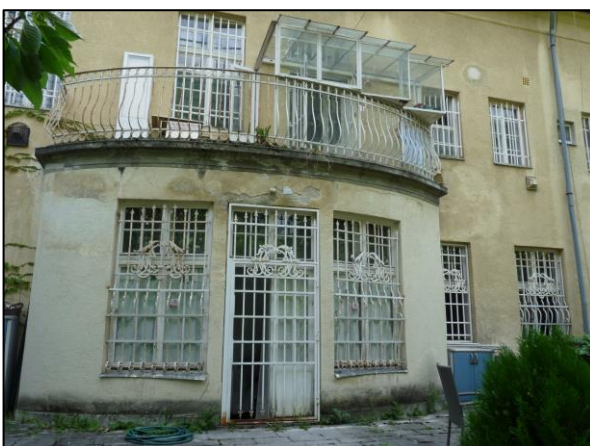
40. kép Északi homlokzat részlet
