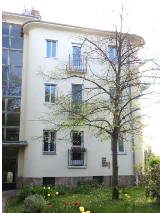
65.-67. A hátsó kerti homlokzat függőleges tengelyeinek homlokzati szakaszai - 7 tengelyes szimmetrikus homlokzat kialakítása építészeti
