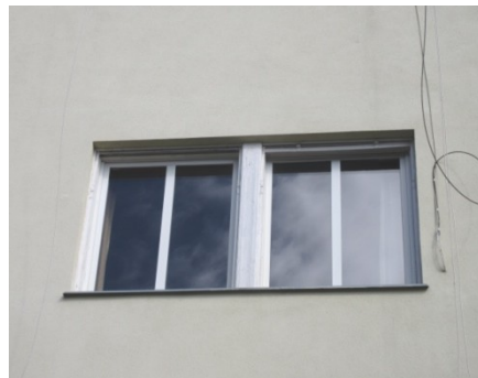
94.-96. A 2. tengely I. II. és III. emeleti ablakainak a részletei – az I. emeleti ablak építéskori, a II. és III. emeleti ablakok nyílászárói már újabb szerkezetek, de osztásukban illeszkednek az eredeti nyílászárókhoz
