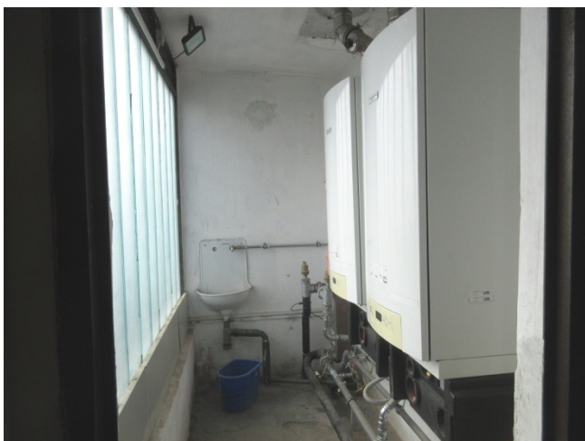
190.,191. A kazánház belső tere és a tetőre nyíló ajtó – a jelenlegi kazánház kialakítása és kopilit-üvegezésű homlokzati fala eredeti építéskori kialakítású, de funkciója már megváltozott (eredetileg a liftgépház volt itt). A tetőre vezető fém ajtó építéskori nyílászáró
