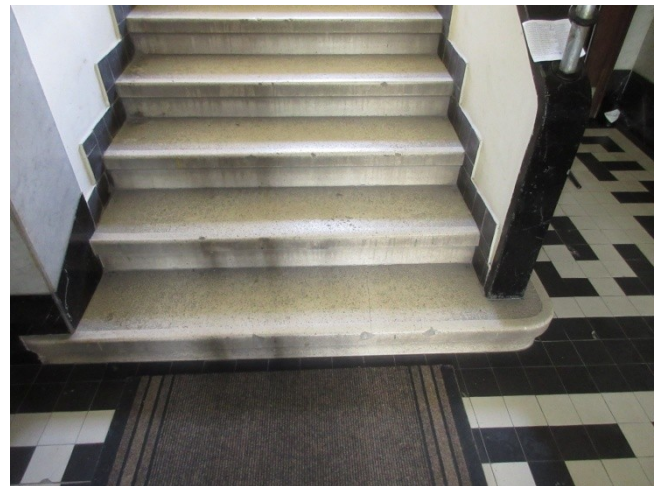
141.-144. A földszintről az I. emeletre (magasföldszintre) induló lépcsőkar nézetei és a lépcső részletei – a kétkarú, fémcső kapaszkodóval határolt tömör falazott mellvédes, műkö lépcsőfokos lépcső eredeti építéskori szerkezet
