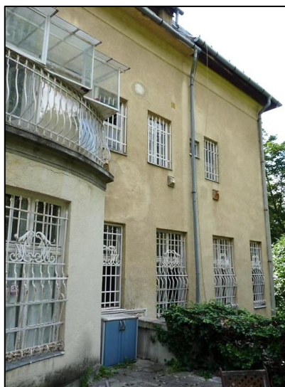
38. kép Északi homlokzat részlet
