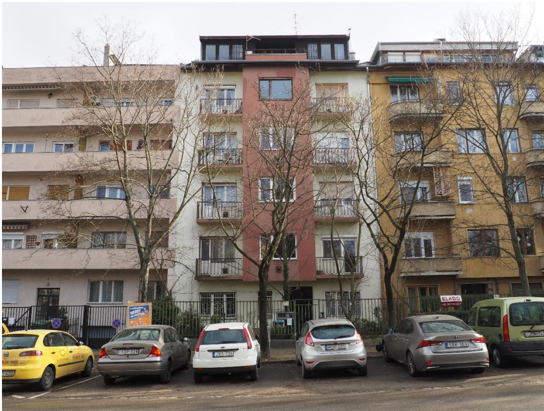
6. kép Németvölgyi út 28/B, 2021
