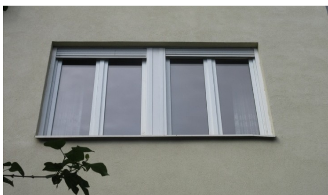
24.-26. A zárterkélyes középrizalit nézete és az I., II. és III. emeleti ablakok részletei – az ablaknyílások építéskoriak, de a bennük lévő páros elhelyezkedésű, egyrétegű, középen felnyíló ablakok újabb nyílászárók
