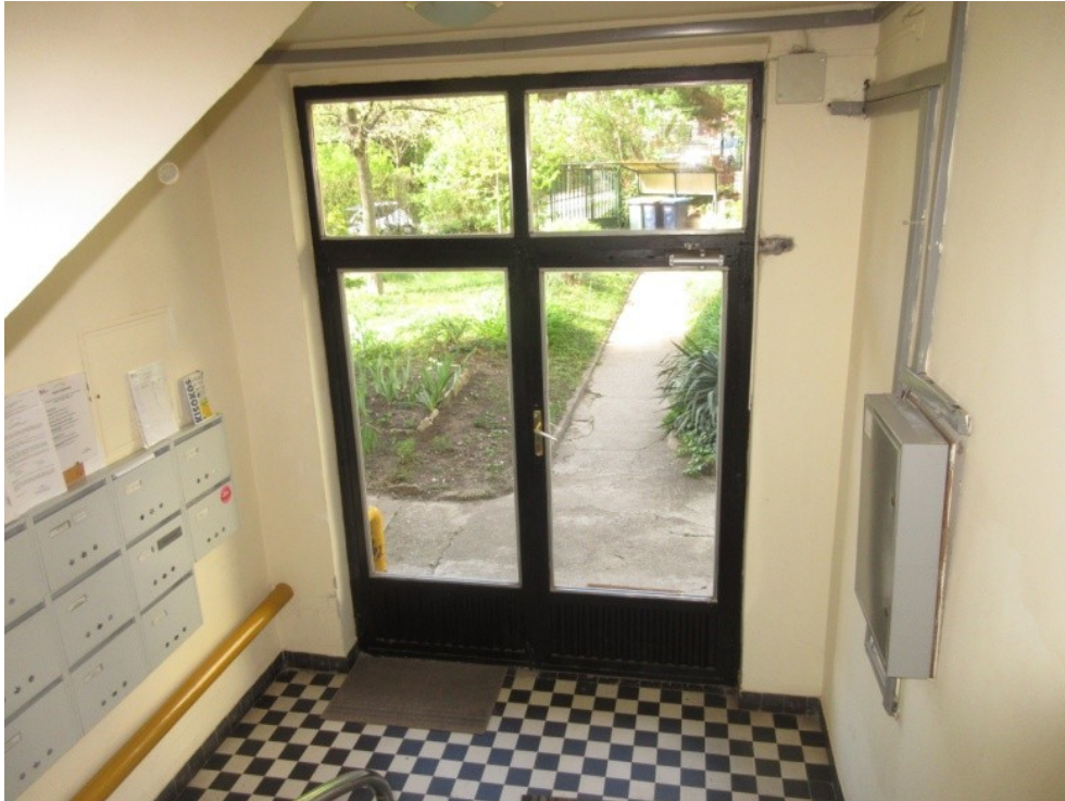
145. A földszint és I. emelet közötti félemeleti pihenő a hátsó, kerti bejárattal – eredeti fém-üveg bejárati ajtó és fekete-fehér márványmozaik padlóburkolat
