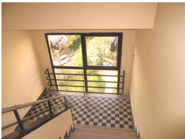
184.-187. A III. emeletről a tetőszintre induló és érkező lépcsőkar, valamint a lépcsőforduló felülnézete és korlátjának részlete - a lépcső, az udvari fém-üveg nyílászáró és korlátja, a burkolat eredeti építéskori, történeti értékű szerkezetek
