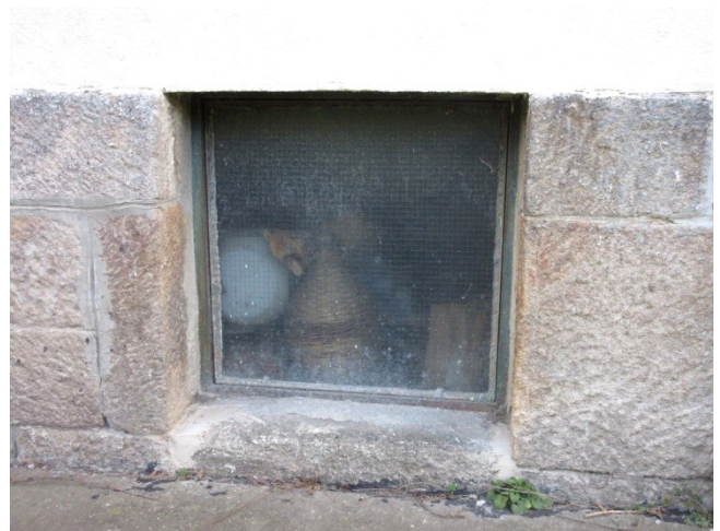
73.-76. Földszinti ablakok és farnciaerkély-ajtó, valamint a pinceablak részlete – a nyílások építéskoriak, de a bennük lévő nyílászárók már újabb szerkezetek, a francia-erkély korlátja eredeti elem
