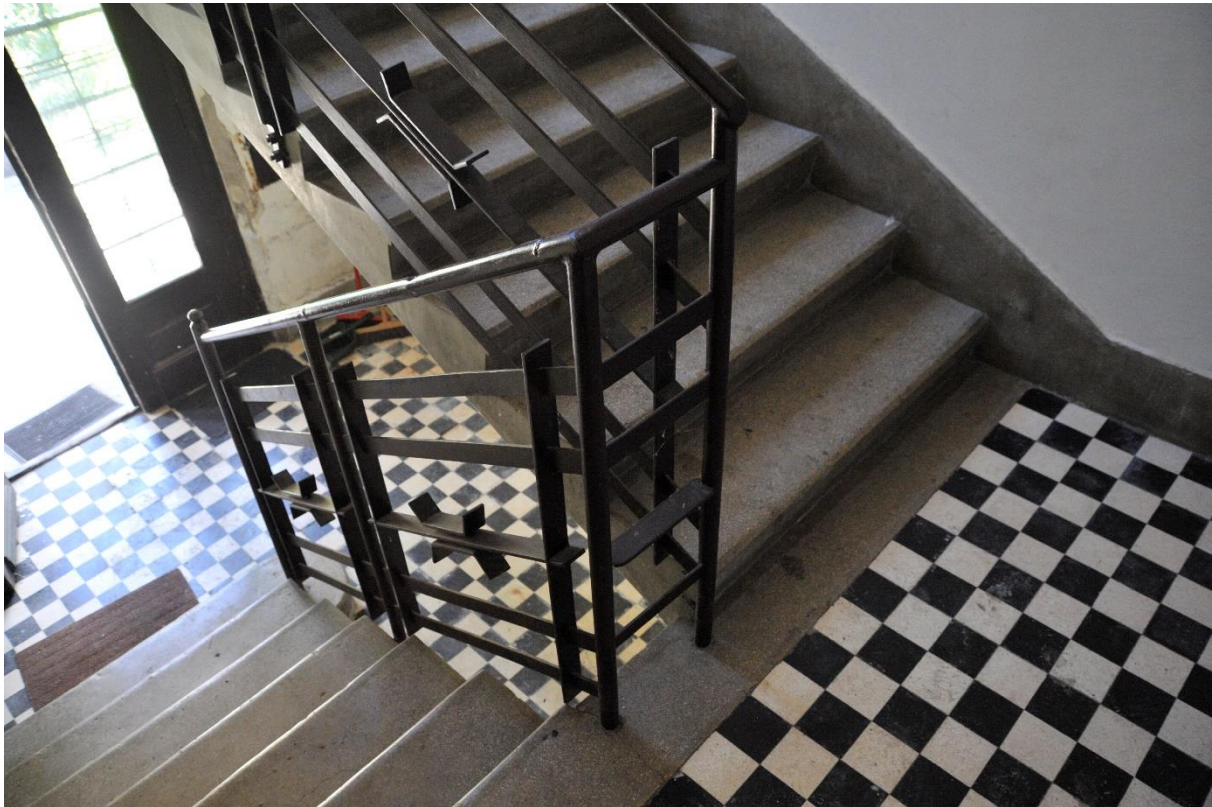
40. kép Lépcsőház, földszinti pihenőlemez és korlát
