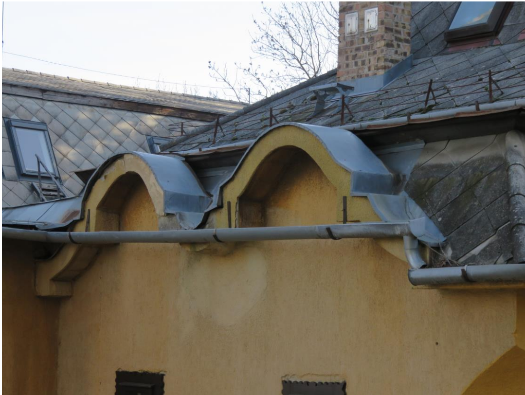
10. kép A villaépület nyugati homlokzata, részlet
