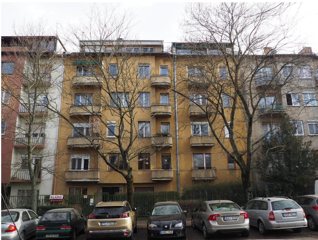
7. kép Németvölgyi út 30/A-B, 2021
