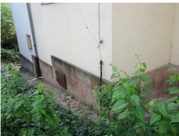
57.-62. Az oldalhomlokzat nyílászáróinak és lábázatának részletei – a terméskő lábázat és a nyíláskiosztások, valamint az erkélyek építéskori szerkezetek, a nyílászárók közül csak kevés építéskori maradt, legtöbbjük már újabb szerkezet
