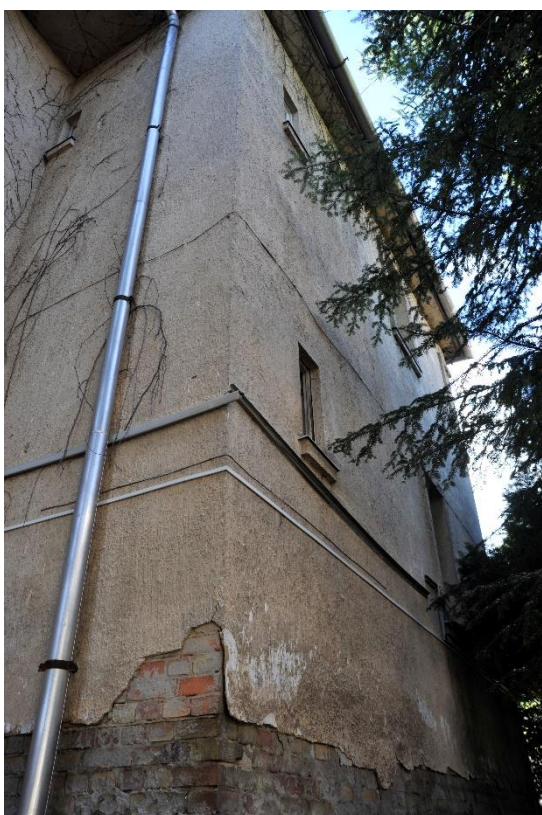
22. kép Északkeleti homlokzat, részlet
