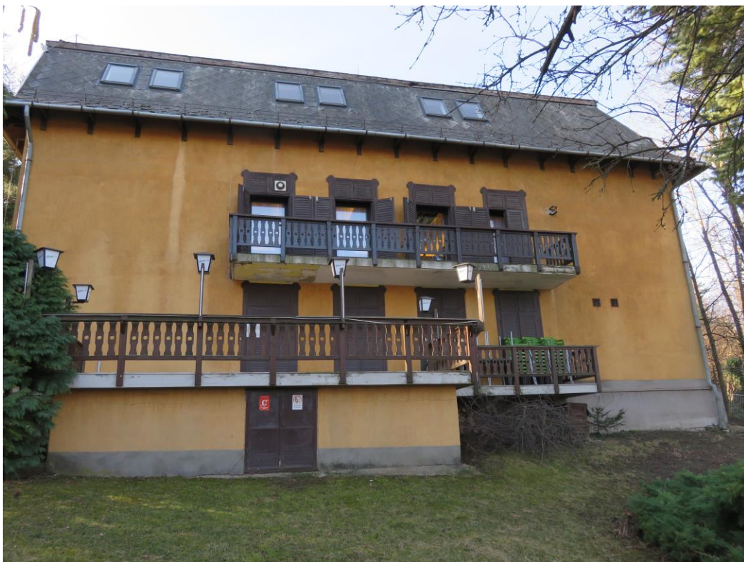
16. kép Az 1983-ban épült toldalék udvar felőli, vagyis északkeleti homlokzata
