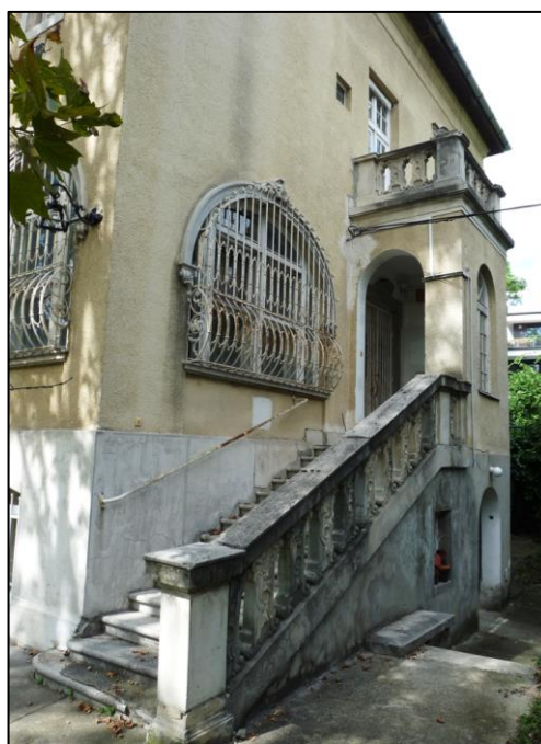
29. kép Keleti homlokzat
