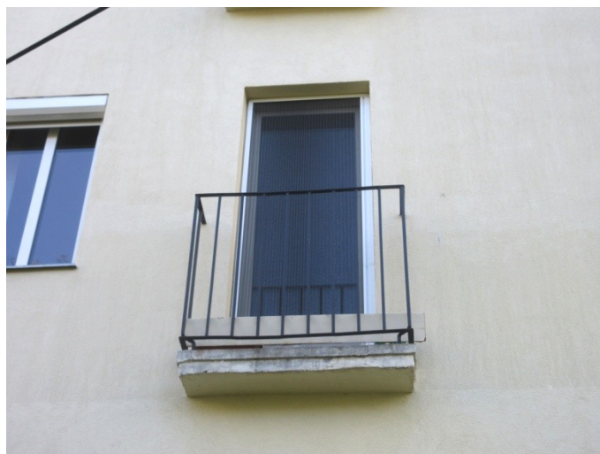
82.-84. Emeleti homlokzati nyílászárók – a nyíláskiosztások építéskoriak, de a bennük lévő ablakok, ajtók zöme már újabb nyílászáró
