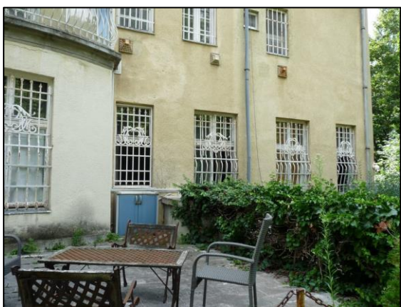
41. kép Északi homlokzat részlet
