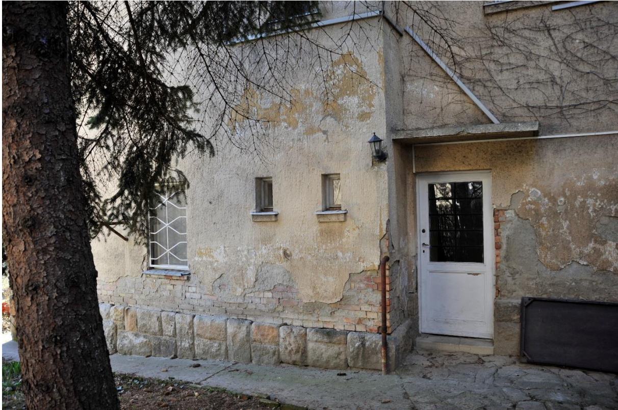
17. kép Északkeleti homlokzat, részlet
