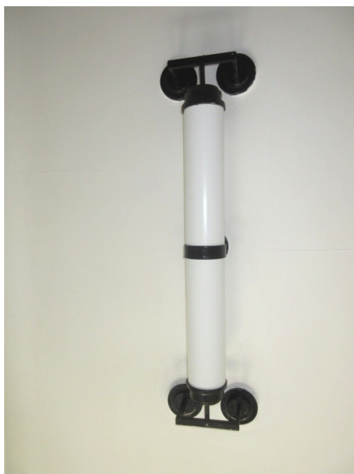
110.,111. A kapualj nézete a lépcsőház felé és a mennyezeten lévő lámpatest részlete – a kapualj szerkezeti kialakítása , fal- és padlóburkolata, valamint az egyedi gyártású, opálüveg hengeres, kovácsoltvas szerelvényes lámpa különösen értékes, építéskori, történeti értékű elemek
