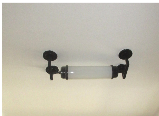
133.-135. A földszinti pihenőn található szerelvények: lakónévsor tábla, mennyezeti lámpa (2 db) és bejárati ajtó eredeti fogógombja – eredeti építéskori, történeti értékű elemek
