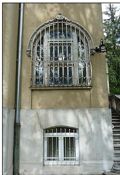
59. kép Nyílászáró részlet
