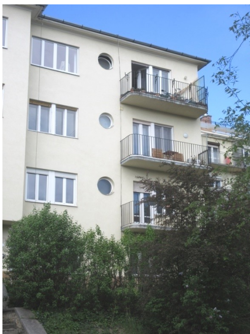
7.-9. A főhomlokzat függőleges tengelyeinek részletei – a földszinten 7, az emeleteken pedig 5 tengelyes homlokzat eredeti építéskori, történeti értékű kialakítású és megjelenésű
