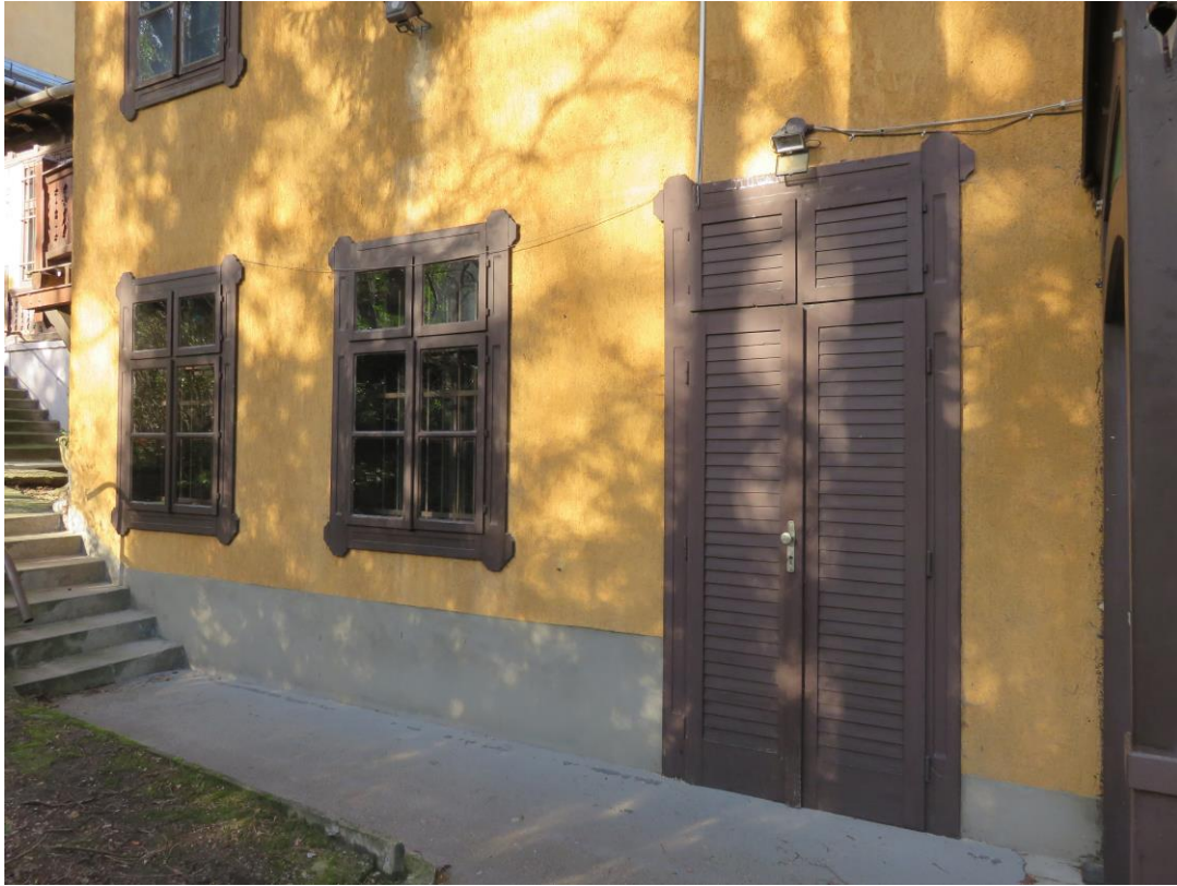
19. kép Az 1983-ban épített toldalék szárny keleti homlokzata
