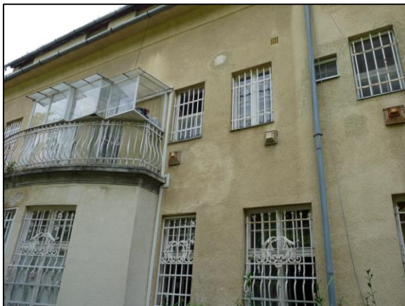
39. kép Északi homlokzat részlet
