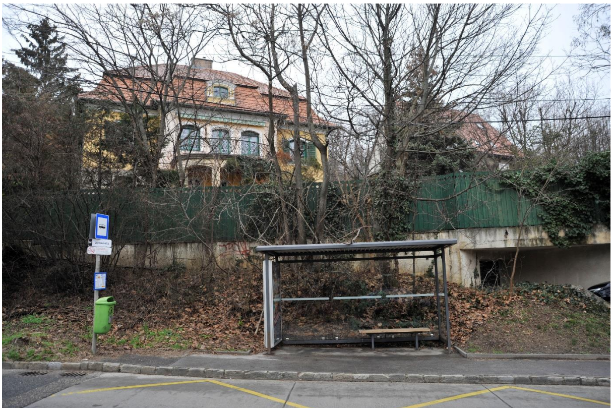
17. kép Az épület és a kerítéstámfal a Fodor utca felől
