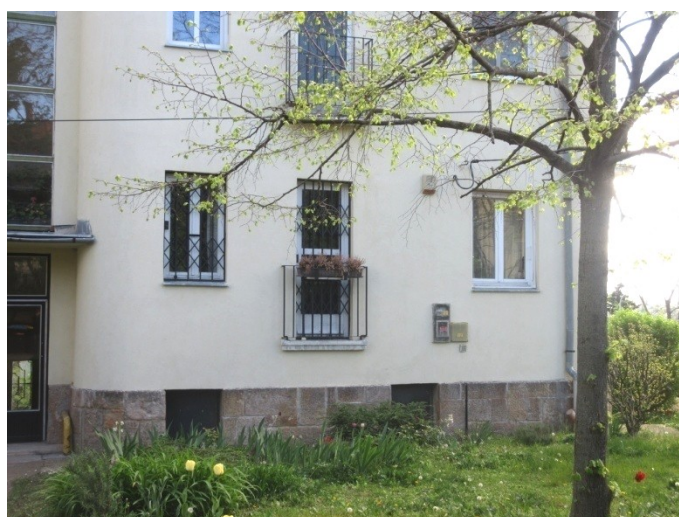
68.-70. A hátsó homlokzat földszinti szakaszának részletei – építéskori, történeti értékű kialakítás
