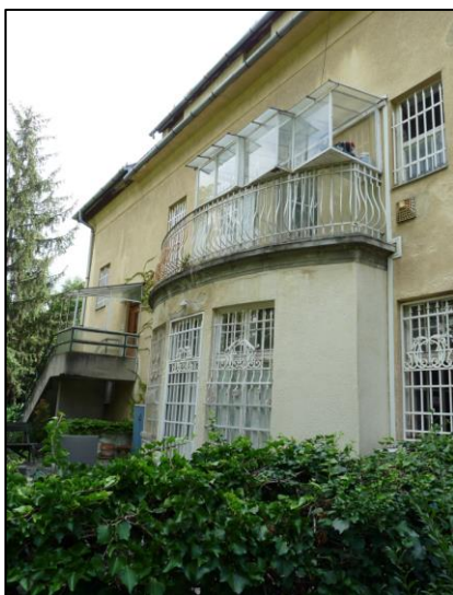
37. kép Északi homlokzat részlet
