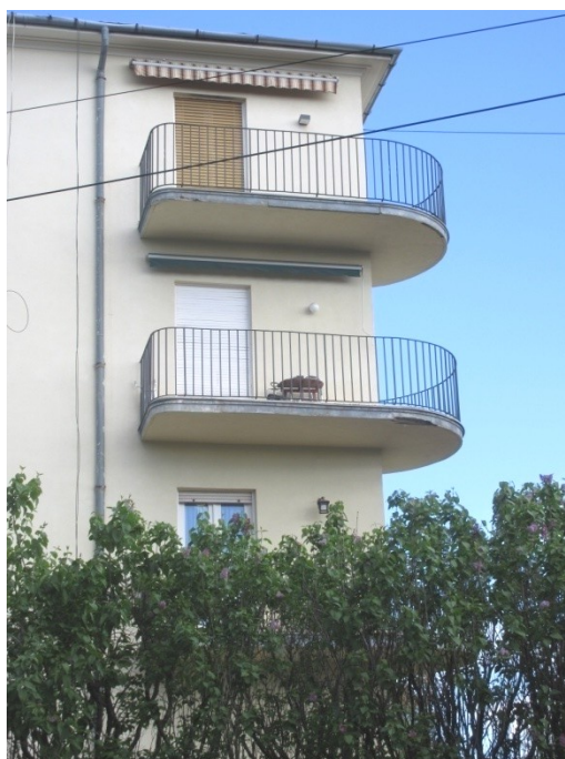
87.-89. A DK-i homlokzat függőleges tengelyeinek homlokzati szakaszai – a 3 tengelyes oldalhomlokzat kialakítása építéskori. Különösen értékes építészeti megoldás a 3. axisban álló erkélyek kialakítása, amelyek ívesen befordulnak a Stromfeld A. úti főhomlokzatra
