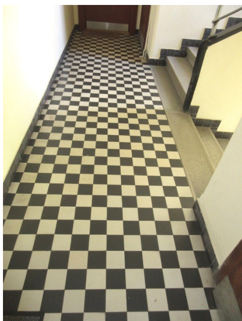
167.,168. A II. emeleti pihenő padlóburkolata és födeme – a fekete-fehér márványmozaik lapburkolat építéskori burkolat
