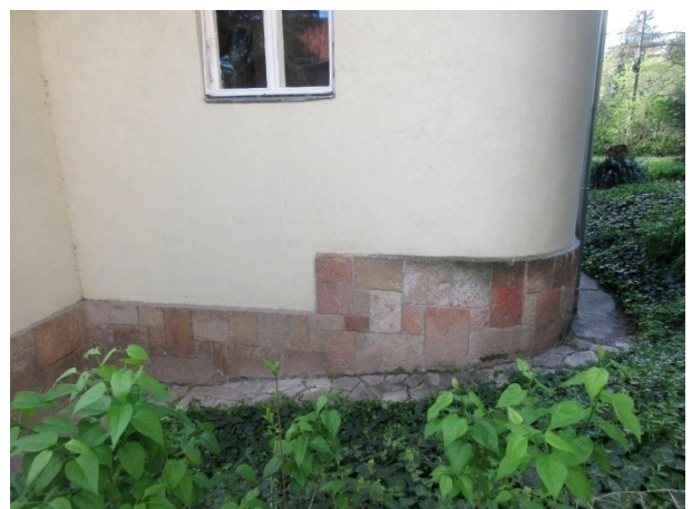
57.-62. Az oldalhomlokzat nyílászáróinak és lábázatának részletei – a terméskő lábázat és a nyíláskiosztások, valamint az erkélyek építéskori szerkezetek, a nyílászárók közül csak kevés építéskori maradt, legtöbbjük már újabb szerkezet
