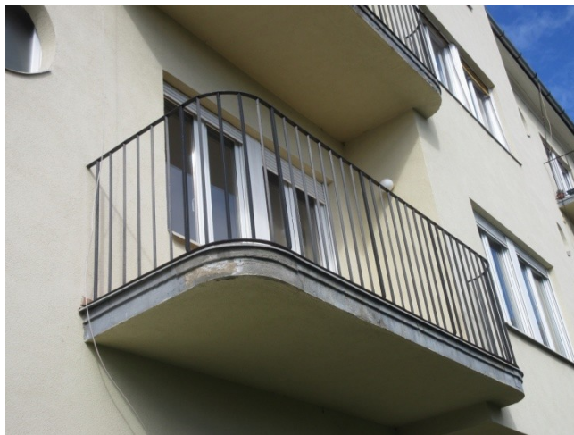
33.-36. A homlokzat bal (D-i) oldali szakaszának I. emeleti részlete - a nyíláskiosztások és erkélyek építéskoriak. A páros-ablak tokkerete eredeti, de a benne lévő fa nyílászáró újabb szerkezet. A körablak négyzetes nyílászárója és az erkélyre nyíló nyílászárók új szerkezetek
