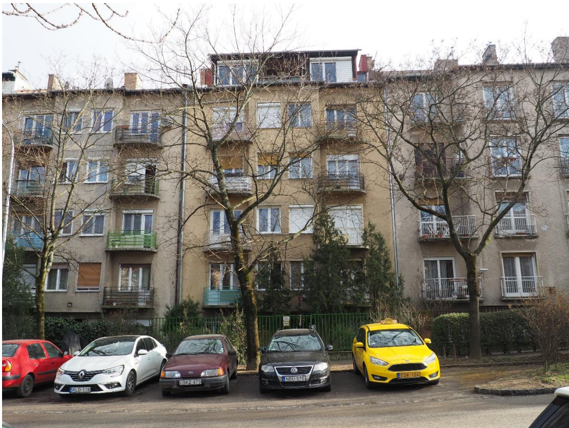
9. kép Németvölgyi út 32/B, 2021
