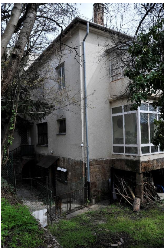
20. kép Az épület nyugati homlokzata, részlet
