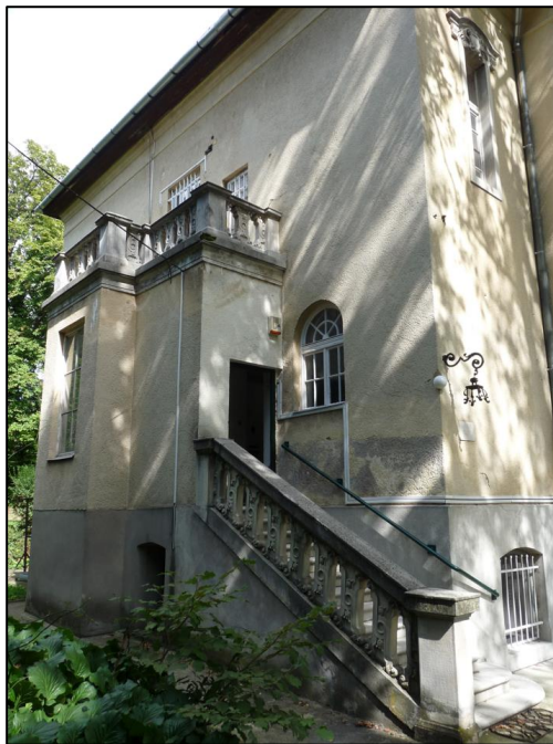
31. kép Keleti homlokzat részlet
