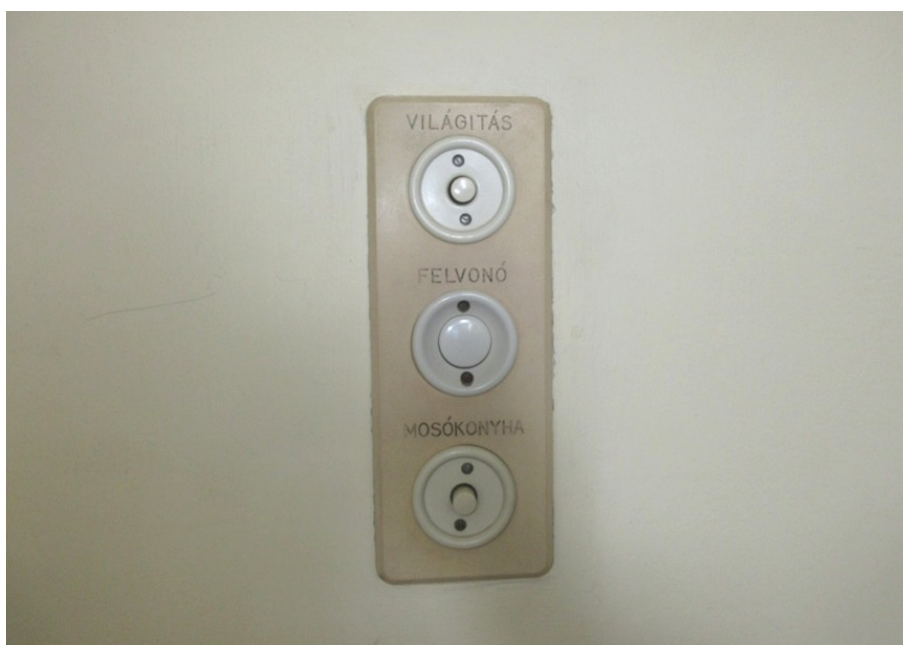
181.-183. A III. emeleti pihenő padlóburkolata és födéme, valamint az ÉK-i oldalfalon lévő hármaskapcsoló – a fekete-fehér márványmozaik lapburkolat és a kapcsoló építészeti elemek
