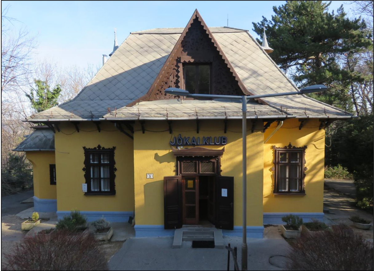
1. kép Főhomlokzat az utca (délnyugat) felé
