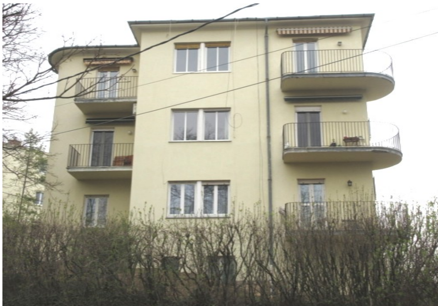
A Levendula utcai oldalhomlokzat nézete
