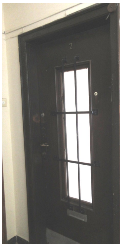
151.-153. Az ÉNy-i oldalfalon lévő tároló-ajtók, valamint az ÉK-i oldalfalon nyíló lakásbejáratú ajtó – eredeti építéskori, történeti értékű nyílászárók
