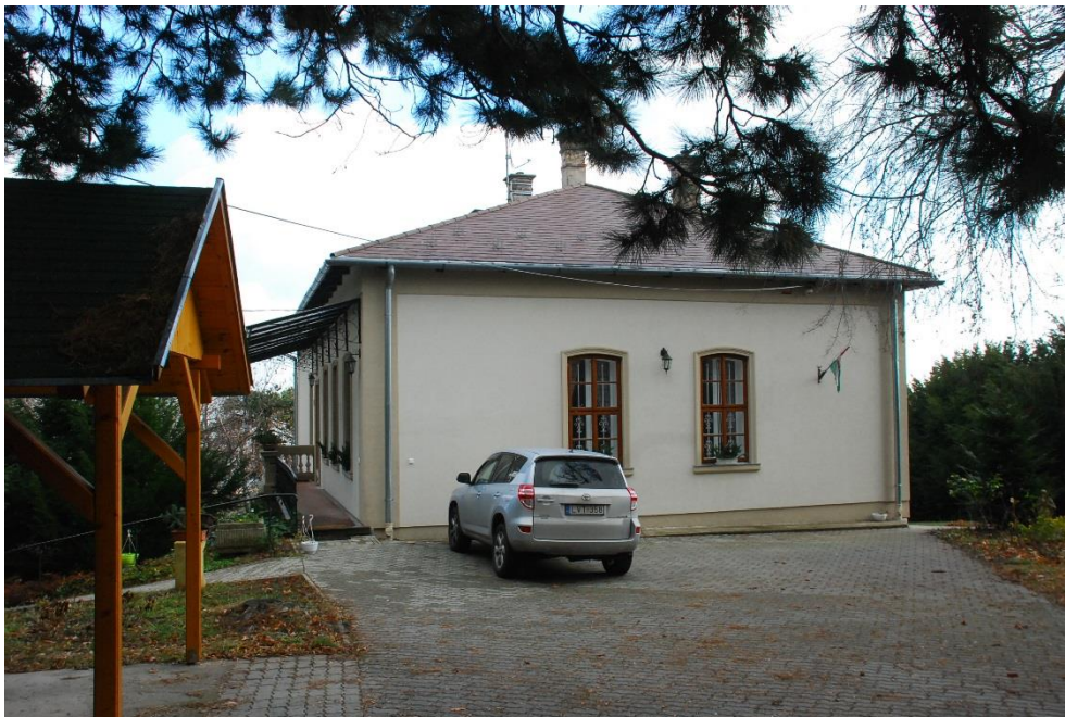
Nézet a hátsó homlokzat felől, 2018
