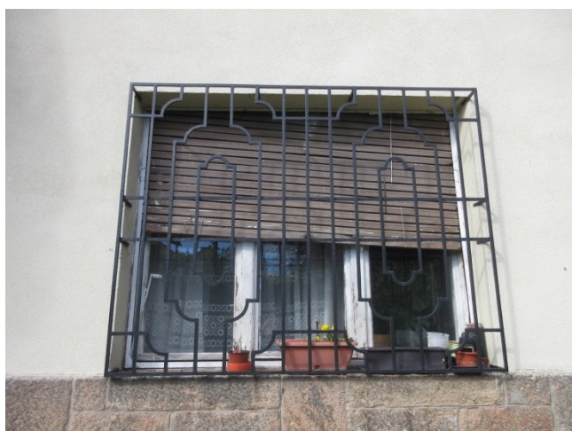
30.-32. A földszinti bal (D-i) homlokzati szakasz nézete és a földszinti ablakok részletei – a nyíláskiosztások és tokkeretek építéskoriak. Az 1. tengelyben álló háromosztatú ablak eredeti építéskori fa nyílászáró. A 2. és 3. tengelyben álló három- és egyosztatú ablak tokkerete építéskori, de a bennük lévő nyílászárók már újabb műanyag szerkezetűek. A rácsok eredetiek, történeti értékűek
