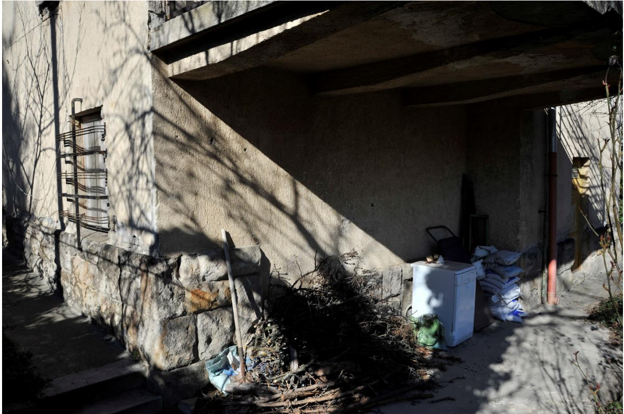
30. kép Délkeleti homlokzat pinceszinti szakasza
