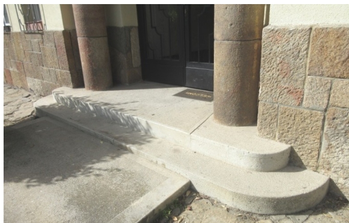
19.-23. A bejáratú kapuzat nézetei és az elő-lépcső részlete - a kapu két oldalát szegélyező hengeres kőoszlopok, a terméskő lábazat és a műkö elő-lépcső építészeti, történelmi értékű szerkezetek
