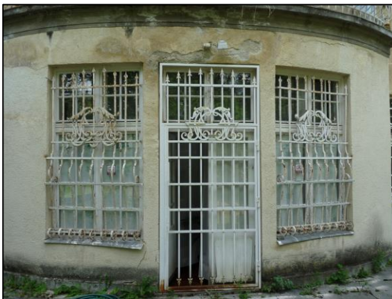
42. kép Északi homlokzat részlet
