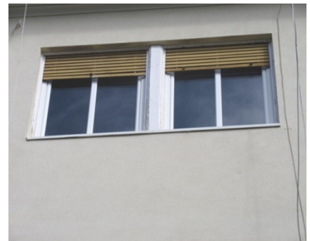
94.-96. A 2. tengely I. II. és III. emeleti ablakainak a részletei – az I. emeleti ablak építéskori, a II. és III. emeleti ablakok nyílászárói már újabb szerkezetek, de osztásukban illeszkednek az eredeti nyílászárókhoz
