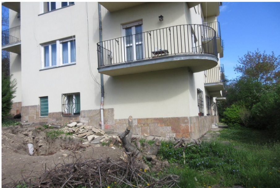
99. A DK-i oldalhomlokzat lábazati része – a lépcsőzetes kialakítású rusztikus terméskő burkolat eredeti építéskori, történeti értékű burkolat
