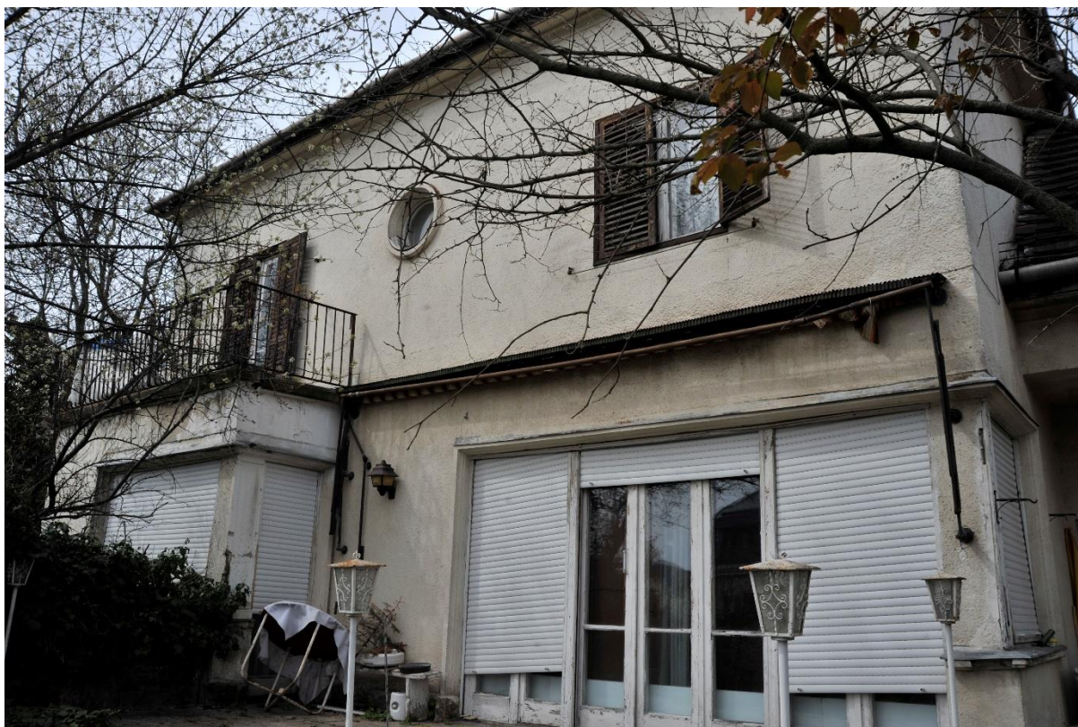
13. kép Keleti homlokzat, részlet
