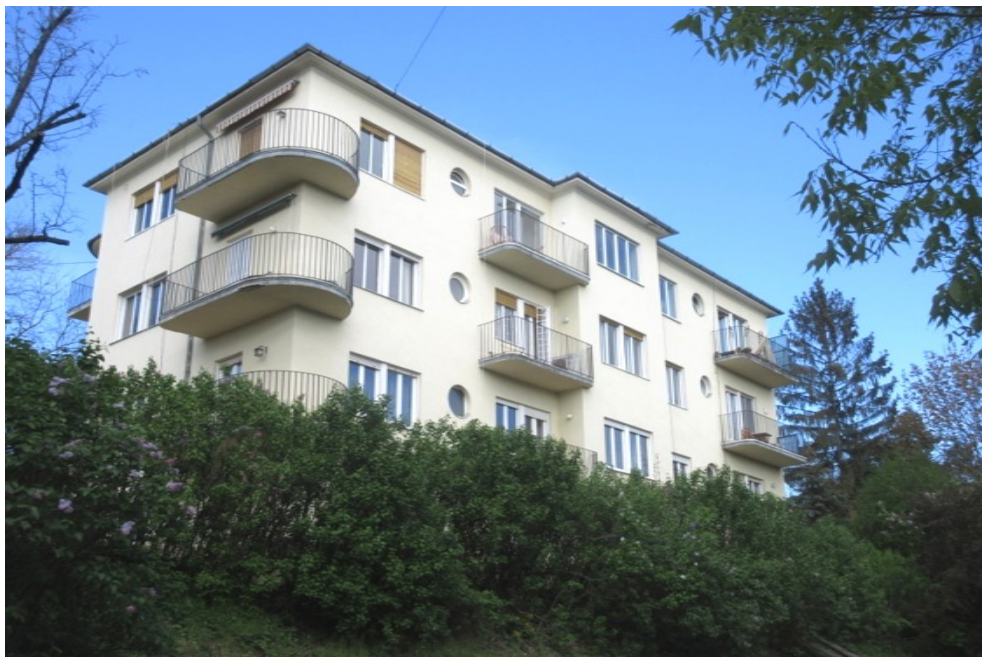
2. Az épület Levendula utcai (DK-i) és Stromfeld úti (ÉK-i) homlokzatának nézete - lejtős terepen elhelyezkedő, szabadon álló, téglány alaprajzú, földszint + két-, ill. háromemeletes, lapostetős, modern stílusú (Bauhaus) lakóház. Az épület 1941-43-ban Somogyi György tervei szerint épült, Horovitz Richard és Neje megbízásából
