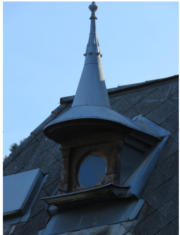
27. kép Padlásszellőző az északnyugati oldalon
