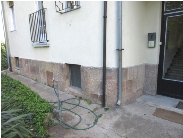
71.,72. A hátsó homlokzat ívesen kialakított terméskő lábazatának részletei - történeti értékű kialakítás
