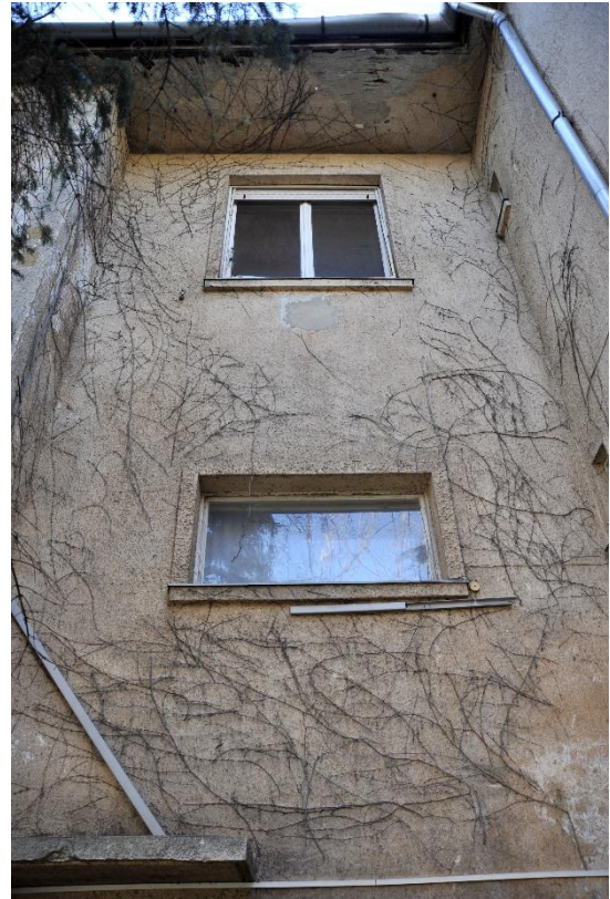
15. kép Északkeleti homlokzat, részlet
