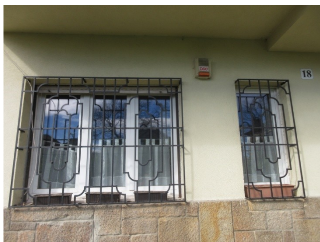
30.-32. A földszinti bal (D-i) homlokzati szakasz nézete és a földszinti ablakok részletei – a nyíláskiosztások és tokkeretek építéskoriak. Az 1. tengelyben álló háromosztatú ablak eredeti építéskori fa nyílászáró. A 2. és 3. tengelyben álló három- és egyosztatú ablak tokkerete építéskori, de a bennük lévő nyílászárók már újabb műanyag szerkezetűek. A rácsok eredetiek, történeti értékűek
