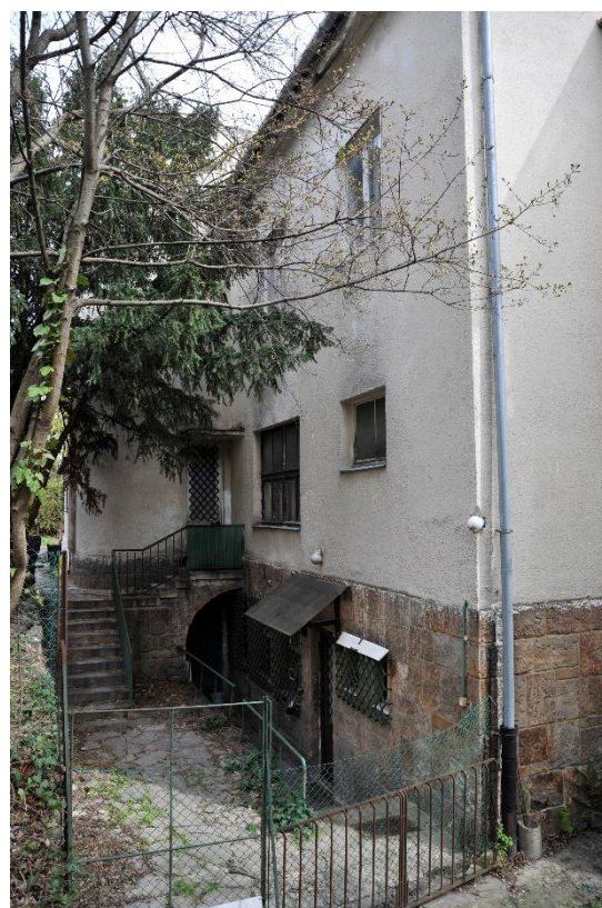
21. kép Az épület nyugati homlokzata, részlet
