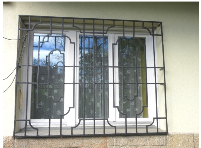
40.-42. A földszinti jobb (É-i) homlokzati szakasz nézete és a földszinti ablakok részletei – a nyíláskiosztások és tokkeretek építéskoriak. Az 5. és 6. tengelyben álló egy- és háromosztatú ablak tokkerete eredeti, de a bennük lévő nyílászárók új szerkezetek. A 7. tengelyben álló háromosztatú ablak tokkerete és nyílászárója új műanyag szerkezet. A rácsok eredetiek, történelmi értékűek
