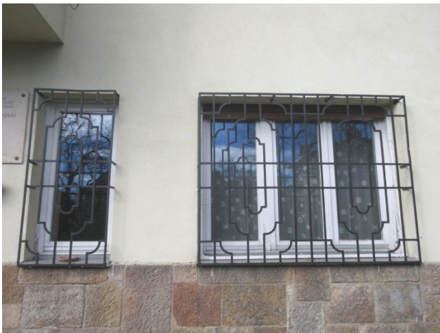
40.-42. A földszinti jobb (É-i) homlokzati szakasz nézete és a földszinti ablakok részletei – a nyíláskiosztások és tokkeretek építéskoriak. Az 5. és 6. tengelyben álló egy- és háromosztatú ablak tokkerete eredeti, de a bennük lévő nyílászárók új szerkezetek. A 7. tengelyben álló háromosztatú ablak tokkerete és nyílászárója új műanyag szerkezet. A rácsok eredetiek, történelmi értékűek
