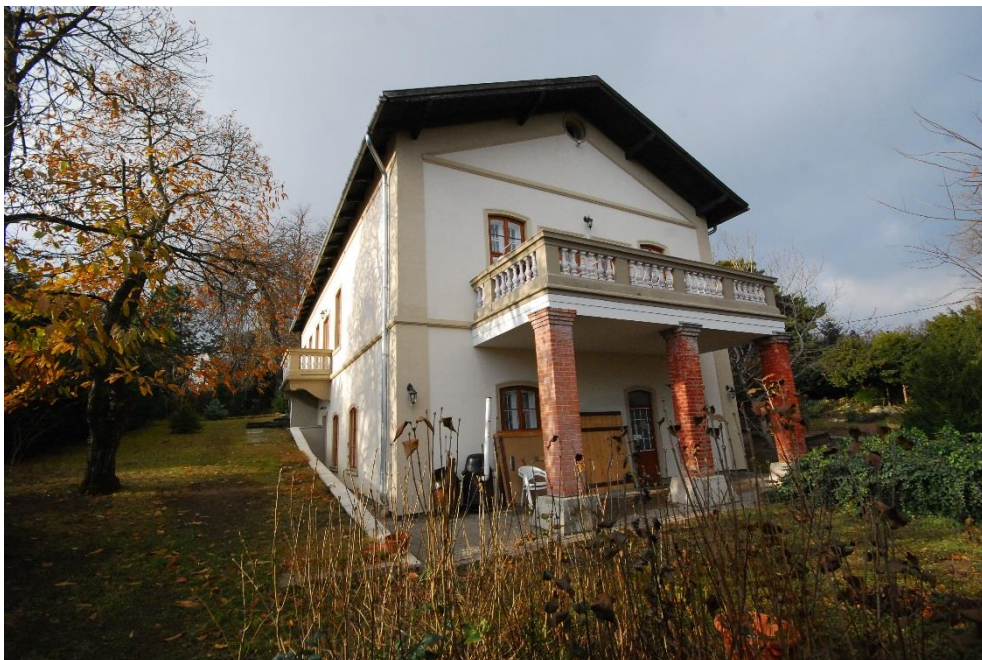
A főhomlokzat és a déli homlokzat mai állapotában, 2018.
