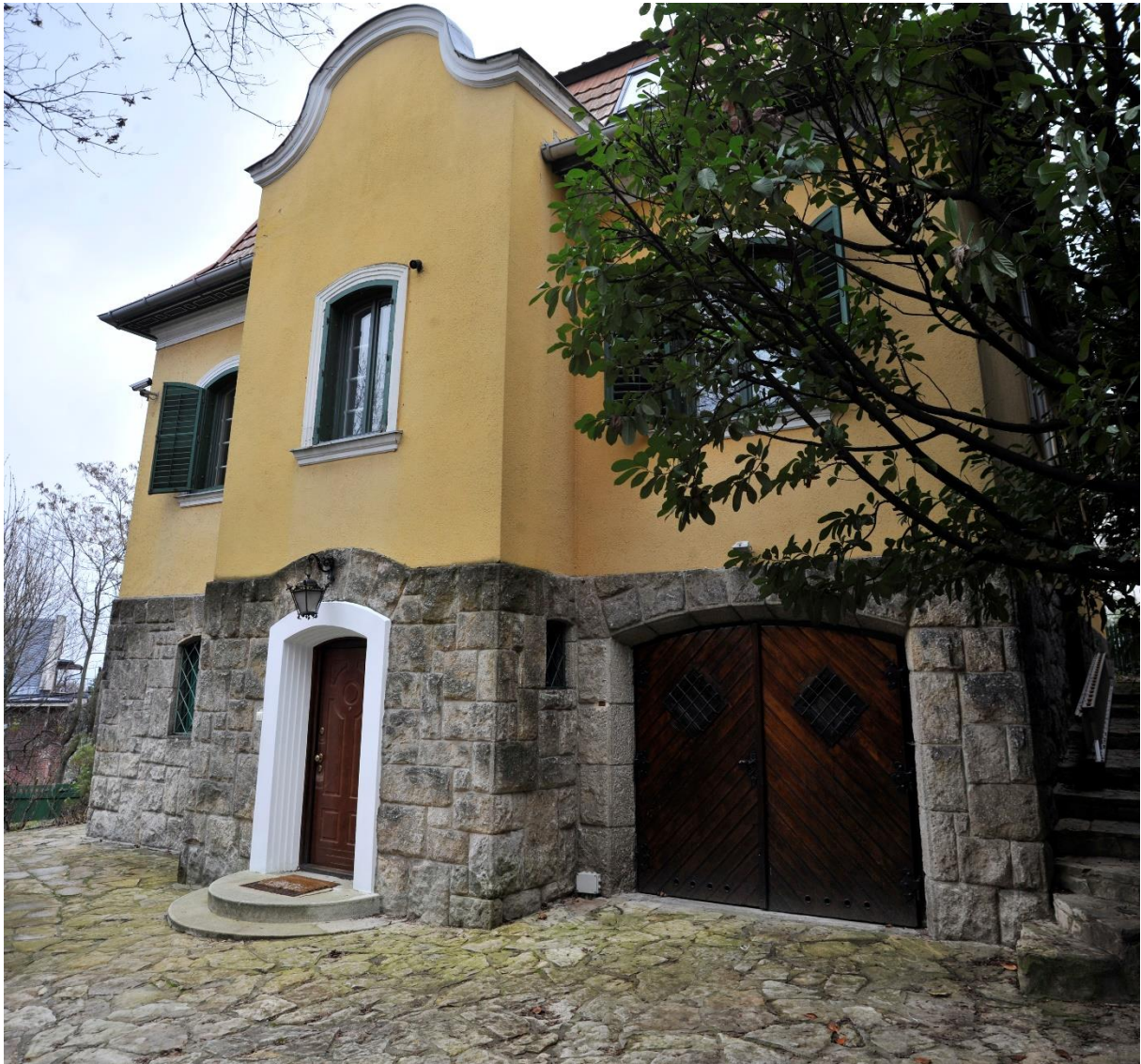
8. kép Északi homlokzat, összkép
