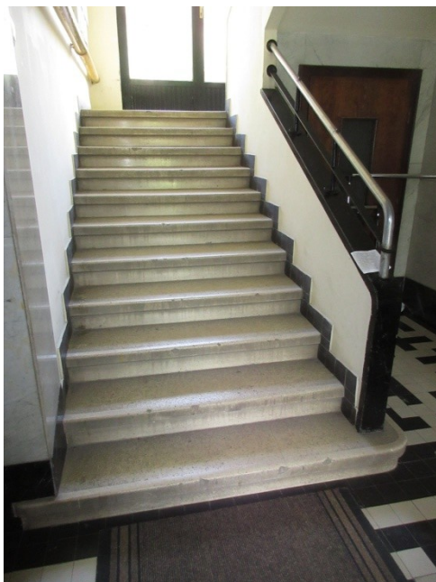
141.-144. A földszintről az I. emeletre (magasföldszintre) induló lépcsőkar nézetei és a lépcső részletei – a kétkarú, fémcső kapaszkodóval határolt tömör falazott mellvédes, műkö lépcsőfokos lépcső eredeti építéskori szerkezet
