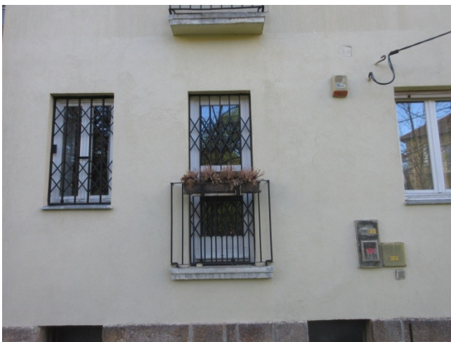
73.-76. Földszinti ablakok és farnciaerkély-ajtó, valamint a pinceablak részlete – a nyílások építéskoriak, de a bennük lévő nyílászárók már újabb szerkezetek, a francia-erkély korlátja eredeti elem
