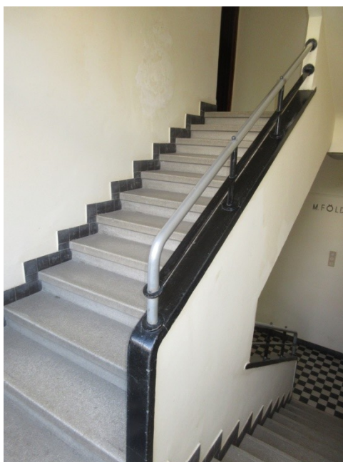
158.-160. A II. emeletre haladó lépcsőkar és a lépcsőforduló pihenője – a lépcső és az udvari fém- üveg nyílászáró eredeti építéskori, történeti értékű szerkezetek
