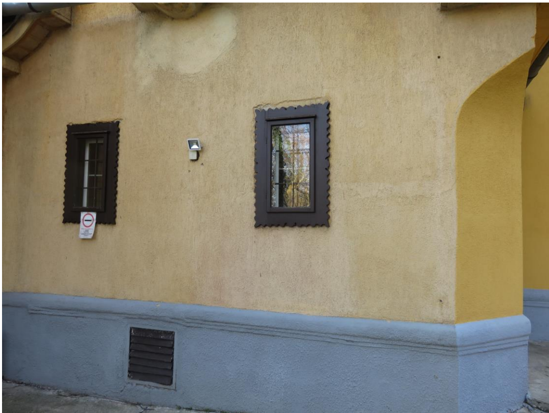
9. kép A villaépület nyugati homlokzata, részlet
