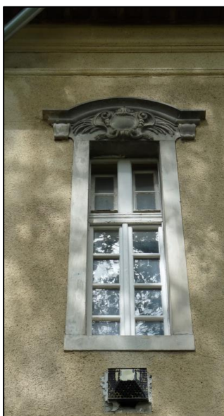
57. kép Nyílászáró részlet
