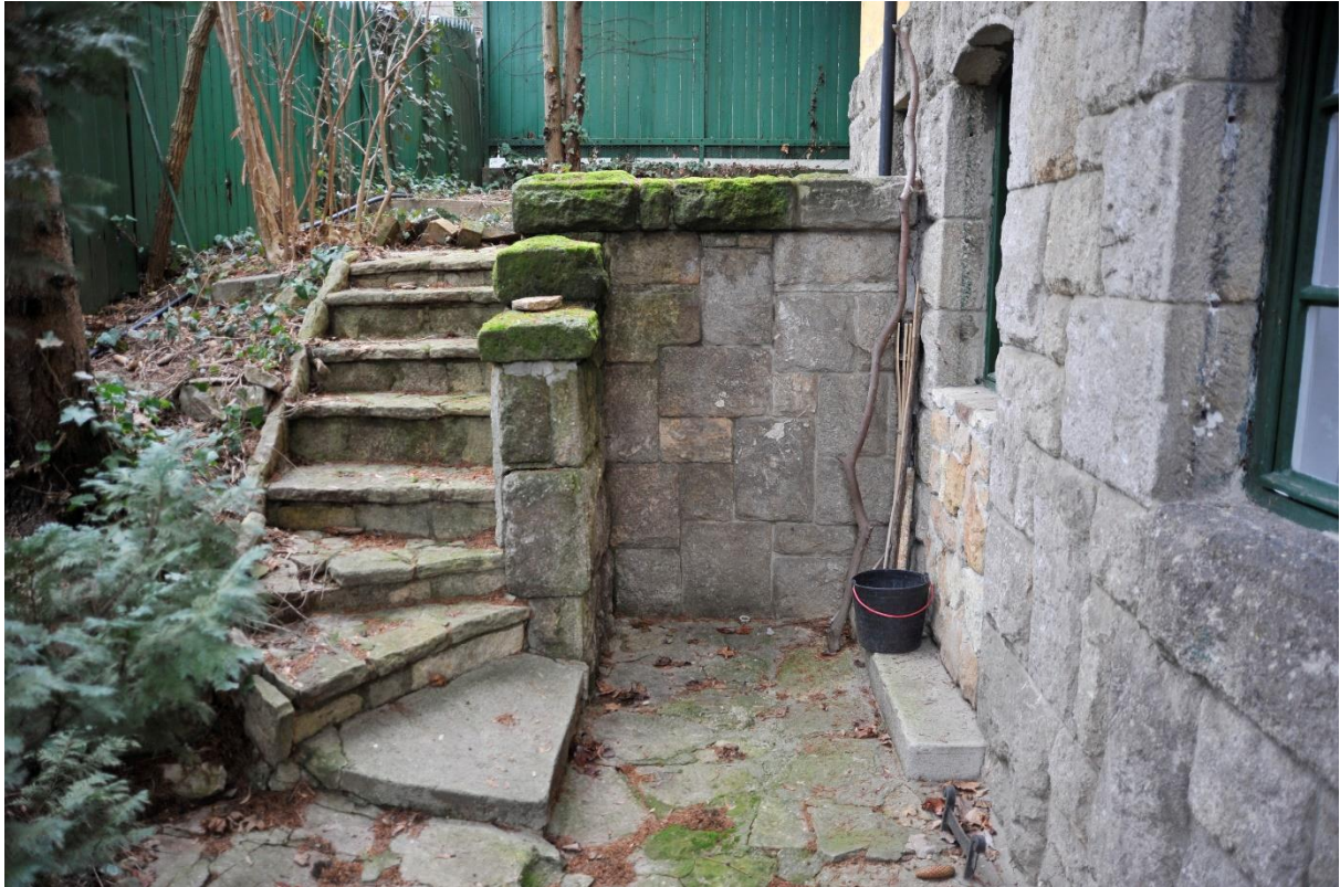
16. kép Támfal és lépcső az épület déli homlokzata előtt
