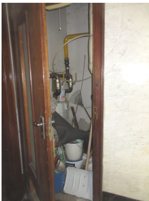
136.-138. A földszinti pihenő DK-i és ÉNy-i oldalfalán nyíló folyosók, amelyek a tárolókba vezetnek, valamint a DNy-i oldalfalon lévő tároló, ahol egykor a lakóház személyliftje volt – eredeti építéskori, történeti értékű kialakítás és nyílászárók, a DK-i folyosó burkolata új, az ÉNy-i részben eredeti
