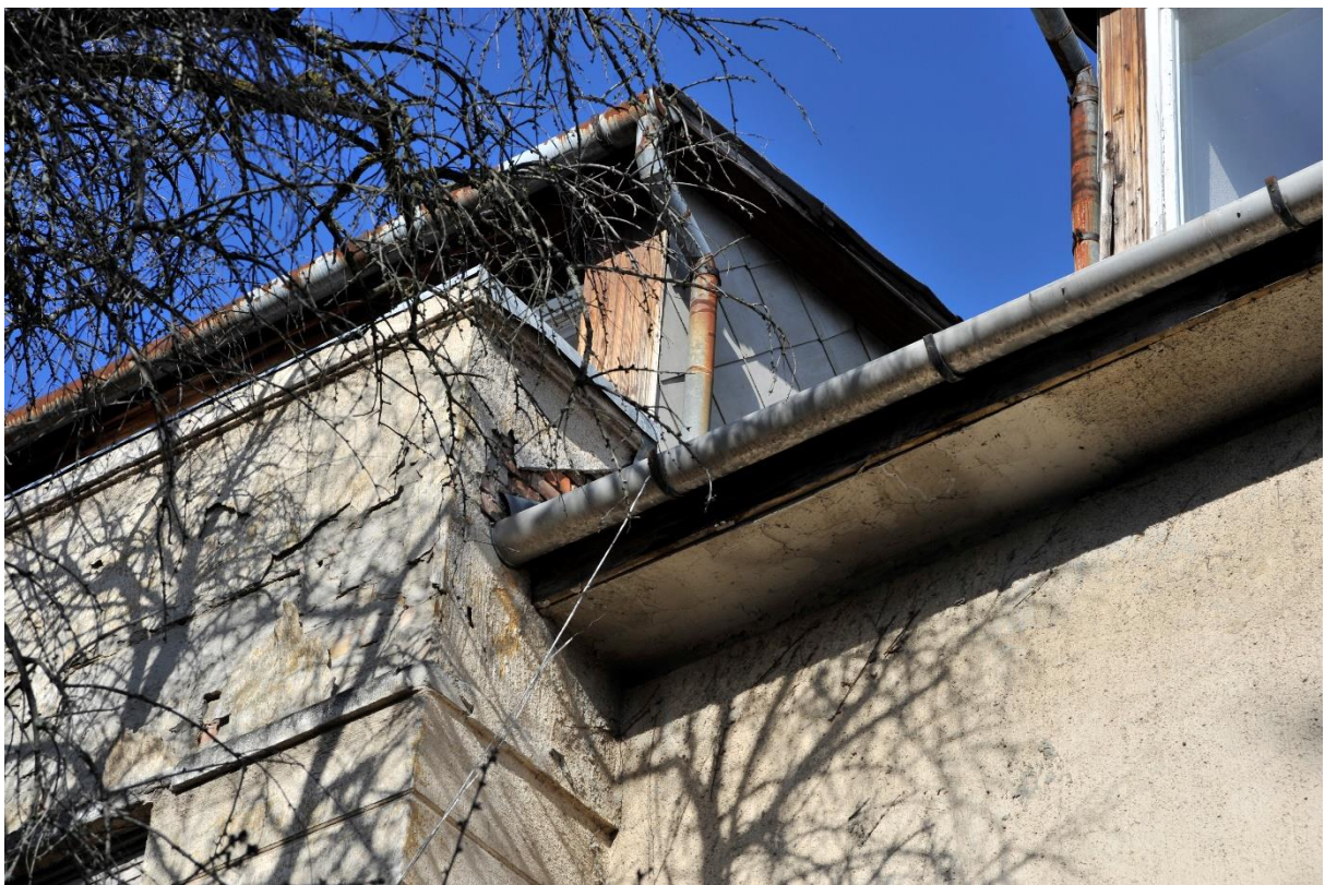
37. kép Eresz és vonal mentén visszahúzott zárópárkány a délnyugati homlokzaton
