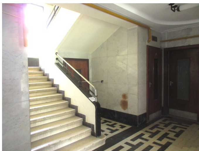
115.-117. A földszinti lépcsőházi pihenő DNY-i oldalfalának nézetei – eredeti építéskori kialakítás, szerkezetek és burkolatok
