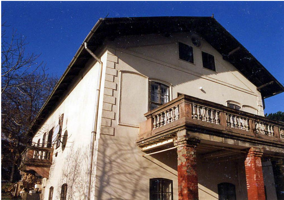
A főhomlokzat és a déli homlokzat a hőszigetelés előtt, 2001-ben.
