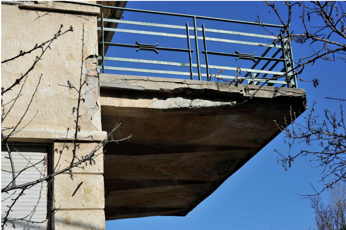
28. kép Szerkezeti problémák az emeleti erkélyen
