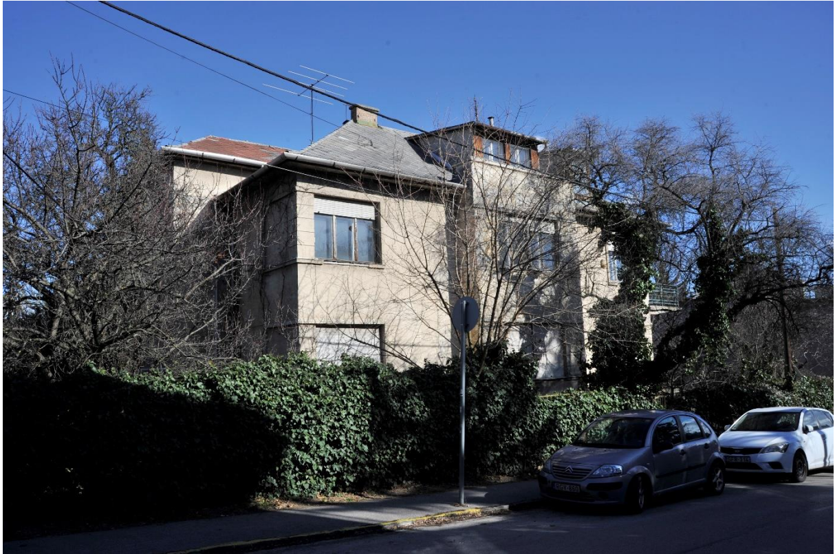
9. kép Az épület nyugat felől
