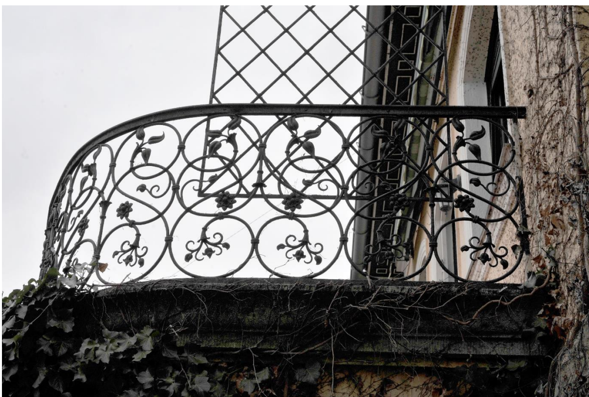
10. kép Teraszkorlát, keleti homlokzat
