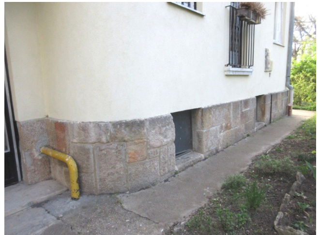
71.,72. A hátsó homlokzat ívesen kialakított terméskő lábazatának részletei - történeti értékű kialakítás
