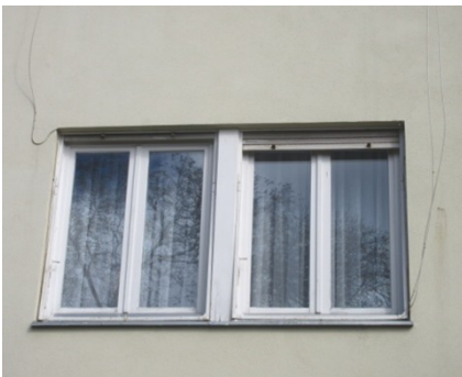
94.-96. A 2. tengely I. II. és III. emeleti ablakainak a részletei – az I. emeleti ablak építéskori, a II. és III. emeleti ablakok nyílászárói már újabb szerkezetek, de osztásukban illeszkednek az eredeti nyílászárókhoz
