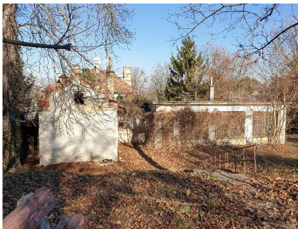
Az ingatlanon álló egyéb épületek
