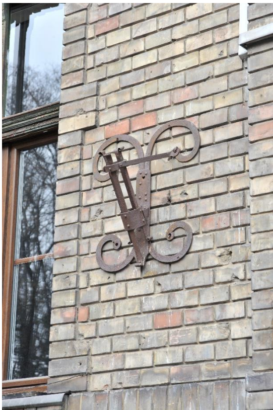
12. kép Zászlórúd-tartó a főhomlokzaton
