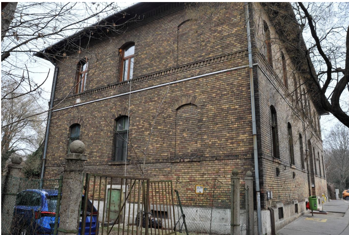
16. kép Nyugati homlokzat
