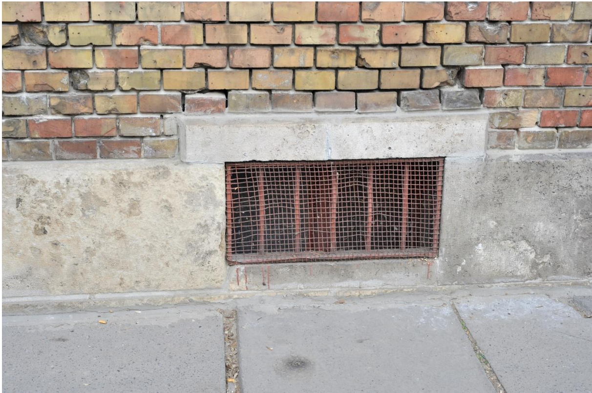
11. kép Mészkö lábázat és pincszellőző
