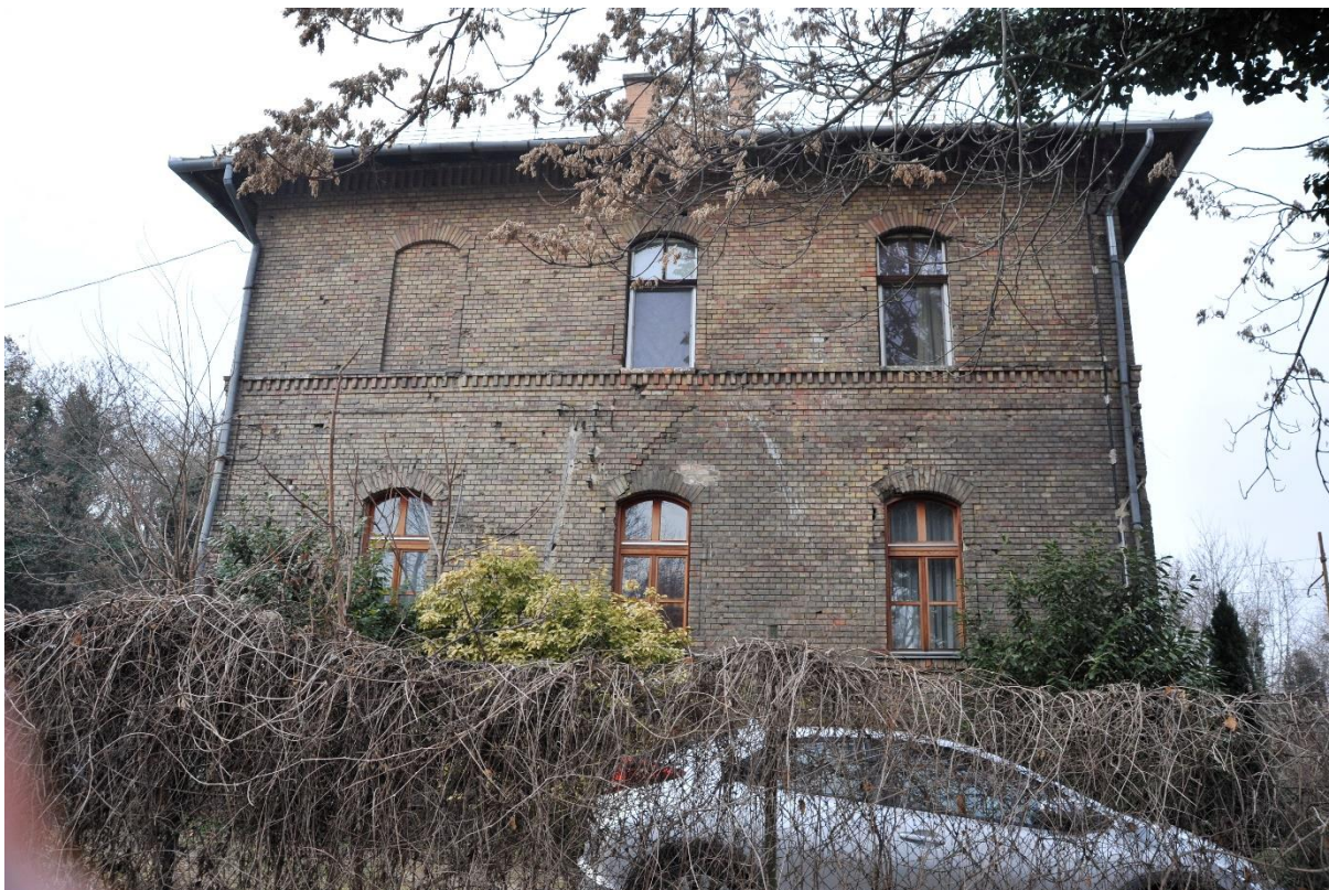
13. kép Keleti homlokzat
