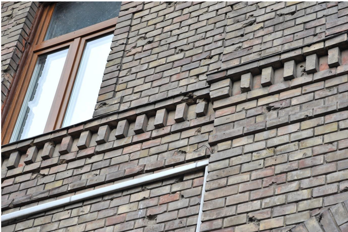
3. kép Osztópárkány a déli homlokzaton, részlet
