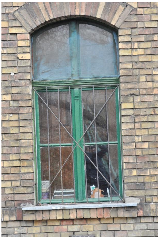
17. kép Építés-korabeli ablak a nyugati homlokzaton
