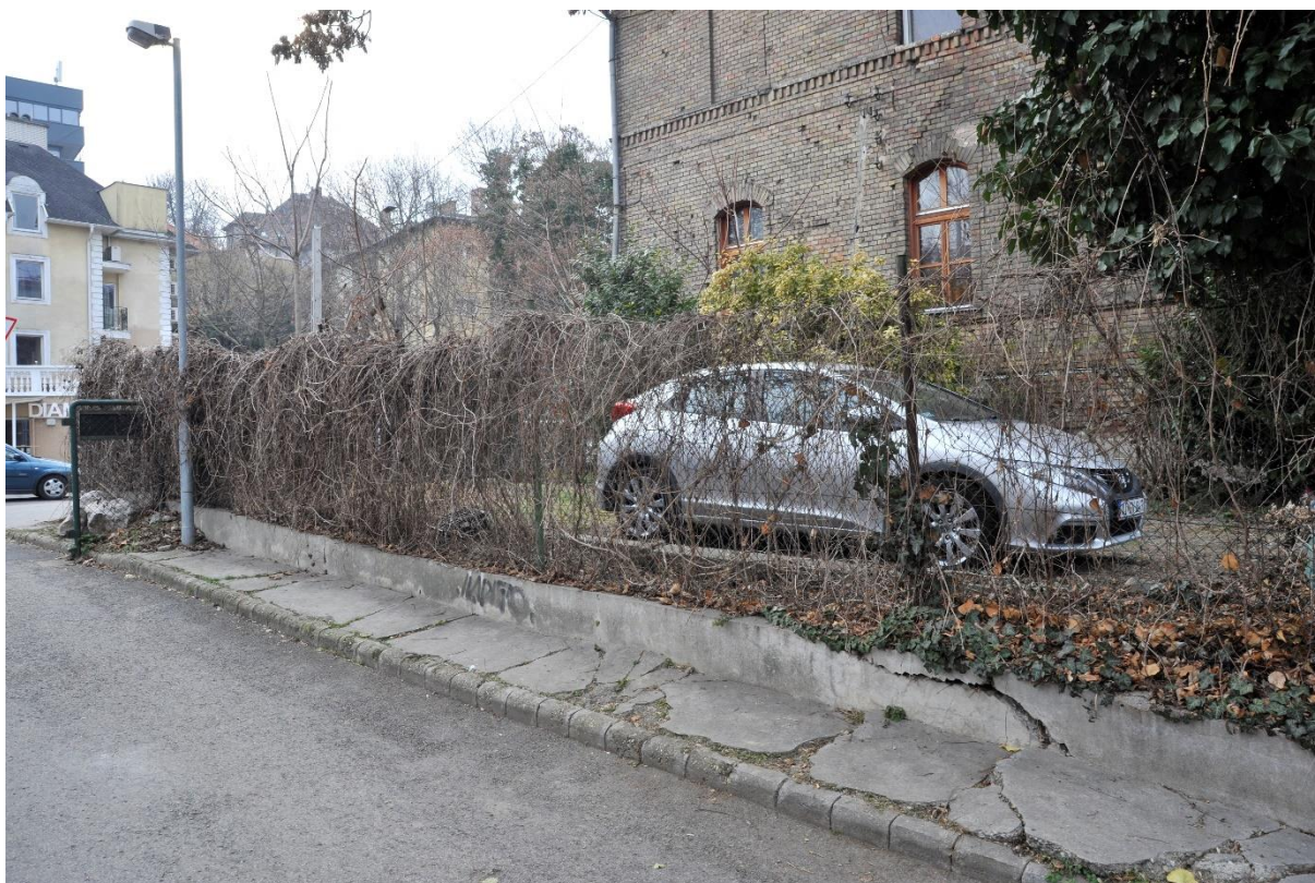
25. kép Kerítés az épület keleti homlokzata előtt
