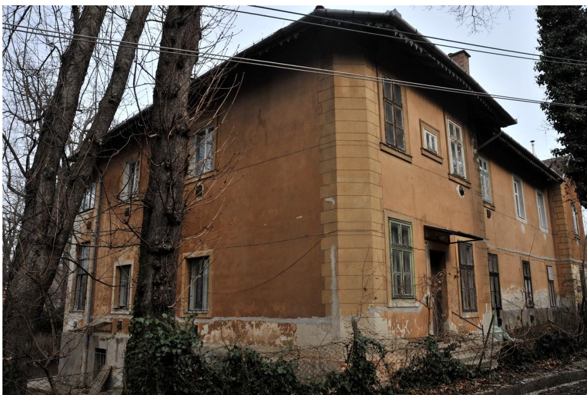
21. kép Az épület nyugat felől
