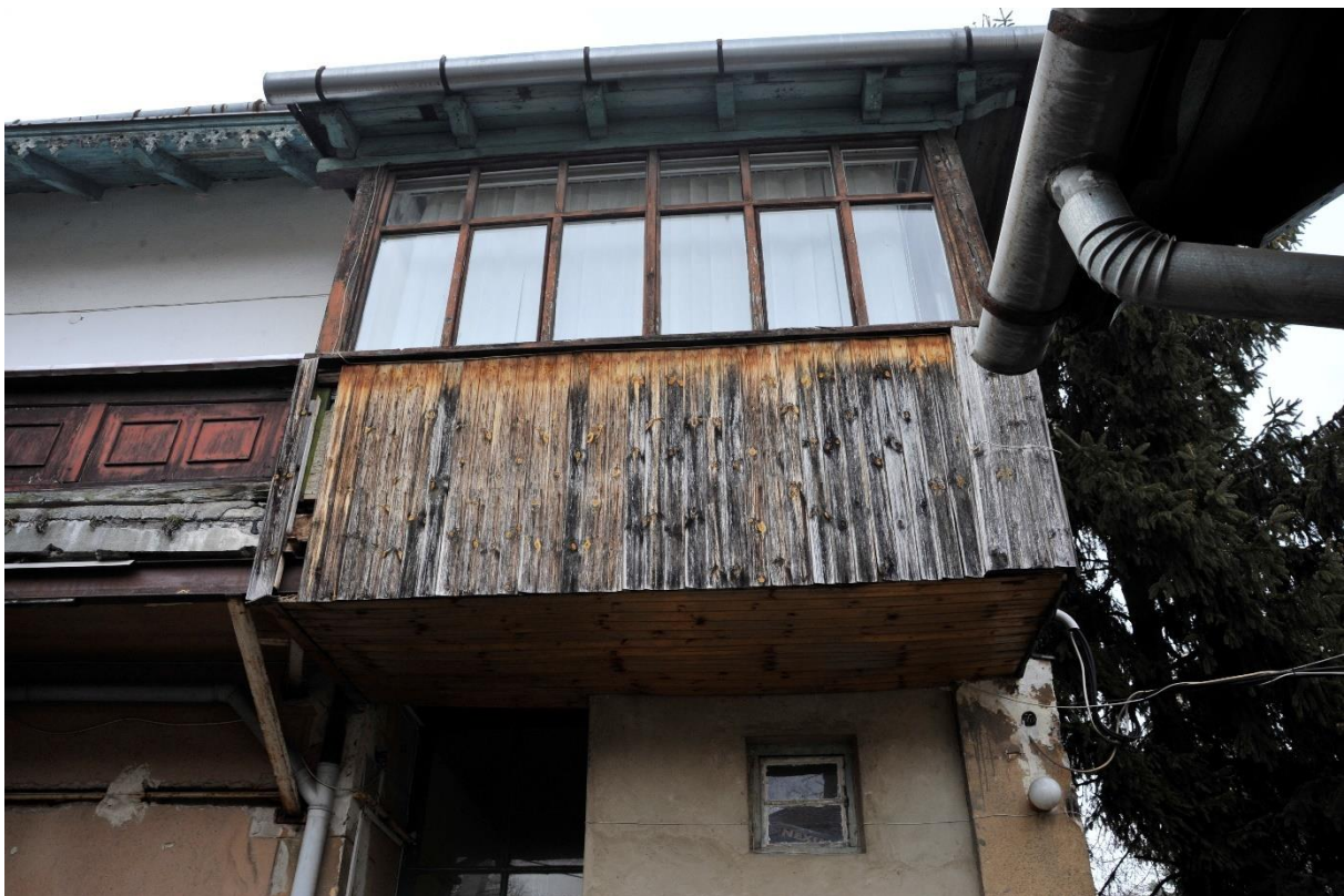
45. kép Délkeleti homlokzat, emelet
