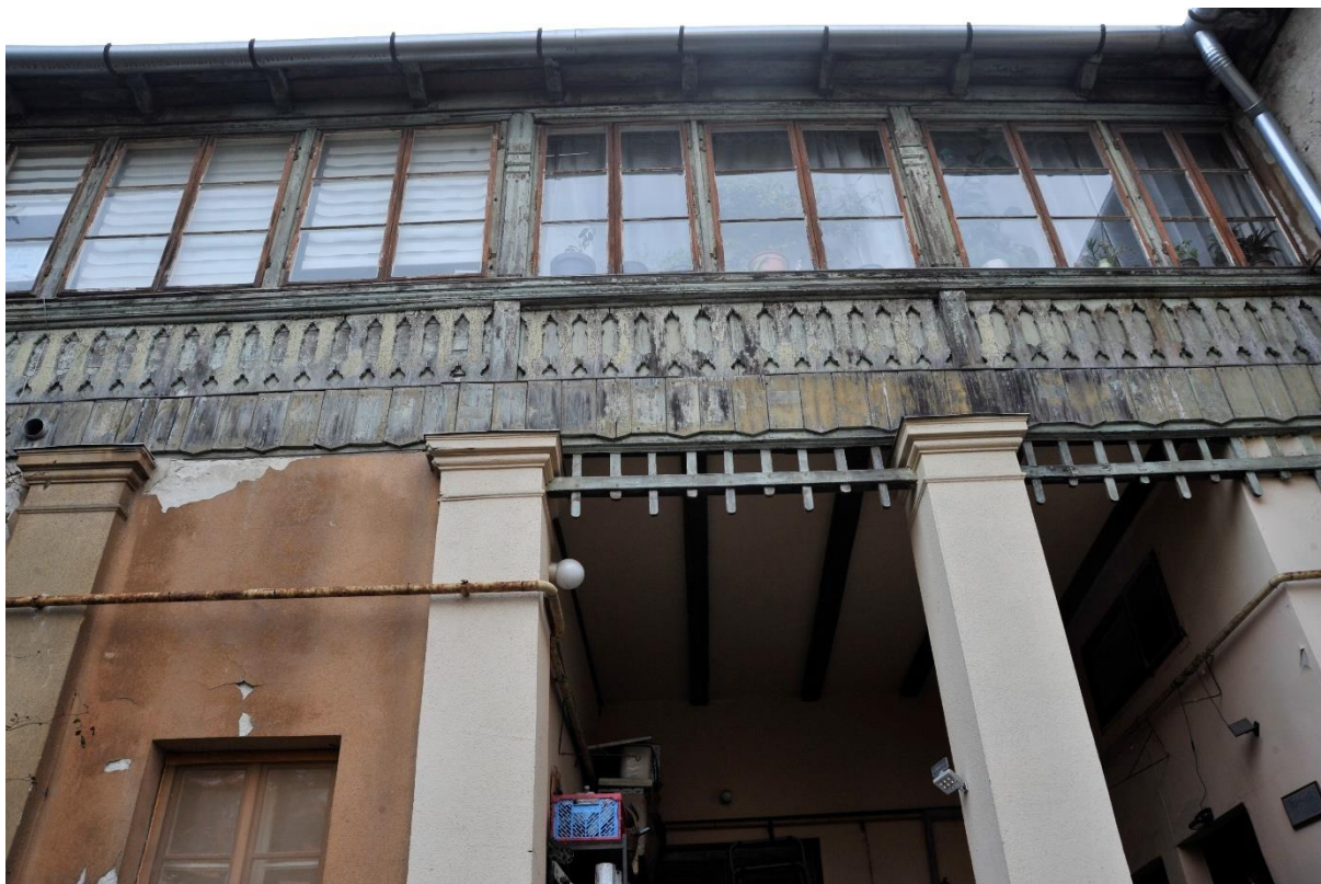
36. kép Északkeleti homlokzat emeleti szakasza
