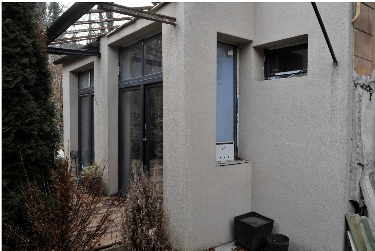
48. kép Délkeleti homlokzat, déli rész, földszint
