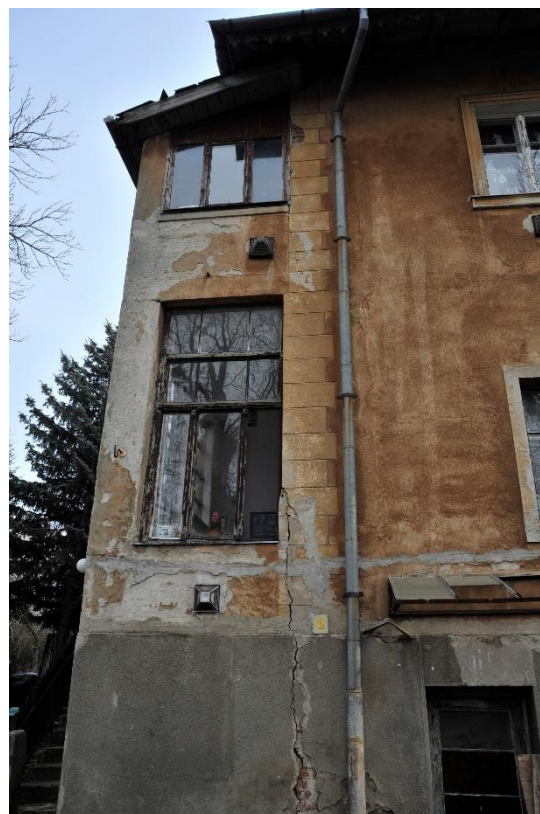
26. kép Északnyugati homlokzat északi szakasza
