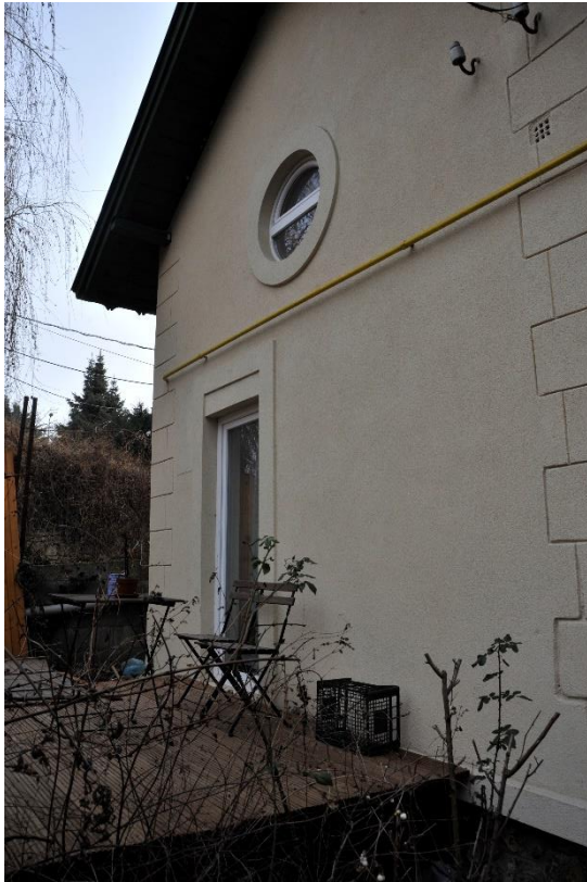
50. kép Melléképület, északkeleti homlokzat
