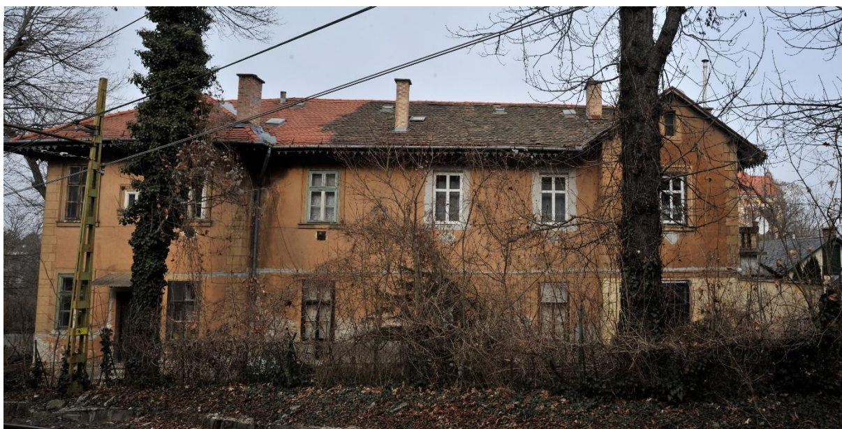
9. kép Délnyugati homlokzat a fogaskerekű vasút felől, összkép
