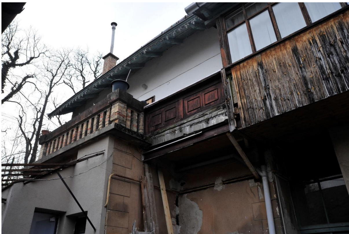
43. kép Délkeleti homlokzat, emelet
