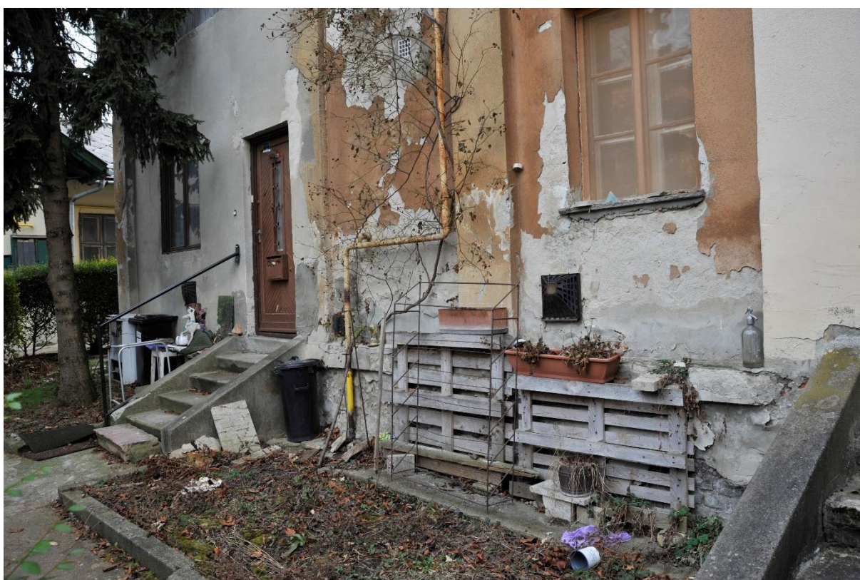
41. kép Az északkeleti homlokzat nyugat felől, részlet
