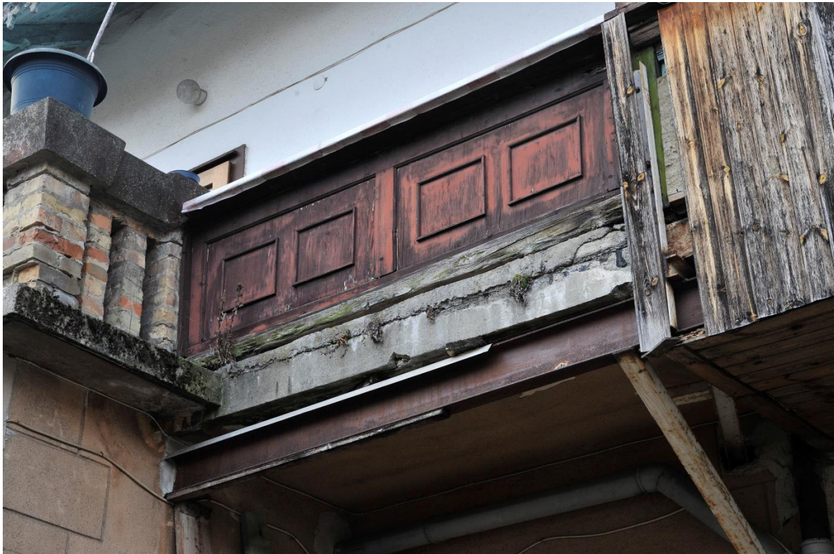
44. kép Délkeleti homlokzat, emelet
