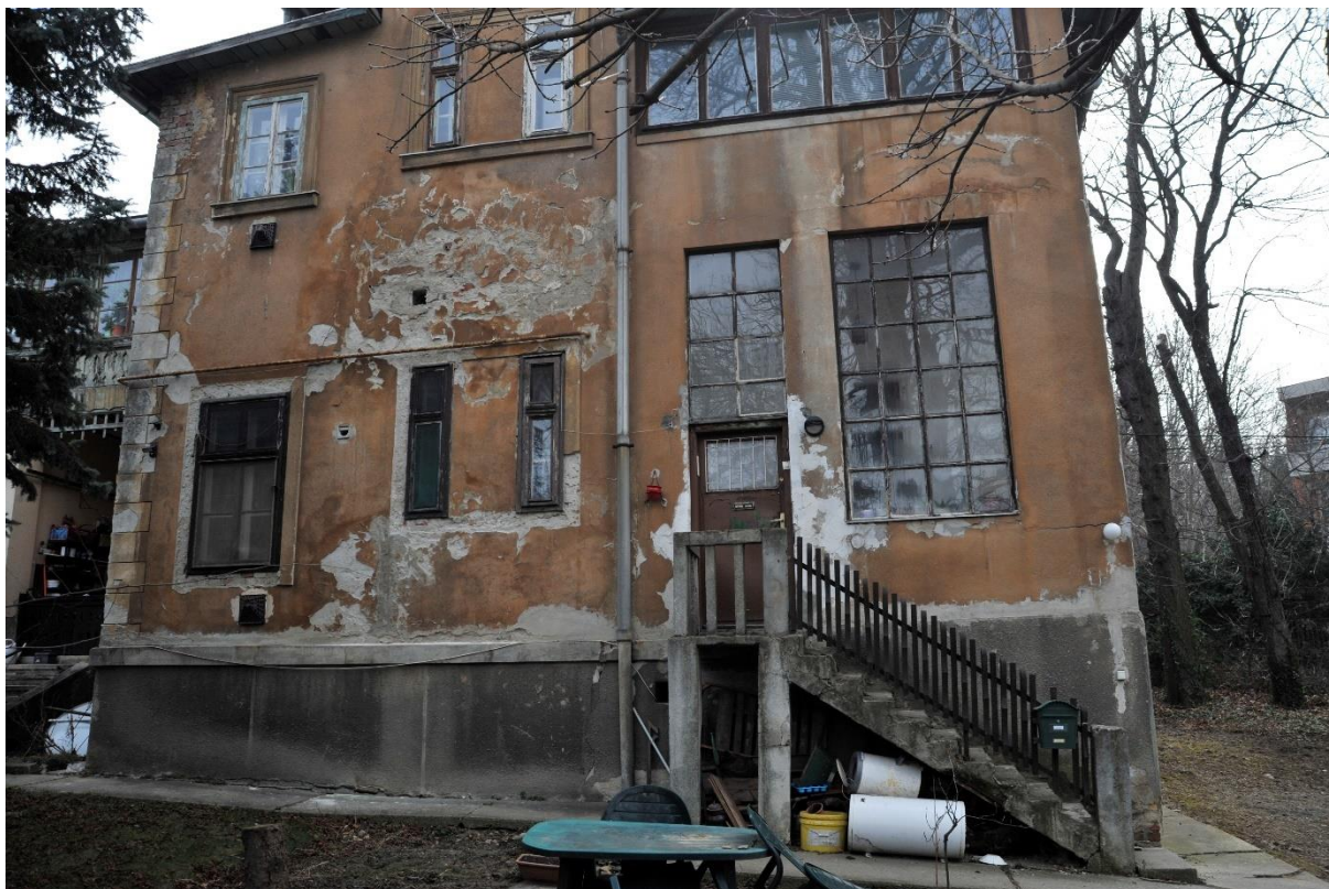
29. kép Északkeleti homlokzat északi szakasza
