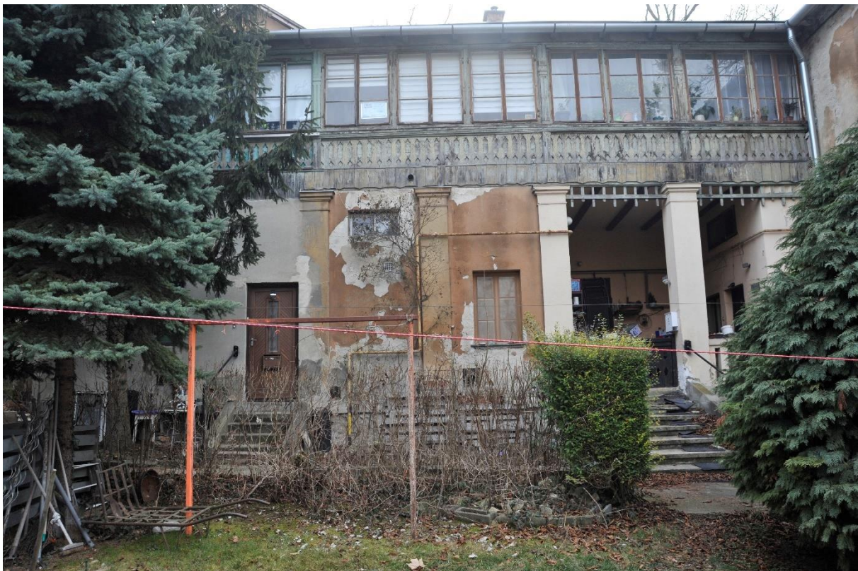
35. kép Északkeleti homlokzat középrésze
