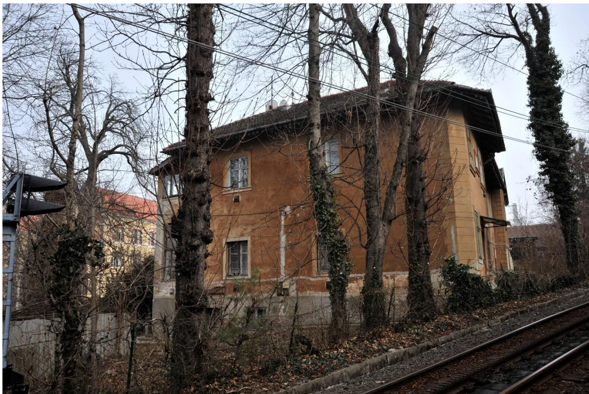
20. kép Északnyugati homlokzat a fogaskerekű vasút felől
