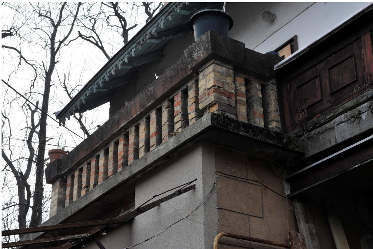
42. kép Délkeleti homlokzat, emelet
