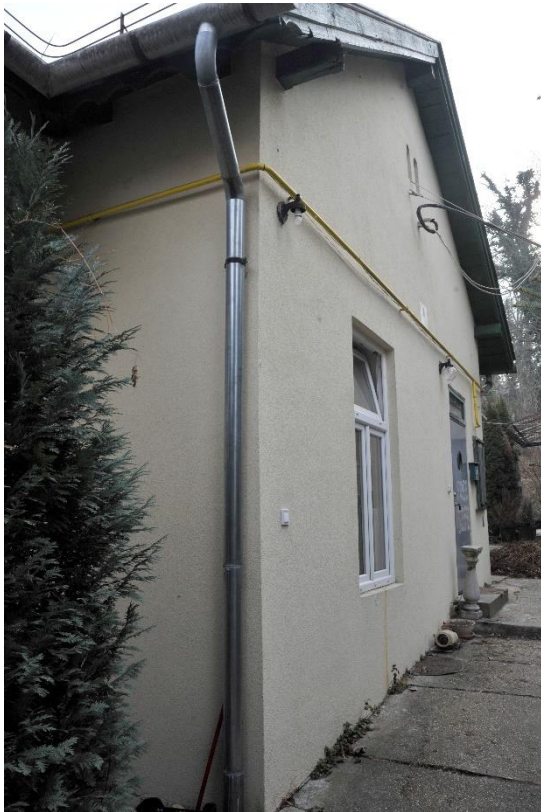
53. kép Melléképület, északnyugati homlokzat, középrész
