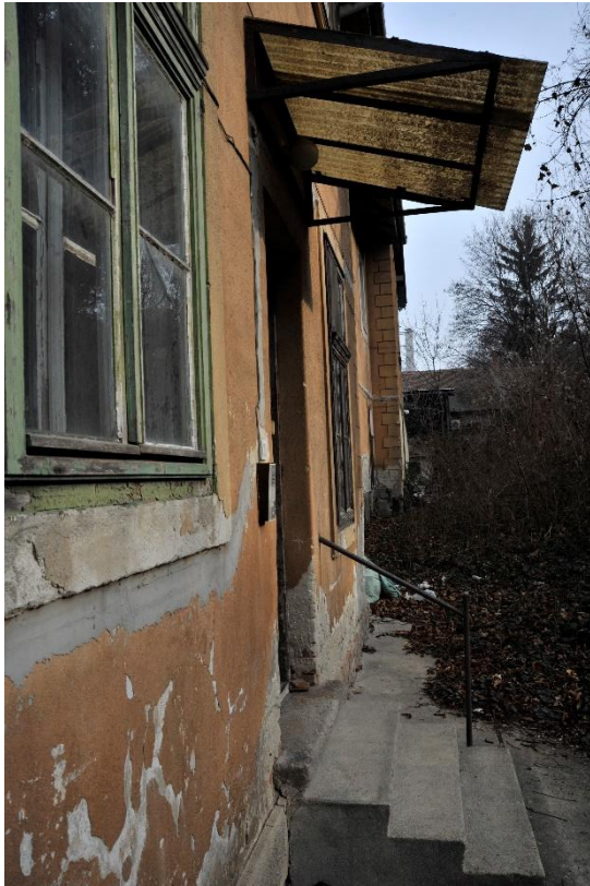
10. kép Délnyugati homlokzat az udvartól
