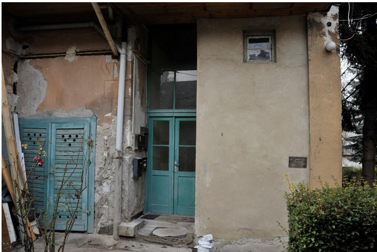
46. kép Délkeleti homlokzat, földszint
