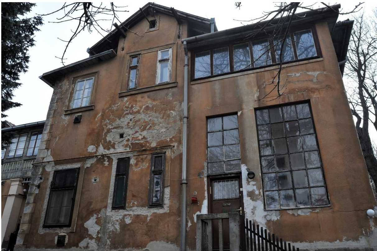
28. kép Északkeleti homlokzat északi szakasza
