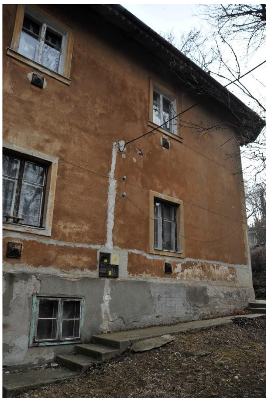
24. kép Északnyugati homlokzat felső szakasza
