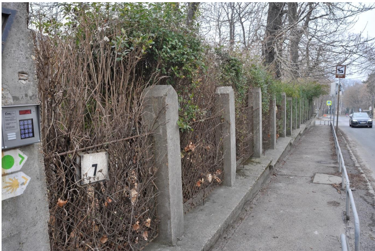
61. kép Kerítés a Költő utca felől
