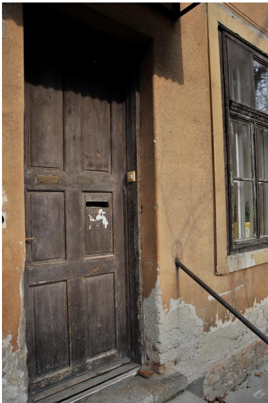
11. kép Bejárat ajtó a délnyugati homlokzaton
