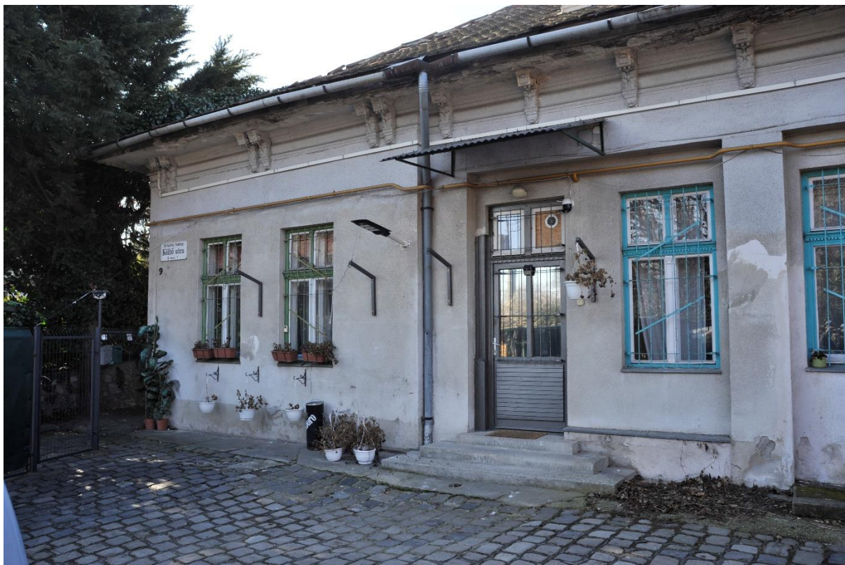
18. kép Északi homlokzat bal oldal
