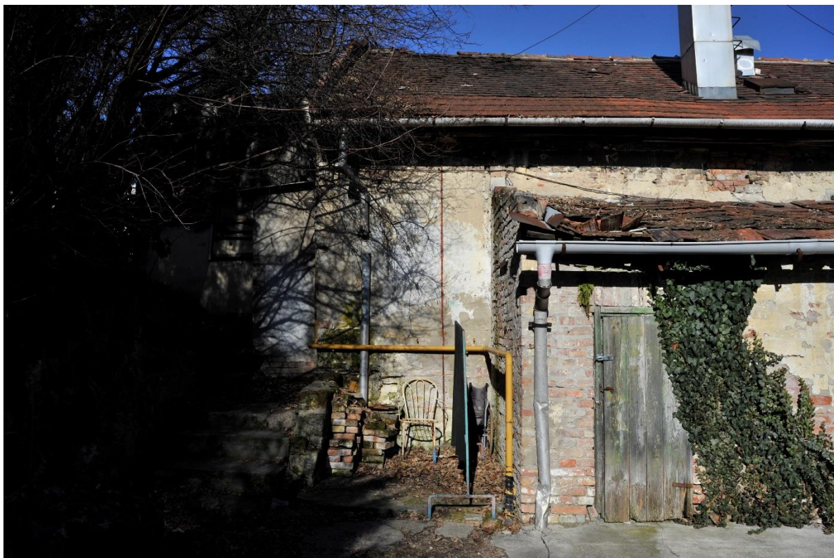
36. kép Belső udvar, keleti homlokzat, részlet
