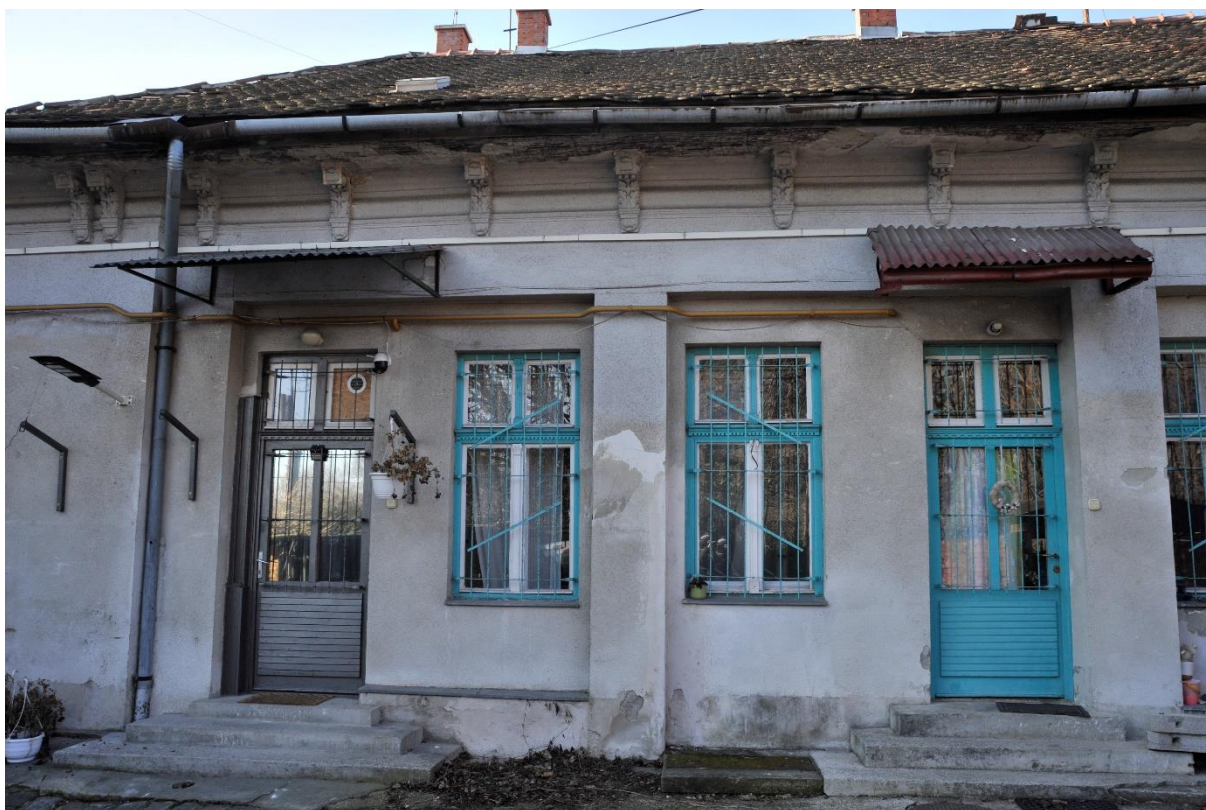
19. kép Északi homlokzat, középső szakasz
