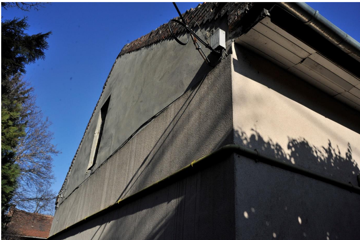
33. kép Déli homlokzat keleti szakasza, oromfal
