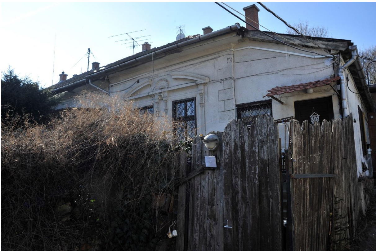
25. kép Északi homlokzat, jobb oldali szakasz
