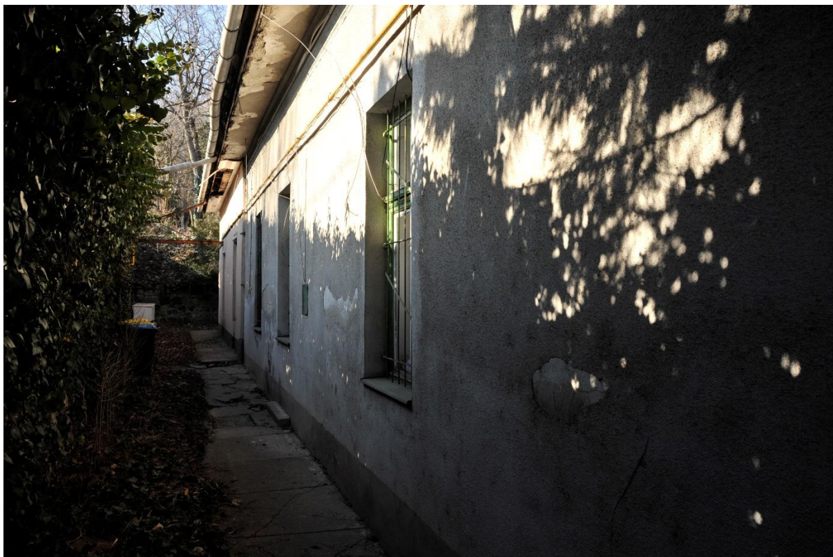
29. kép Keleti homlokzat
