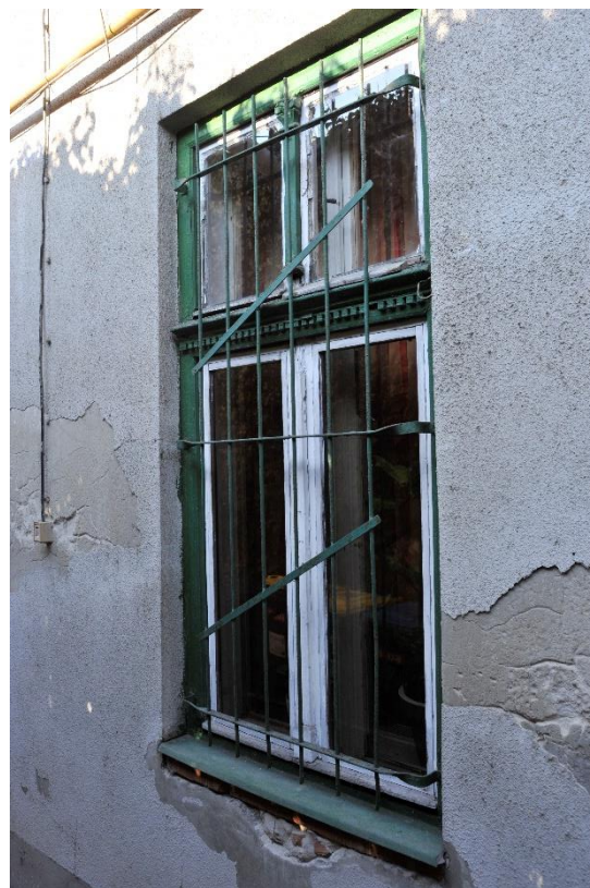
31. kép Ablak a keleti homlokzaton
