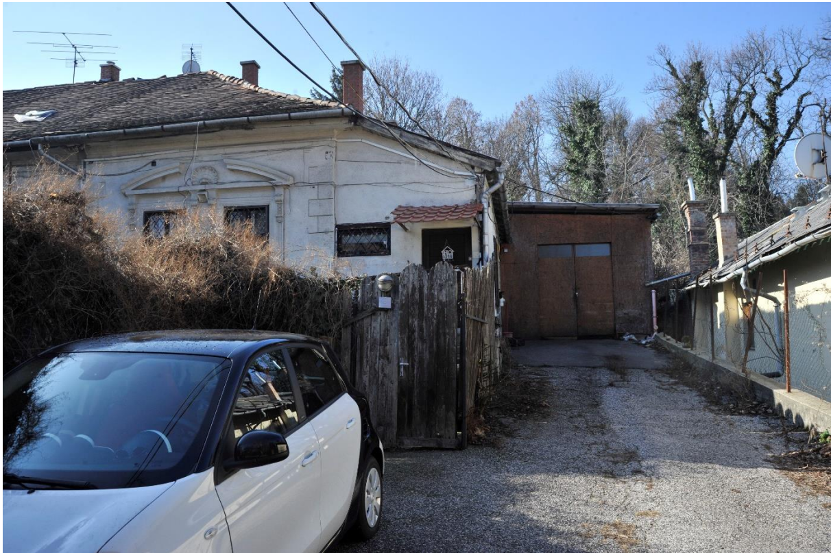
24. kép Az épület nyugati oldalának megközelítése
