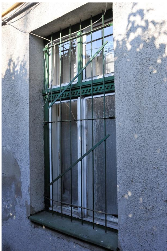
30. kép Ablak a keleti homlokzaton
