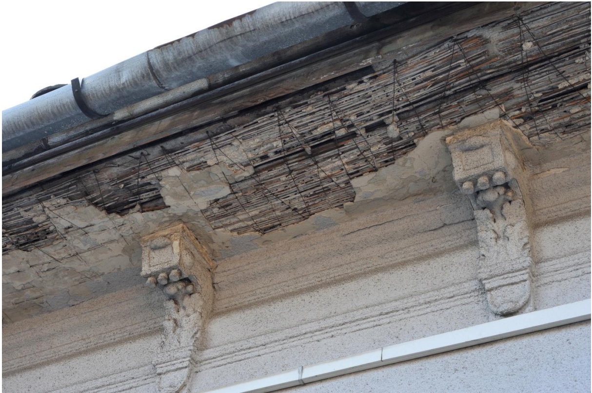
22. kép Északi homlokzat eresz és konzolok
