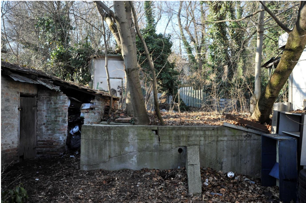
44. kép Melléképület, hátsó (déli) kert, betontámfal
