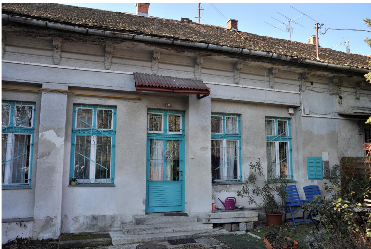
20. kép Északi homlokzat, középső szakasz
