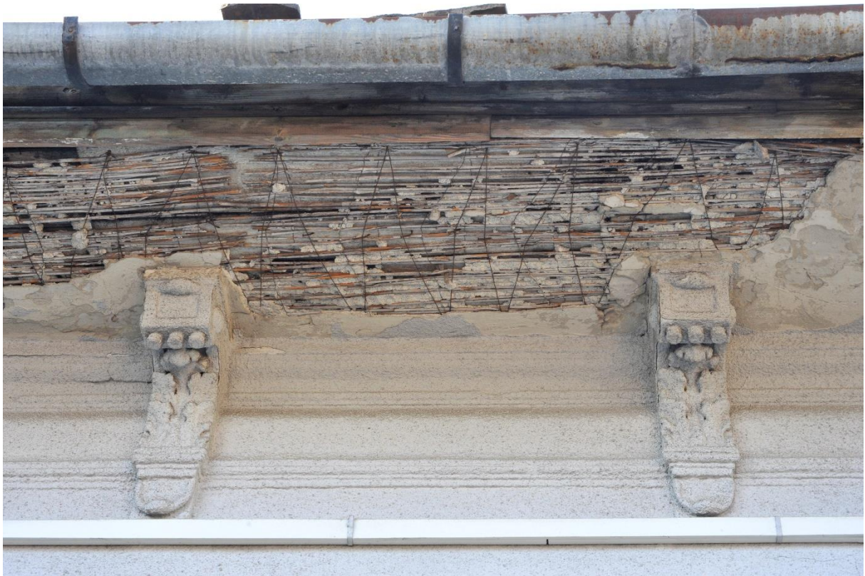
23. kép Északi homlokzat, eresz és konzolok
