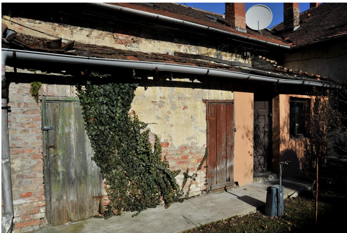
37. kép Belső udvar, keleti homlokzat, részlet
