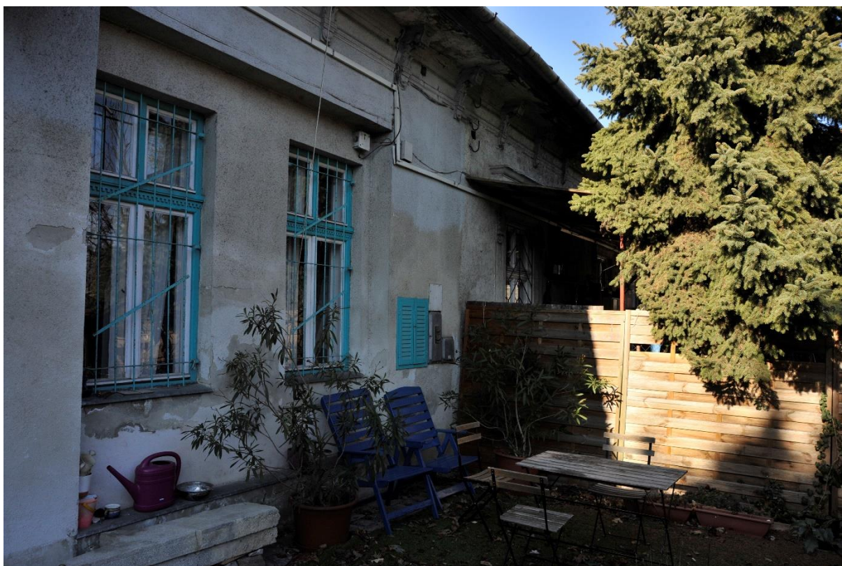
21. kép Északi homlokzat jobb oldali szakasz
