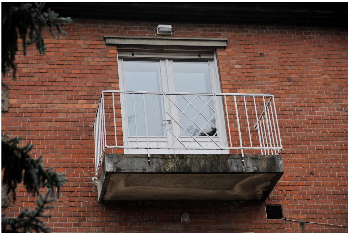
31. kép Erkély az északi homlokzaton
