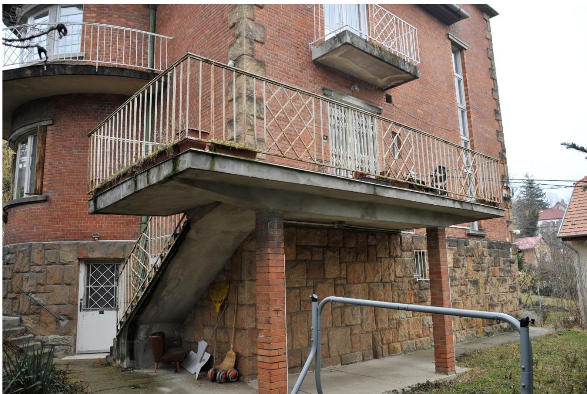
26. kép Terasz az északi homlokzat előtt
