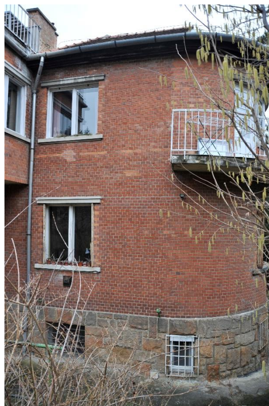
39. kép Déli homlokzat keleti szakasza
