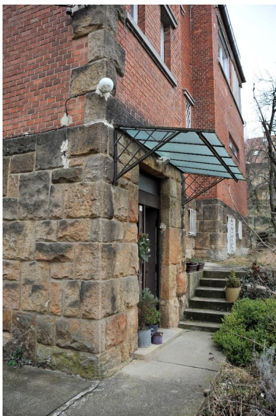
53. kép Az épület északnyugati sarka
