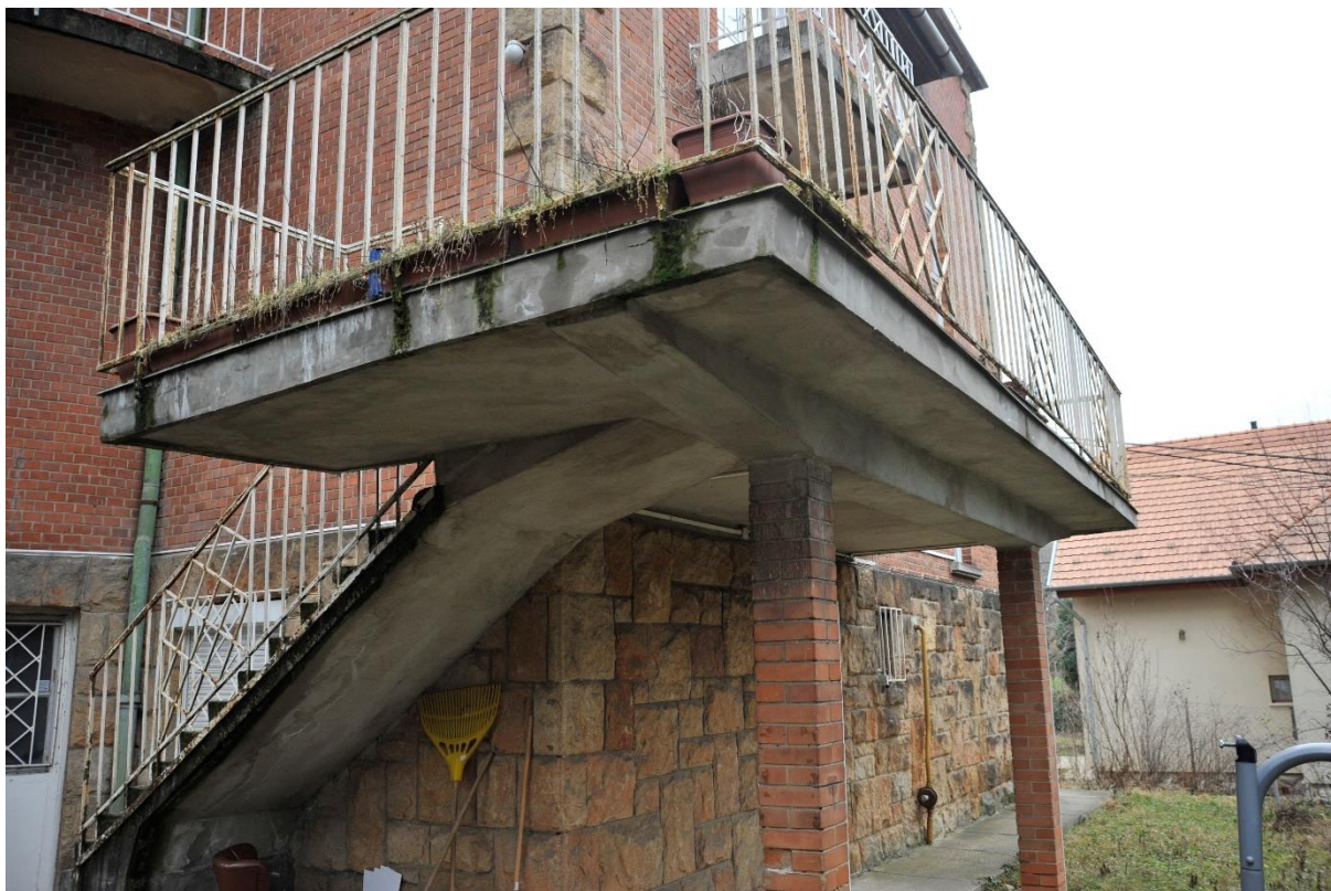
27. kép Terasz az északi homlokzat előtt
