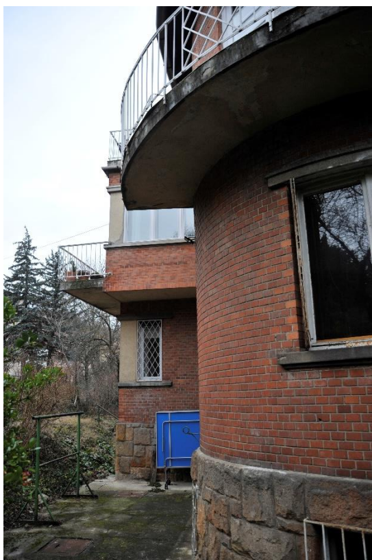
38. kép A keleti homlokzat déli szakasza és a déli homlokzat részlete
