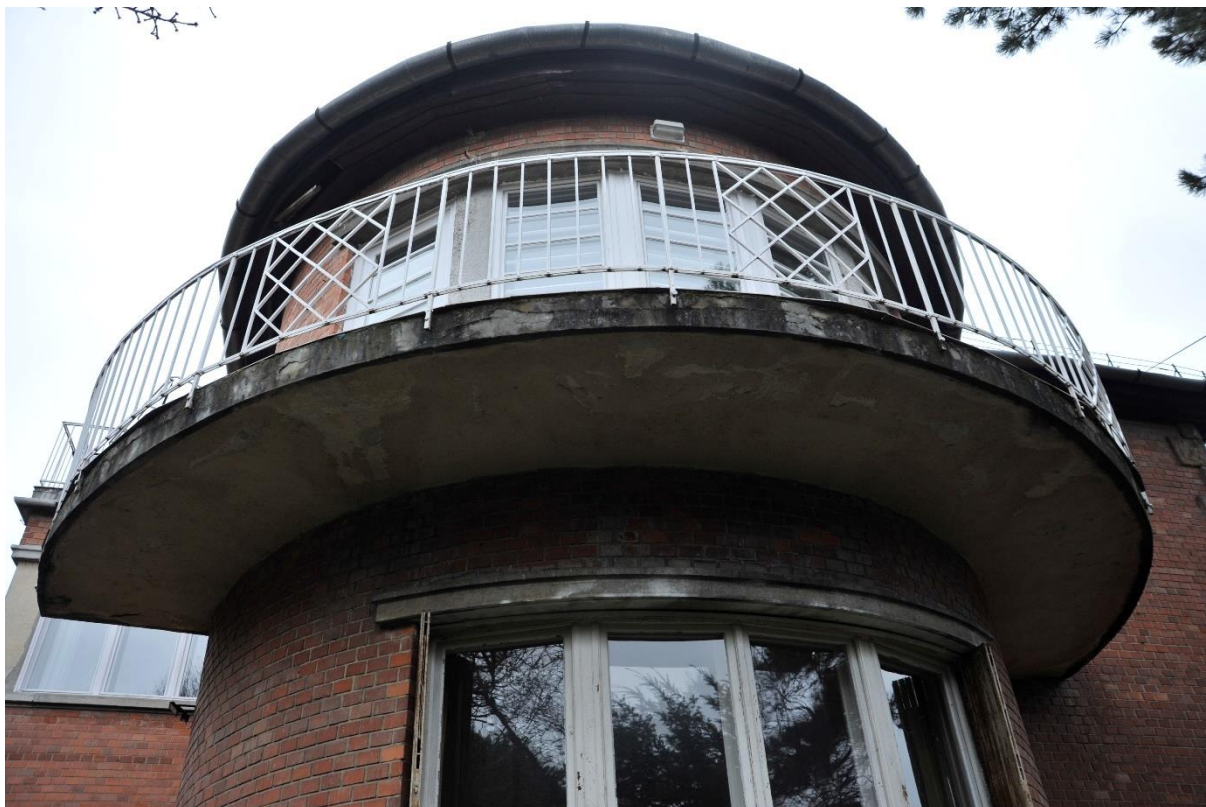
35. kép Erkély a keleti homlokzaton
