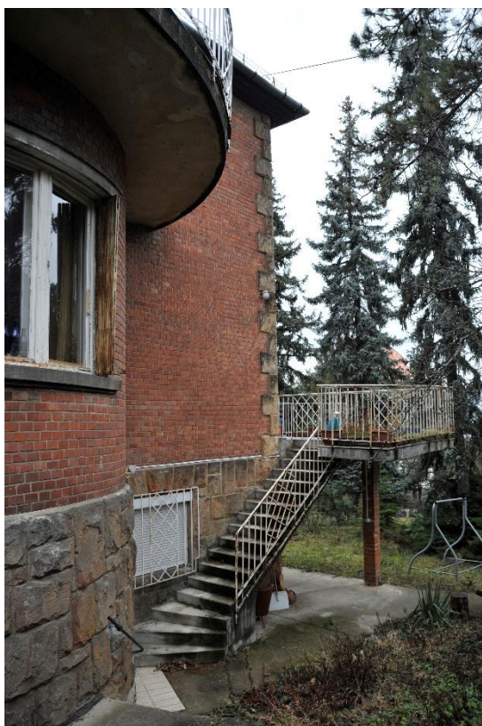
33. kép Keleti oldalhomlokzat, részlet
