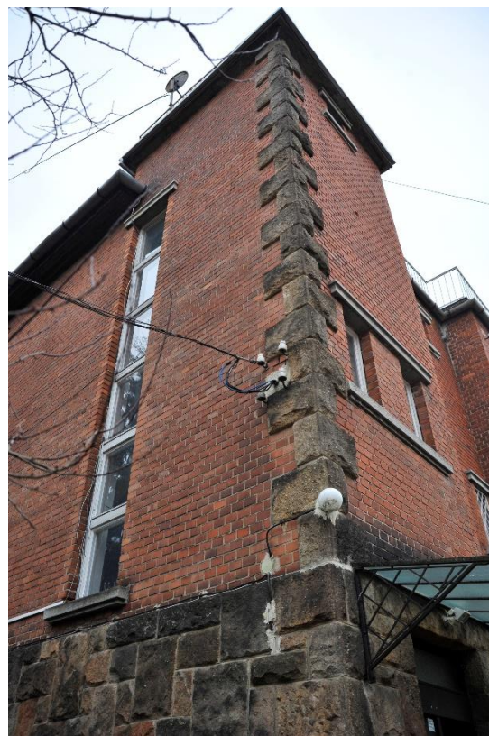
54. kép Az épület északnyugati sarka
