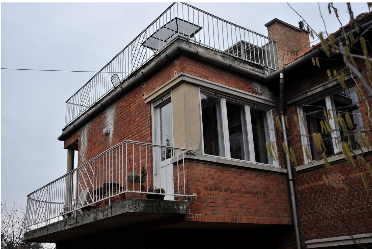
42. kép Déli homlokzat, erkély és tetőterasz
