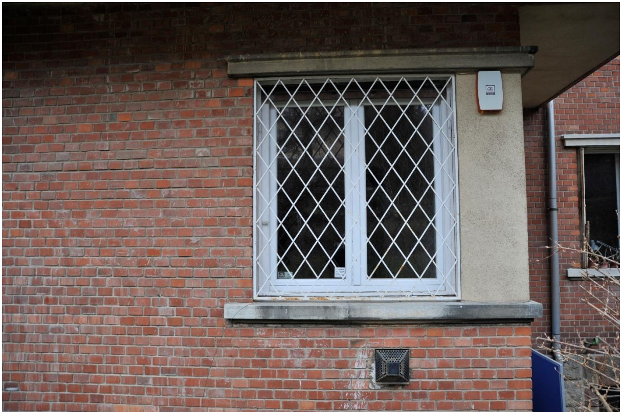
46. kép Ablak a déli homlokzaton
