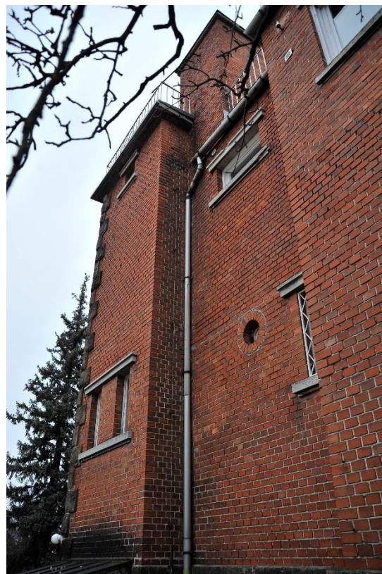
51. kép A nyugati homlokzat északi szakasza
