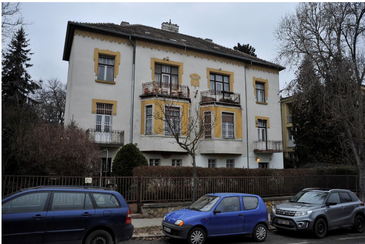
5. kép Az épület összképe kelet felől
