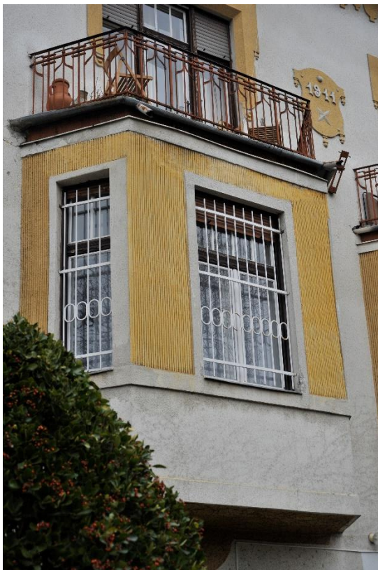
11. kép Zárterkély a keleti homlokzaton
