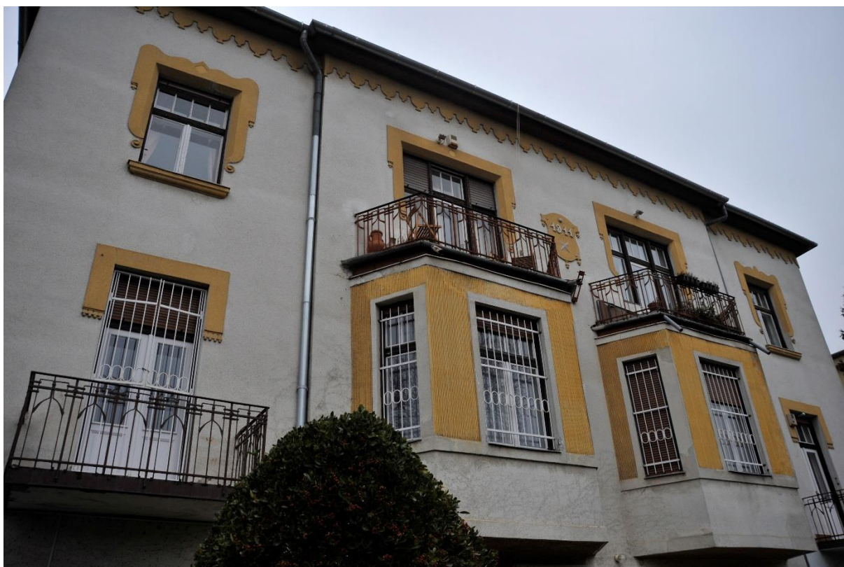
6. kép Keleti homlokzat, részlet
