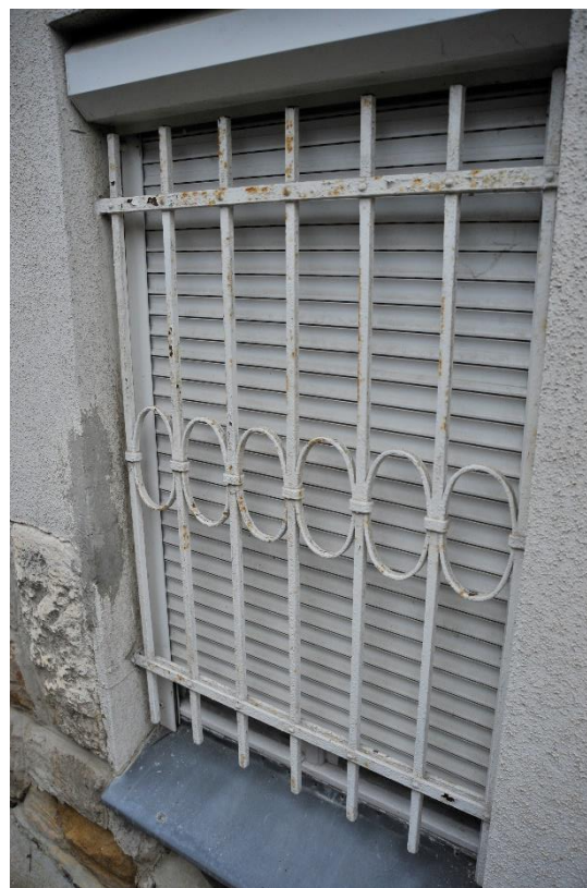
19. kép ablakrács a déli homlokzaton
