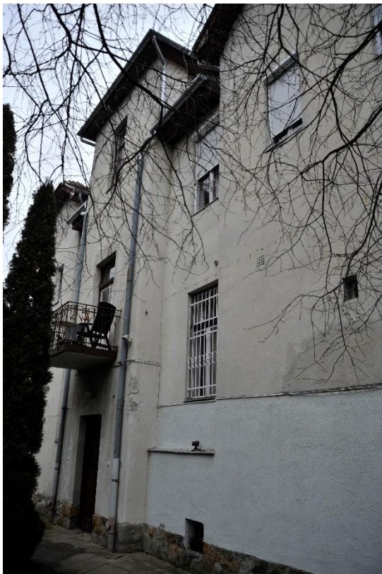
21. kép Nyugati homlokzat
