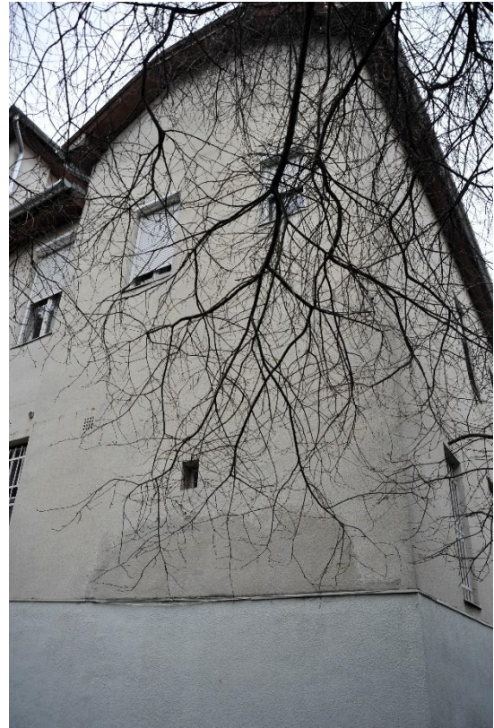
22. kép Nyugati homlokzat déli szakasza
