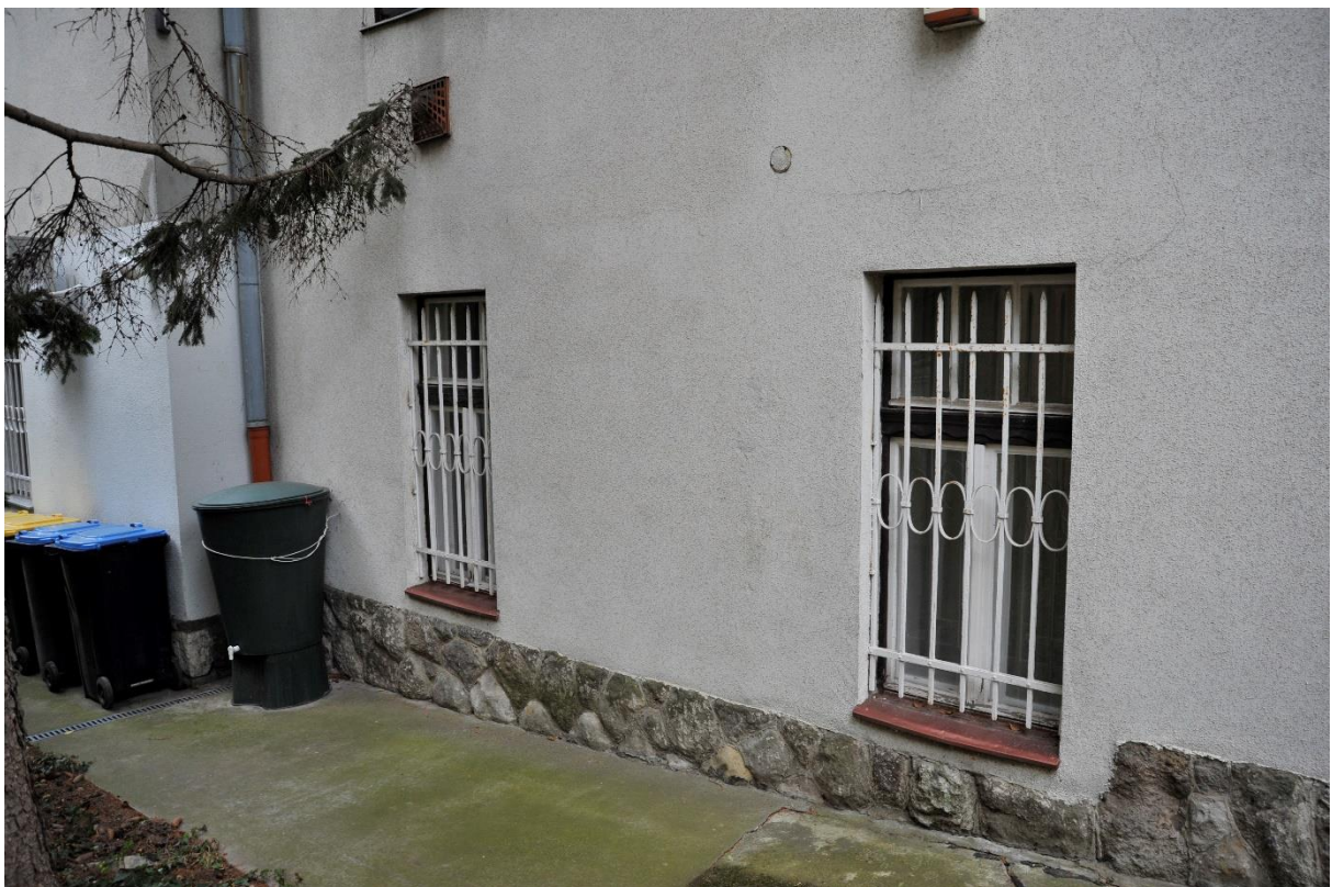
30. kép Északi homlokzat földszinti szakasza
