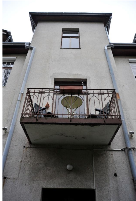
25. kép A nyugati homlokzat középső szakasza erkéllyel és korlátjával
