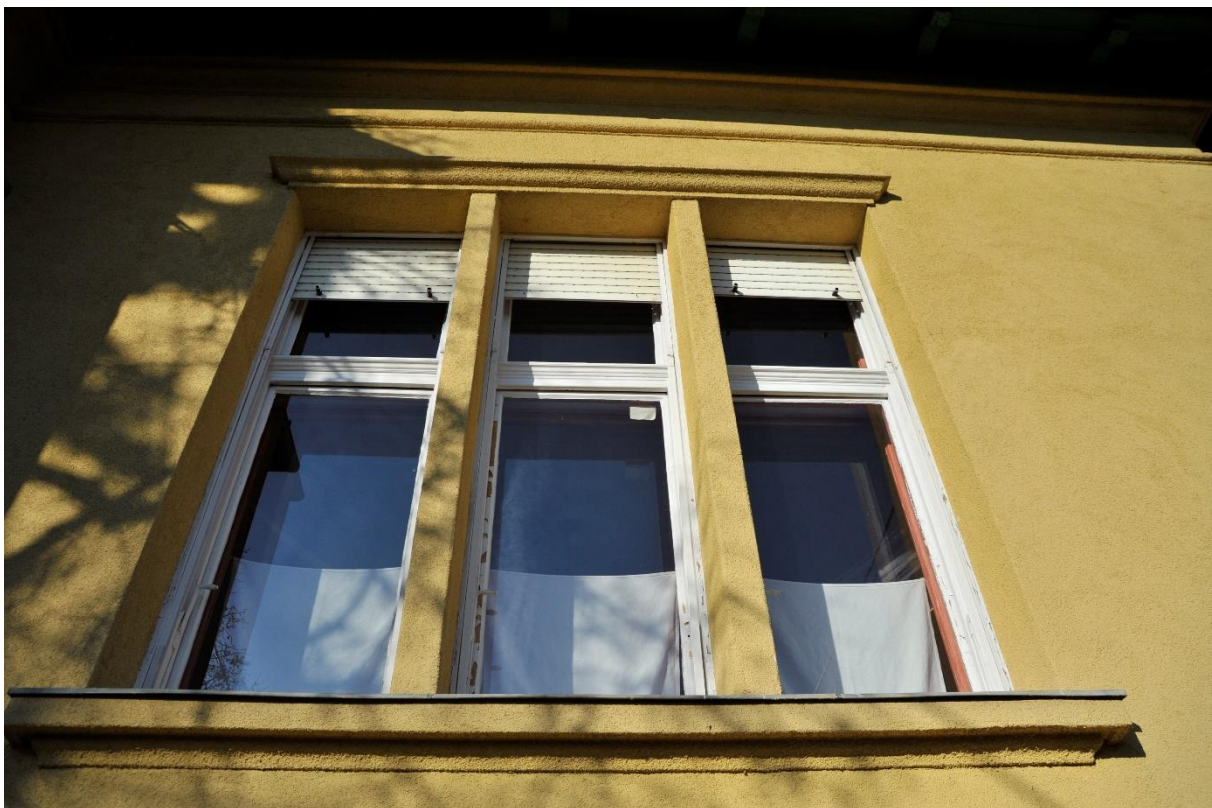
19. kép Ablak a keleti homlokzaton
