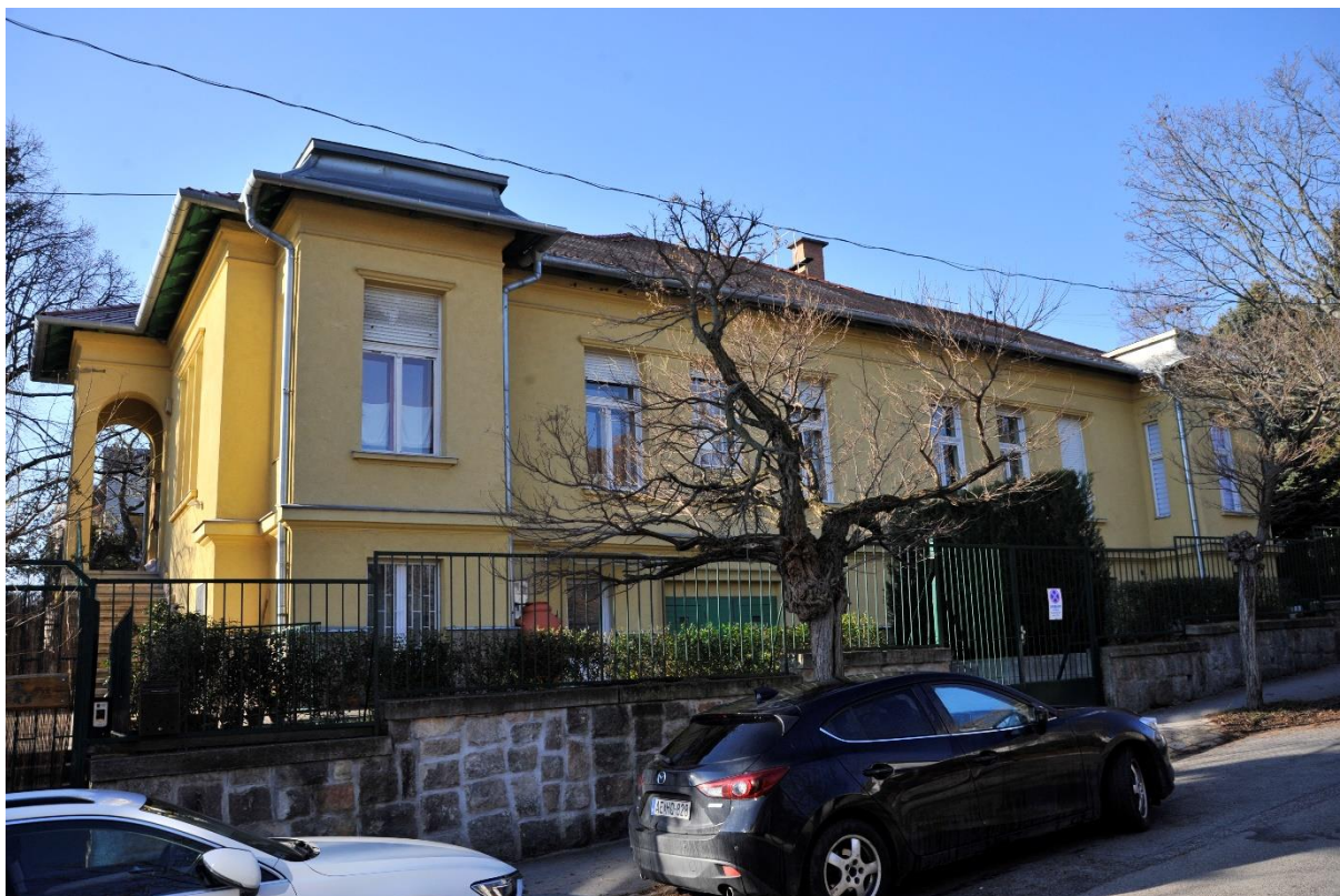
11. kép Az épület összképe az utca felől
