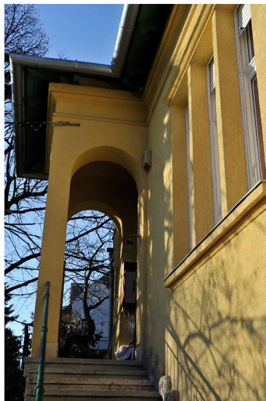
17. kép Feljárat a földszinti bejáráthoz a keleti homlokzaton
