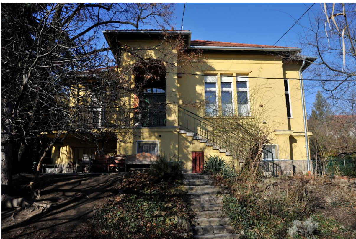
12. kép Az épület összképe kelet felől
