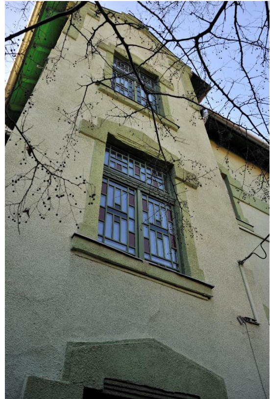
25. kép Északi homlokzat, részlet
