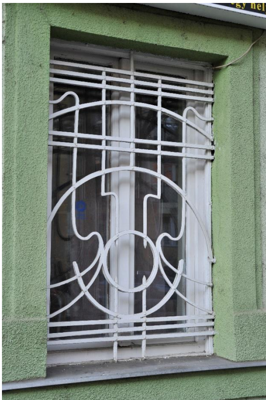
32. kép Az épülettel egykorú ablakrács
