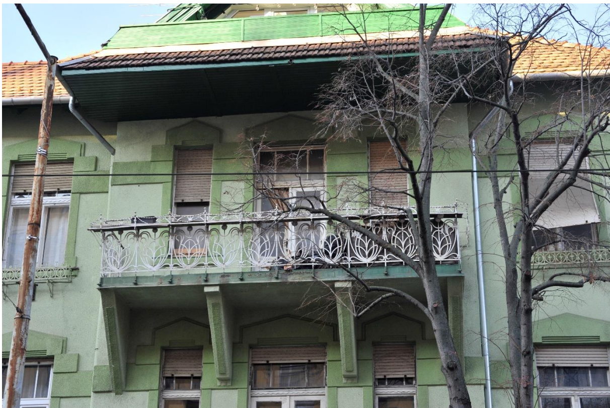
21. kép A főhomlokzat középrizalitjának emeleti szakasza
