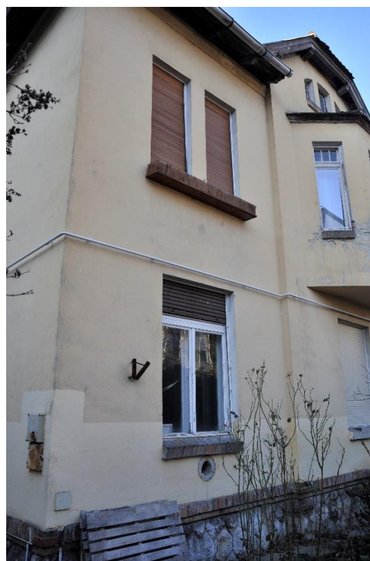
37. kép Utcai homlokzat, bal oldali szakasz
