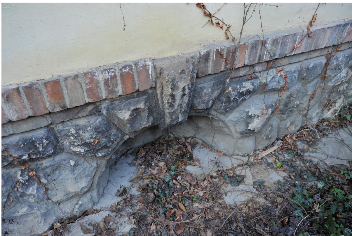
39. kép Lábazat az utcai homlokzaton
