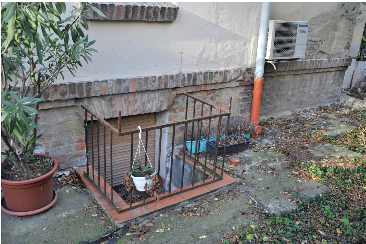
31. kép Délnyugati homlokzat, angolakna
