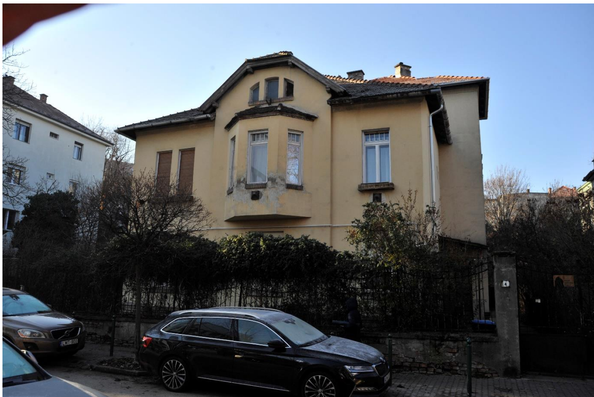
20. kép Északkeleti (utcai) homlokzat
