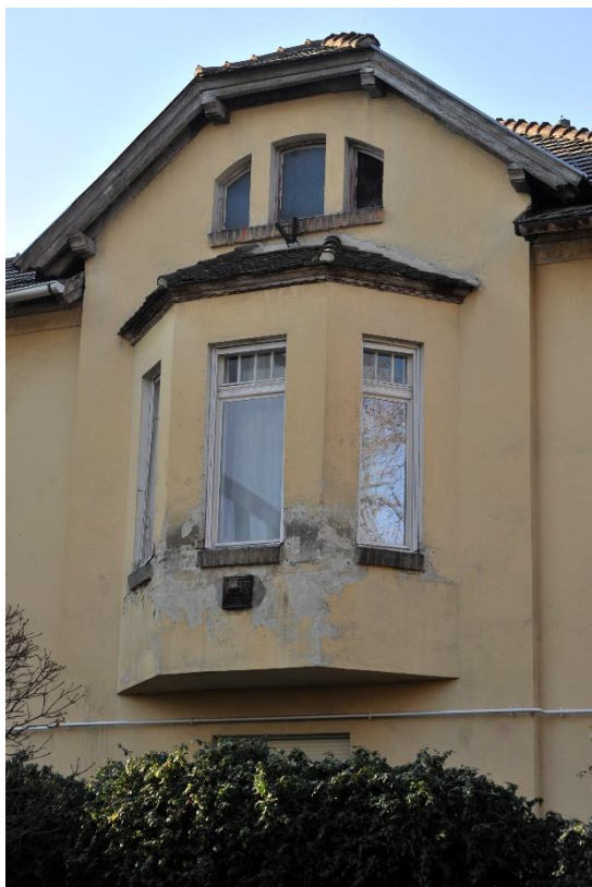
21. kép Zárterkély az északkeleti homlokzat középtengelyében
