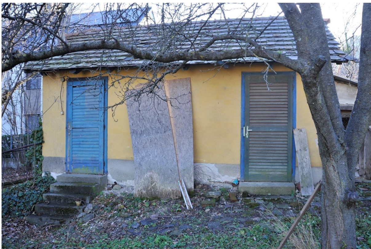
26. kép Kerti melléképület
