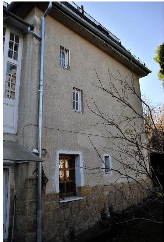
12. kép Északi homlokzat, részlet
