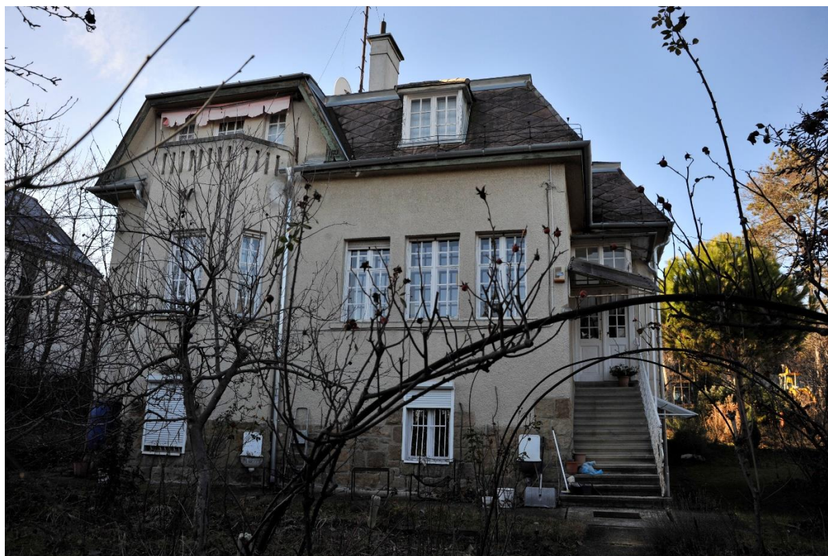
8. kép Keleti homlokzat
