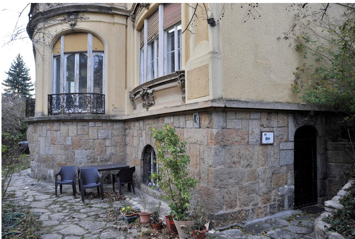
17. kép Az épület alagsori és földszinti homlokzata kelet felől
