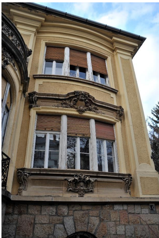
23. kép A főhomlokzat északi szakasza
