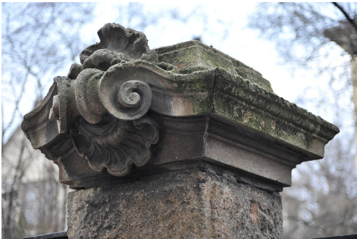
36. kép Fedkő a kerítés pillérén
