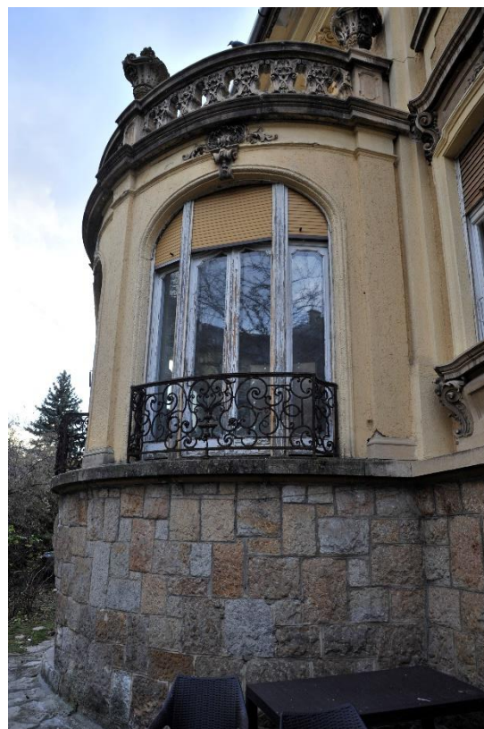
24. kép A főhomlokzat középső szakasza
