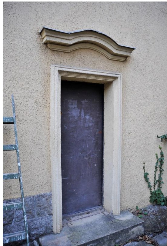
31. kép Mellékbejárat az északi homlokzaton
