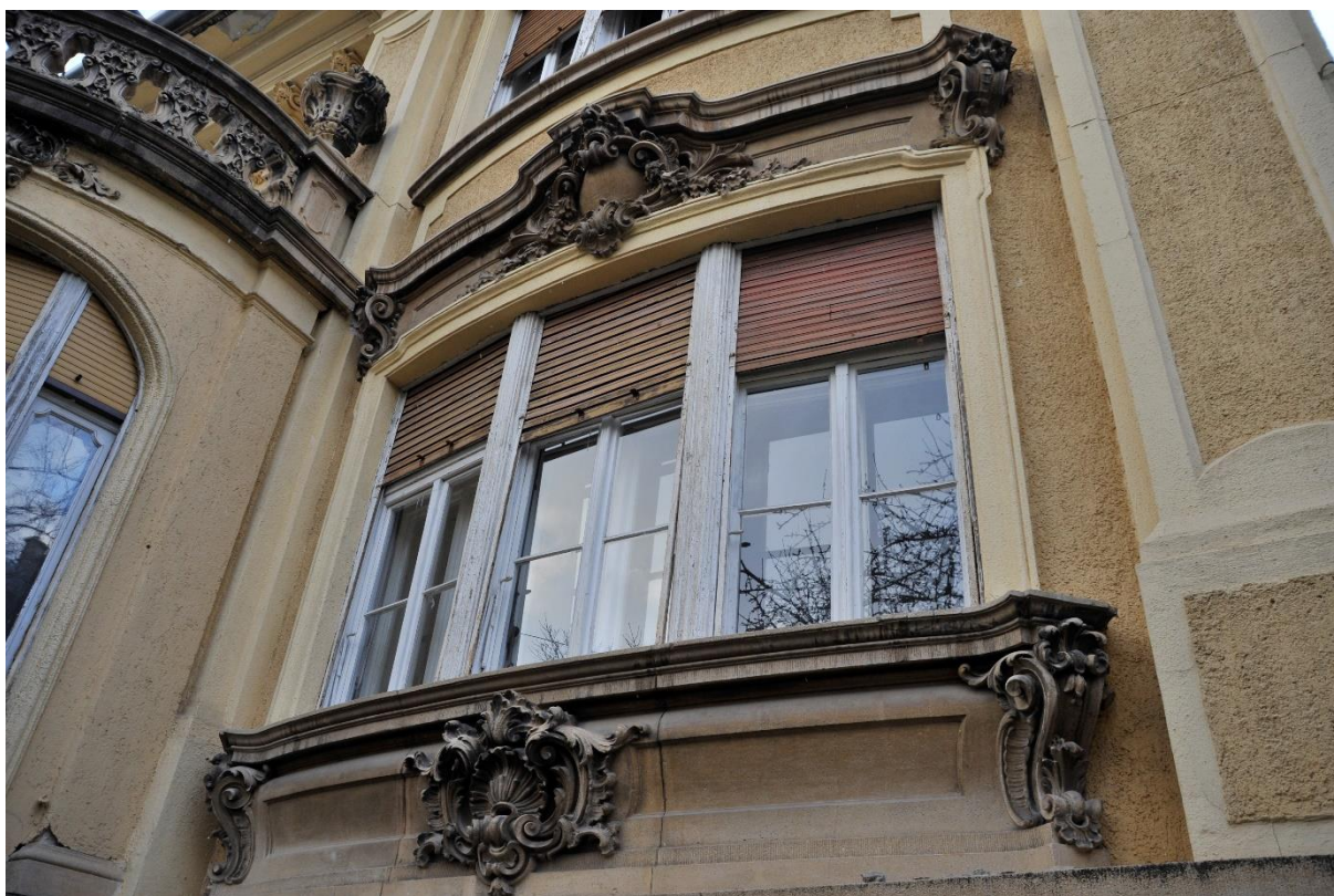
19. kép A főhomlokzat északi szakasza, földszint
