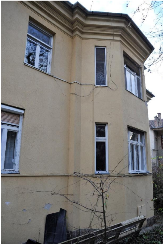
28. kép Nyugati homlokzat, középső részlet
