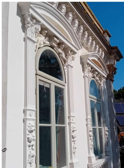
felújítás közbeni állapot
