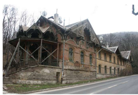
felújítás előtti állapot
