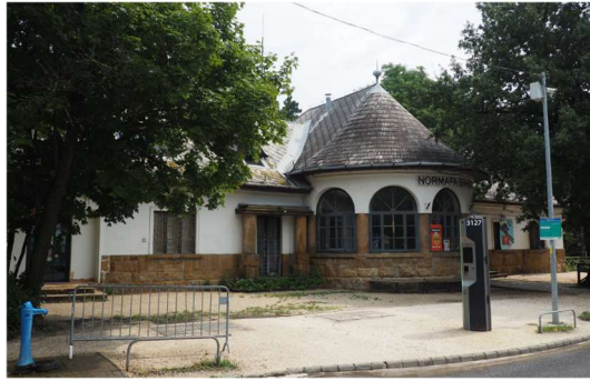
felújítás előtti állapot
