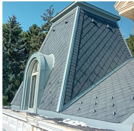
felújítás közbeni állapot
