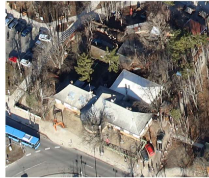
felújítás előtti állapot
