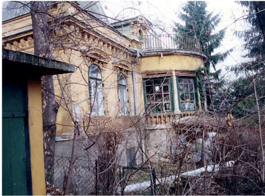
felújítás előtti állapot
