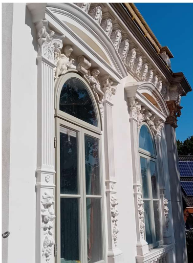
felújítás közbeni állapot
