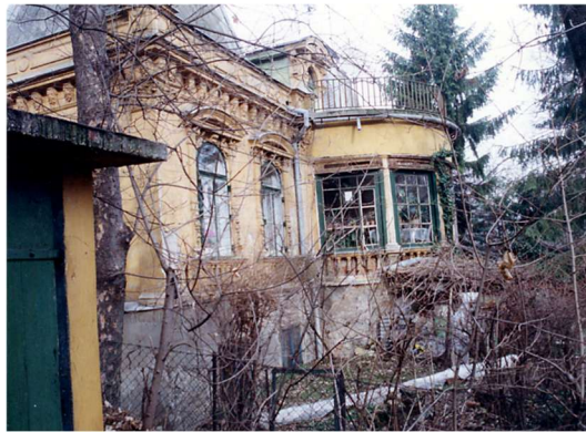
felújítás előtti állapot
