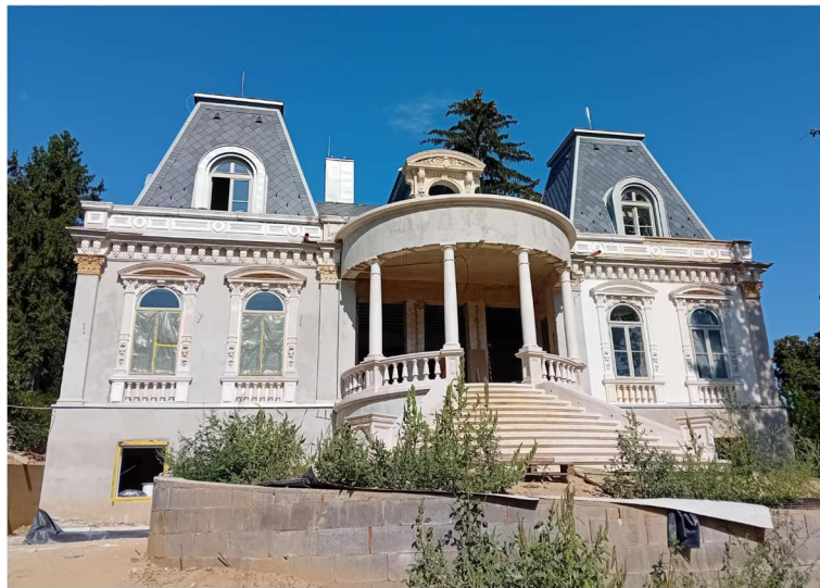
felújítás közbeni állapot
