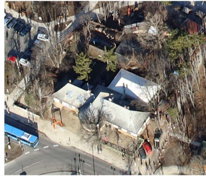
felújítás előtti állapot
