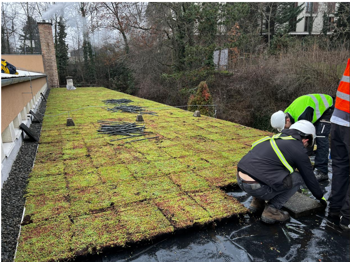
5. ábra: Zöldtető telepítés a Svábhegyi Bölcsődén (Fotó: High Garden Kft.)
