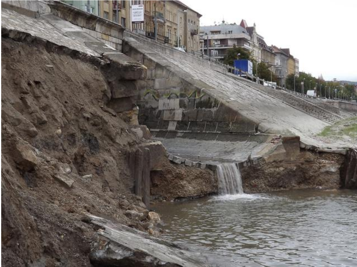
26. ábra: Ördögárok kitorkollás tönkremenetele, 2015. augusztus 17. (Forrás: Index, olvasói fénykép)
