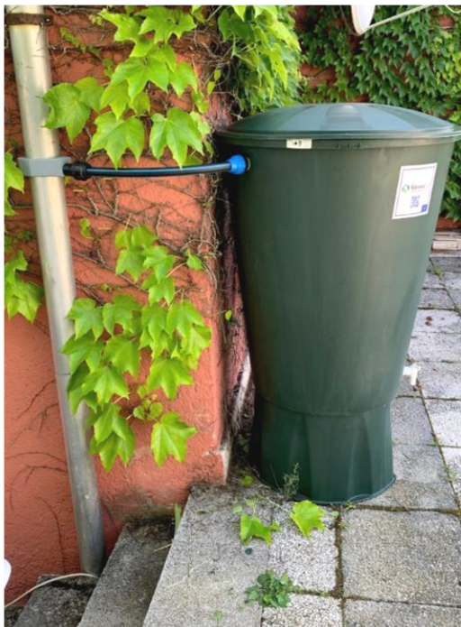
6. ábra: Esővízgyűjtő edények lakóépületek tetőlefolyóira csatlakoztatva (Fotó: Esővízgyűjtő pályázat adatbázis – Hegyvidéki Zöld Iroda)
