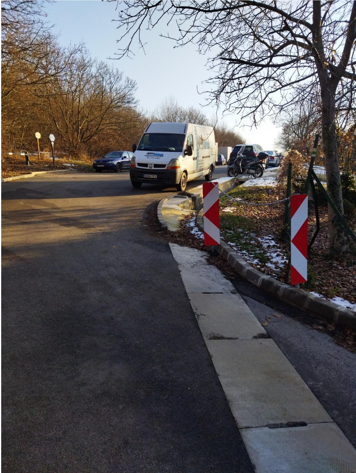
31. ábra: Álom utca, vízvezetés csak az utca beépített oldalán (Fotó: Dr. Knolmár Marcell)
