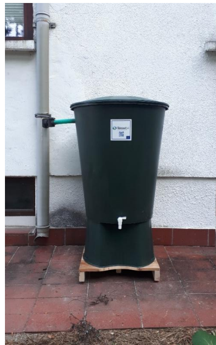
6. ábra: Esővízgyűjtő edények lakóépületek tetőlefolyóira csatlakoztatva (Fotó: Esővízgyűjtő pályázat adatbázis – Hegyvidéki Zöld Iroda)
