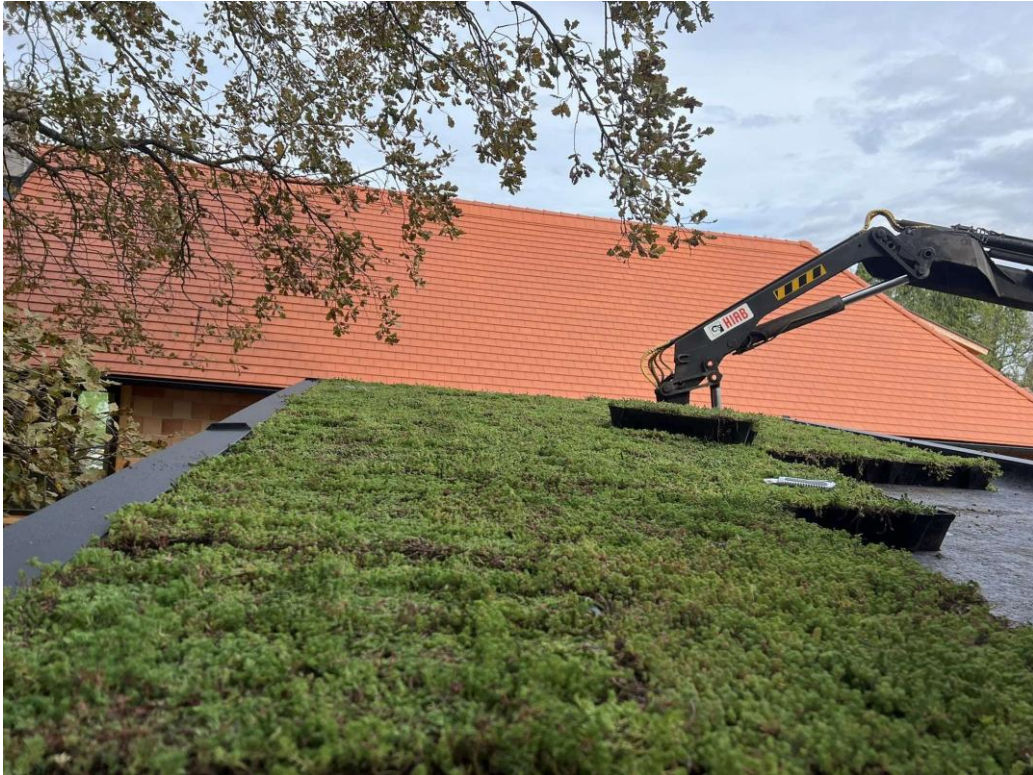
80. ábra: Tálcsás/moduláris extenzív zöldtető típus (Forrás: https://diadem.com/hu/the7_project/diatray/ )
