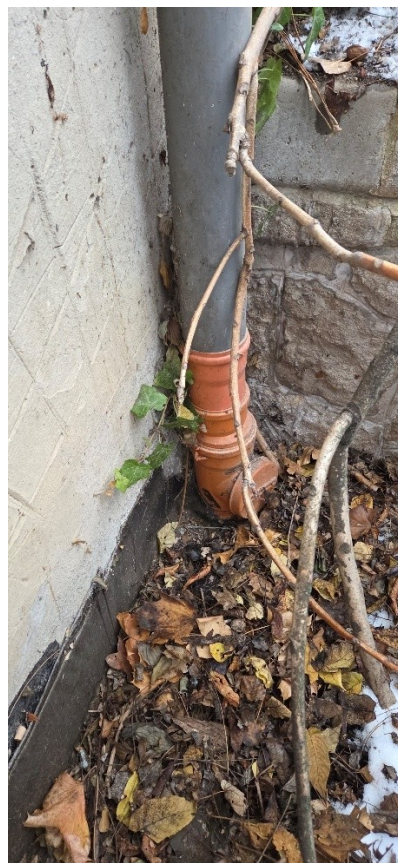
5/7. kép Csapadékvíz elvezetés
