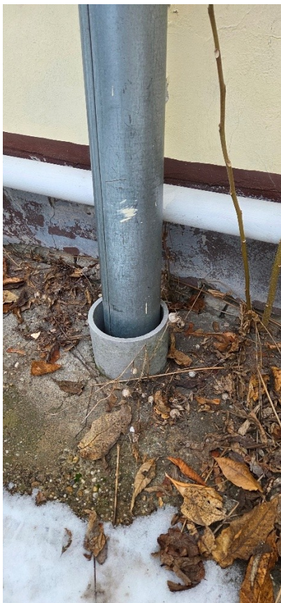
5/5. kép Csapadékvíz elvezetés
