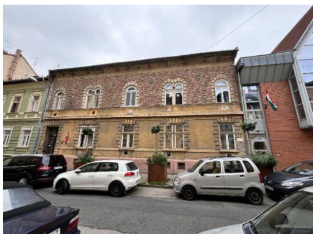
társasház utcafronti homlokzat
