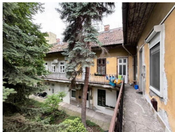
belső udvari homlokzat
