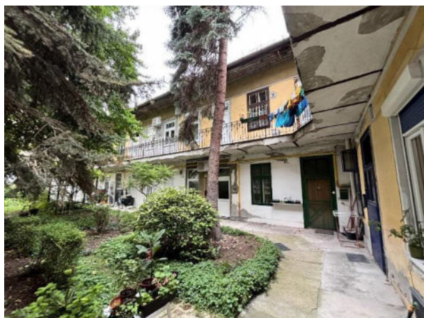
belső udvari homlokzat
