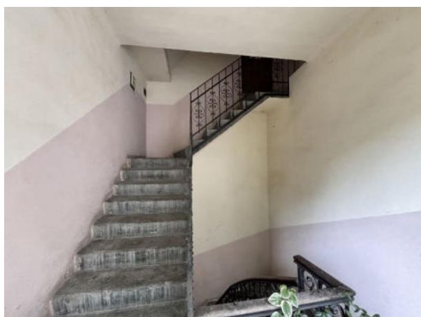
padlástérre vezető lépcsőház
