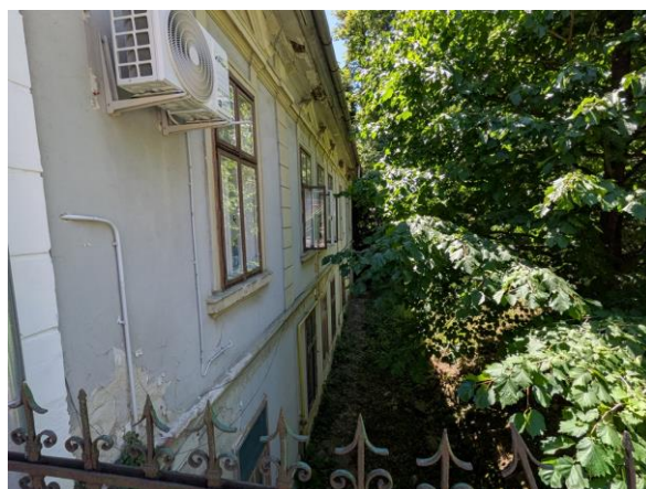
06. értékelt ingatlant befogadó épület
