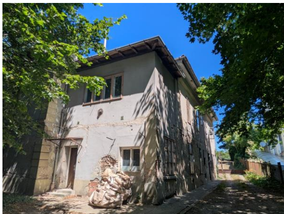
07. értékelt ingatlant befogadó épület
