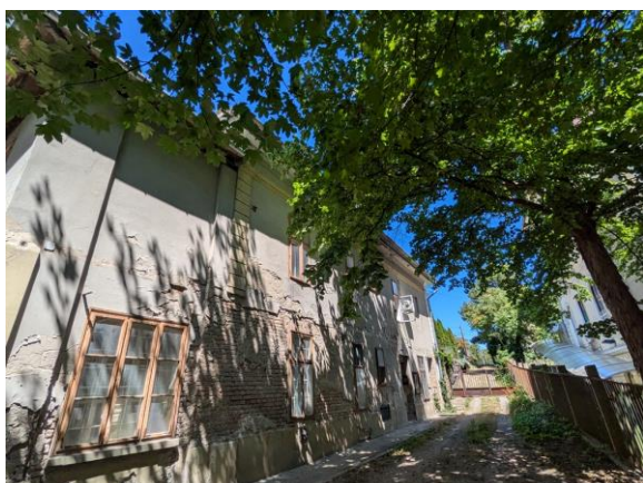
05. értékelt ingatlant befogadó épület
