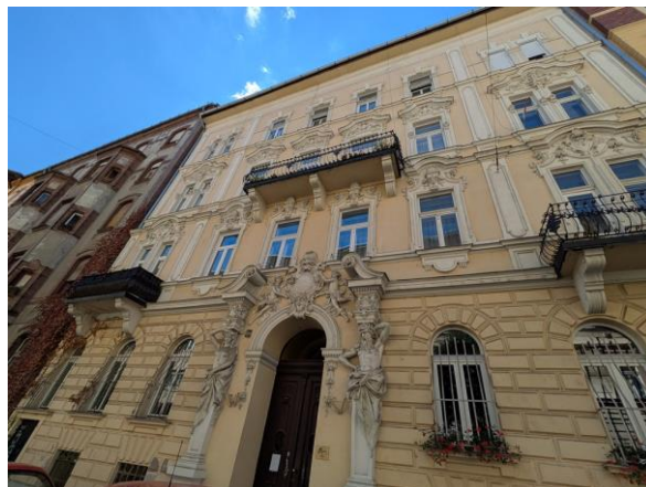
02. értékelt ingatlant befogadó épület
