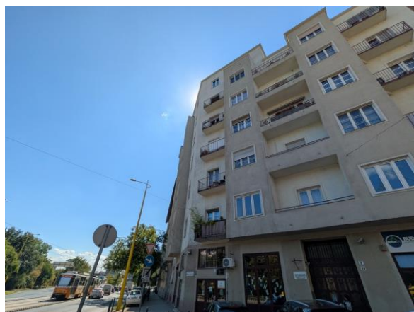
02. értékelt ingatlant befogadó épület
