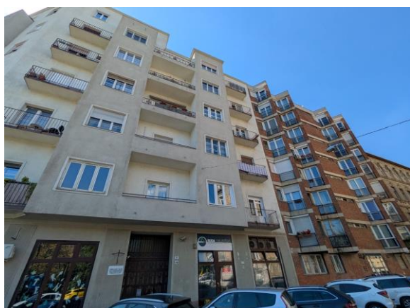
03. értékelt ingatlant befogadó épület
