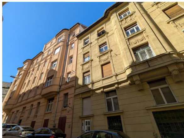
02. értékelt ingatlant befogadó épület
