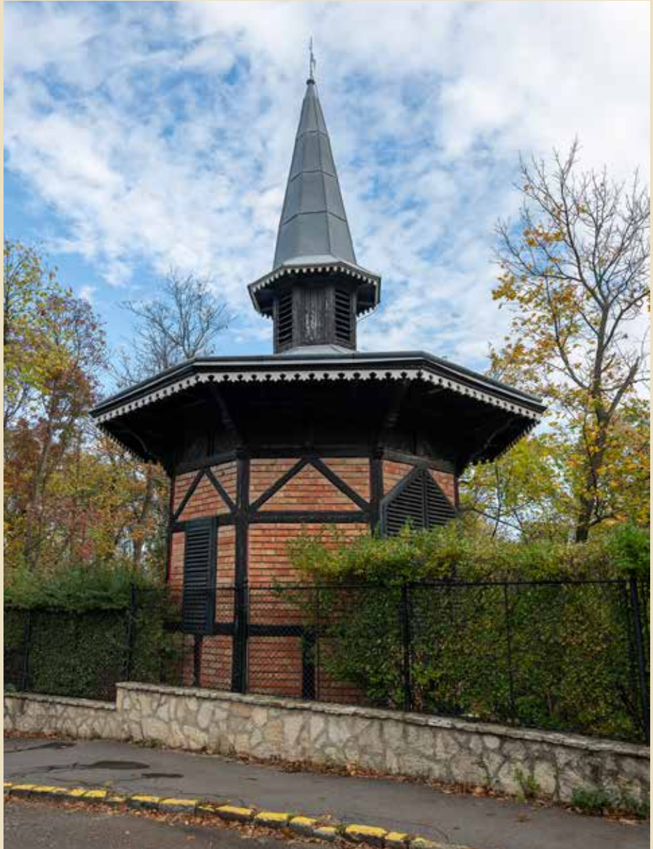
Az egykori vízház felújított épülete napjainkban (Fotó: Csizik Balázs)
