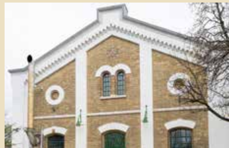
Az Istenhegyi úti vízmű szivattyútelepének turbinacsarnoka napjainkban (Fotó: Csizik Balázs)
