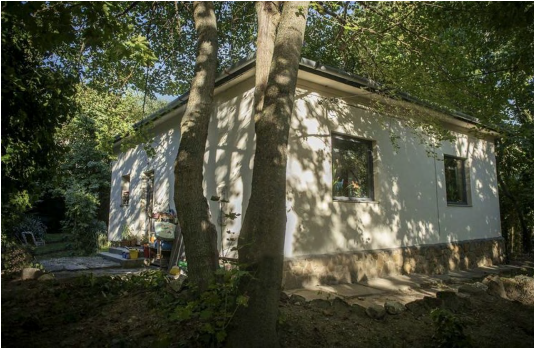
meglévő épület délről
