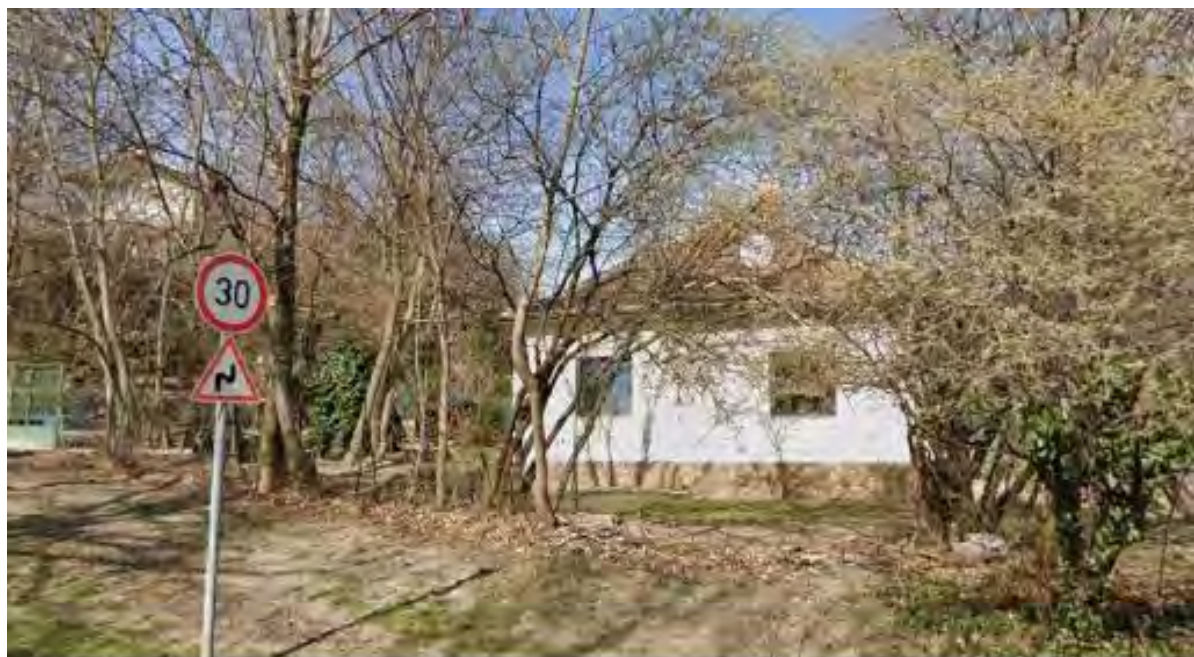
meglévő épület a Mártonhegyi útról
