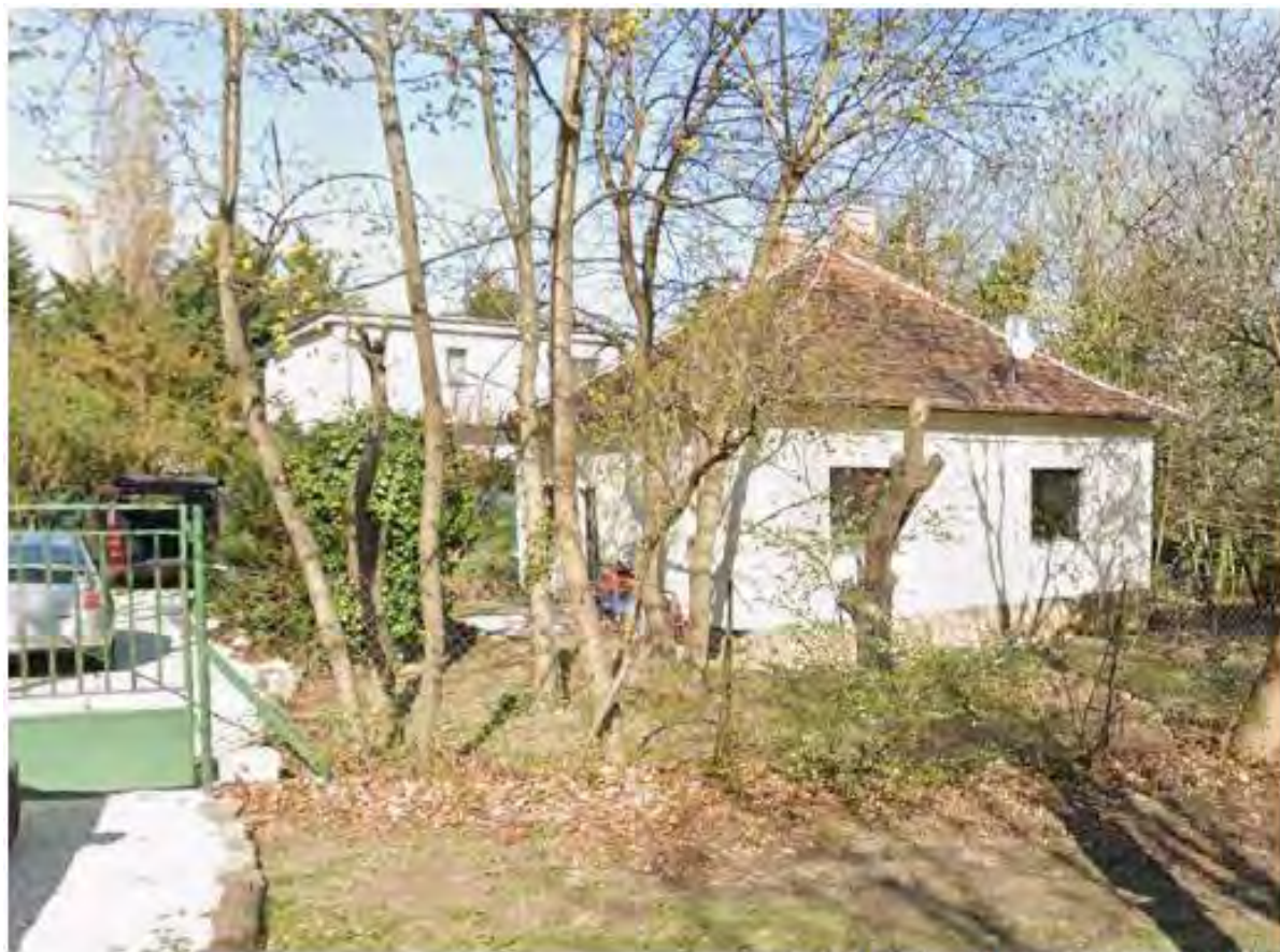
meglévő épület az ajtóbehajtó felől
