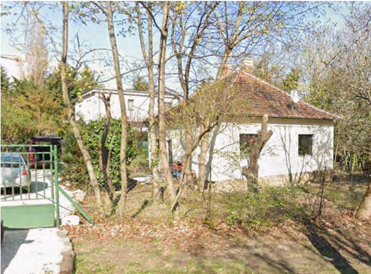
meglévő épület az ajtóbehajtó felől
