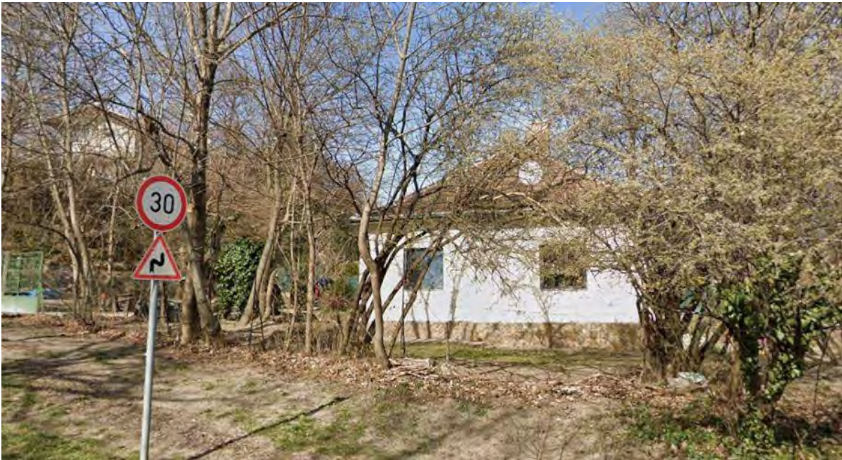
meglévő épület a Mártonhegyi útról
