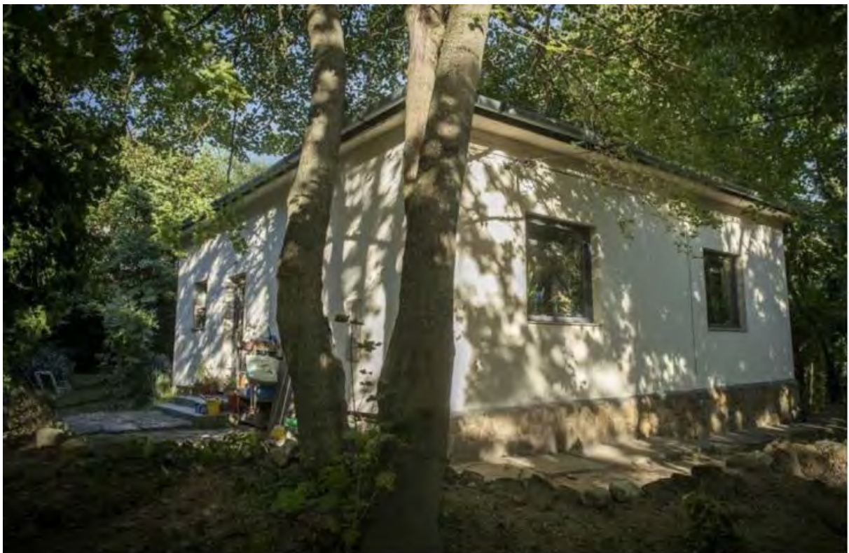
meglévő épület délről
