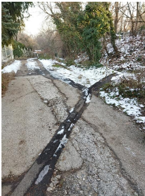
33. ábra: Bürök utca, vízterelő aszfaltcsík, rácisos folyóka helyett (Fotó: Dr. Knolmár Marcell)
