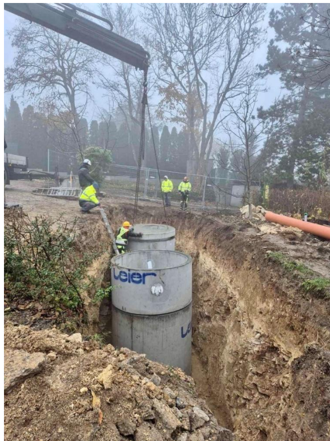
3. ábra: Felszín alatti vízgyűjtő tartályok beemelése a Diana utcában (Fotó: Hegyvidéki Önkormányzat)
