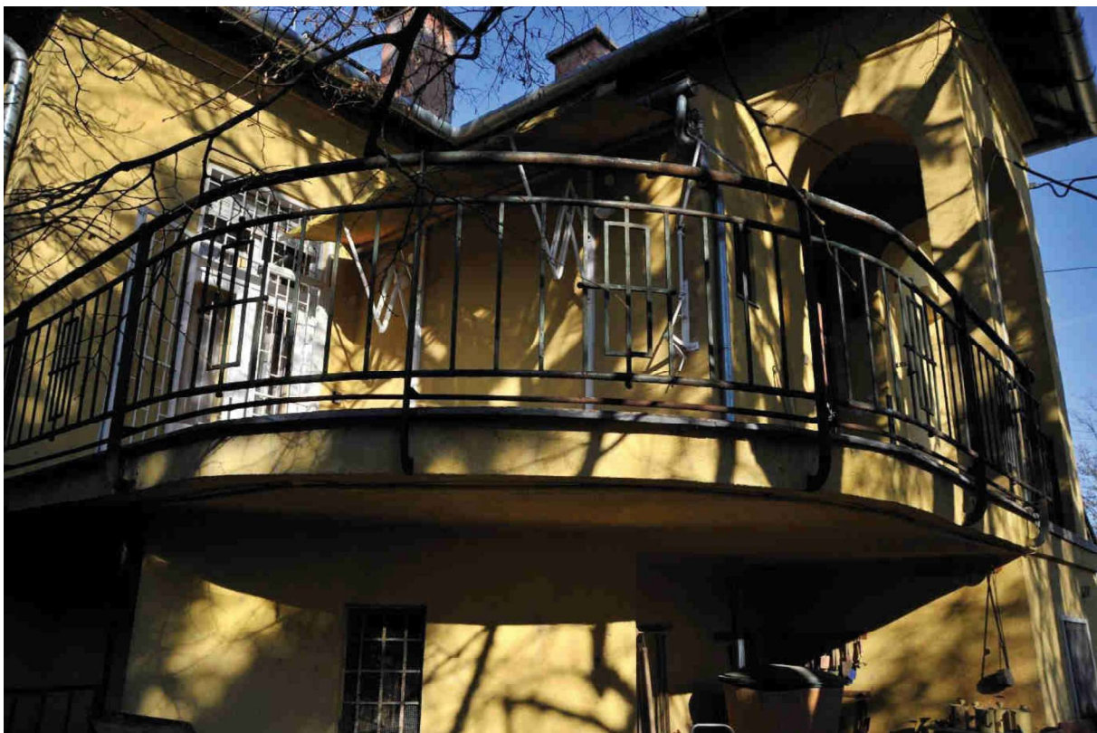
21. kép Terasz és korlátja a délkeleti épületsarkon
