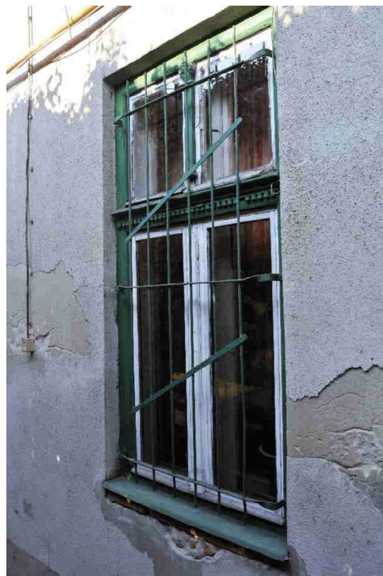
31. kép Ablak a keleti homlokzaton
