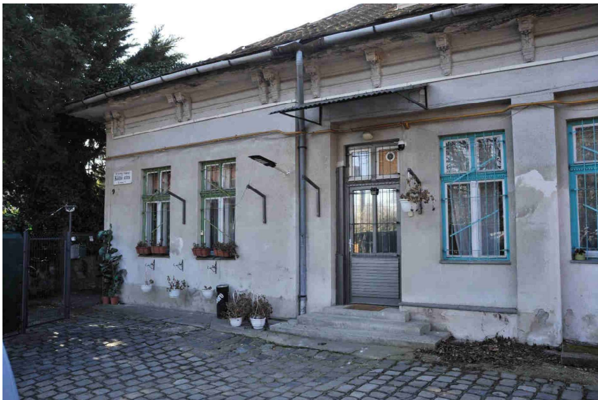
18. kép Északi homlokzat bal oldal
