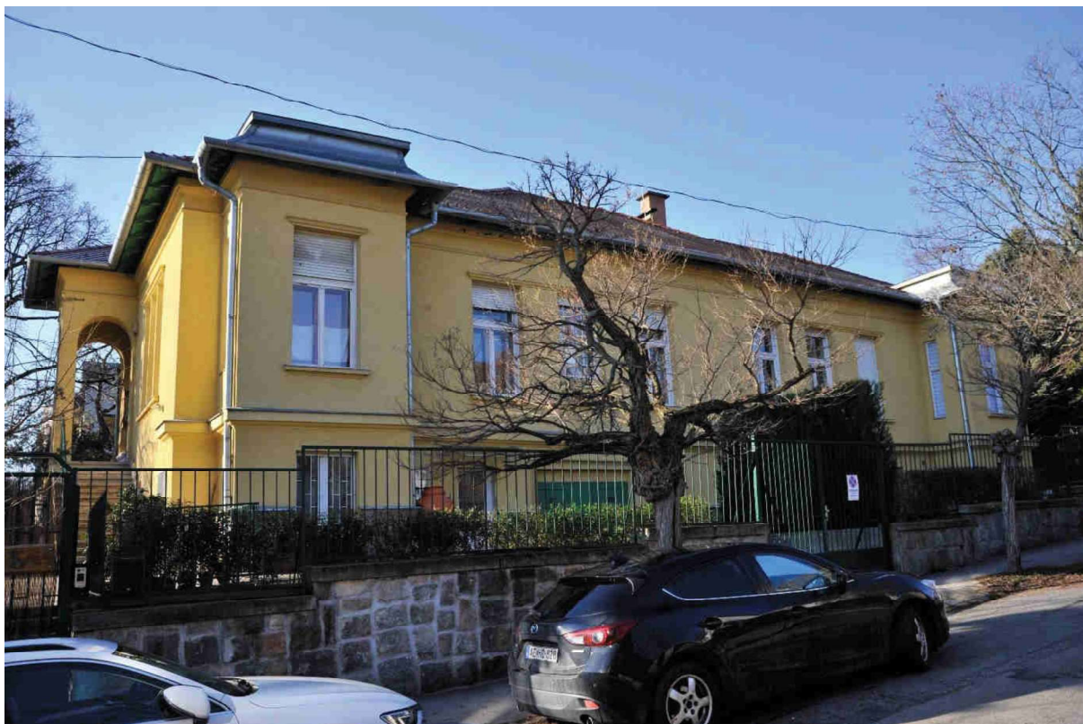
11. kép Az épület összképe az utca felől
