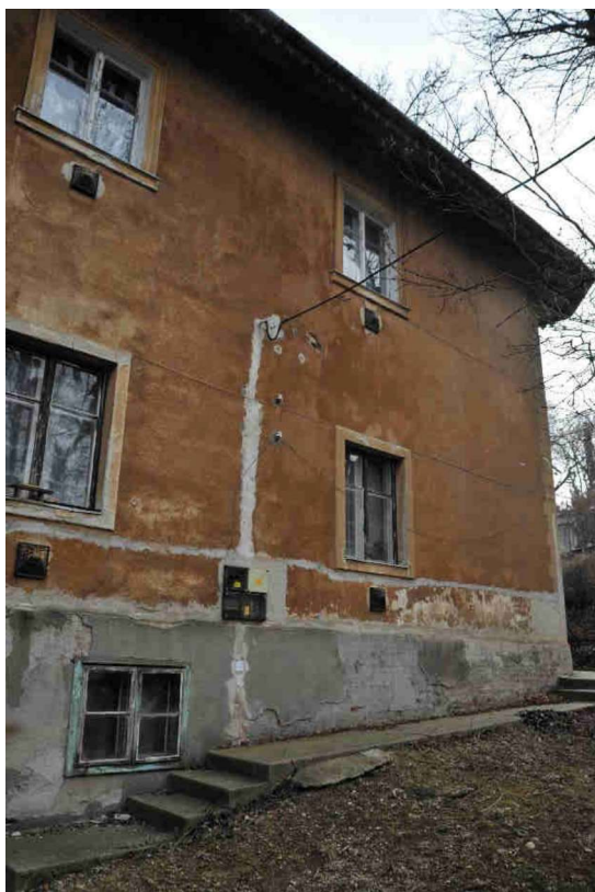
24. kép Északnyugati homlokzat felső szakasza
