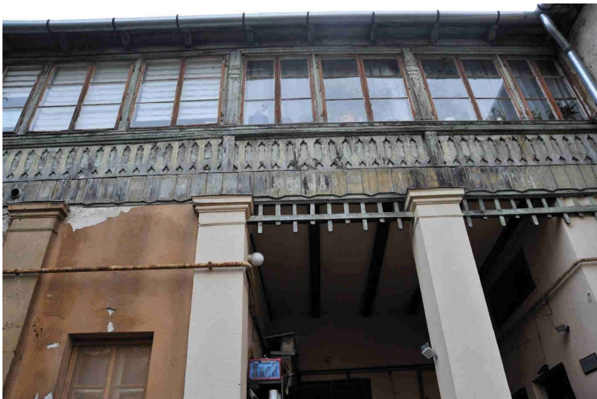
36. kép Északkeleti homlokzat emeleti szakasza
