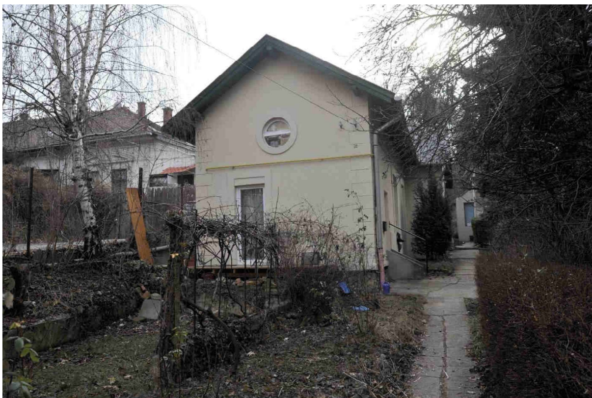
49. kép Melléképület észak felől
