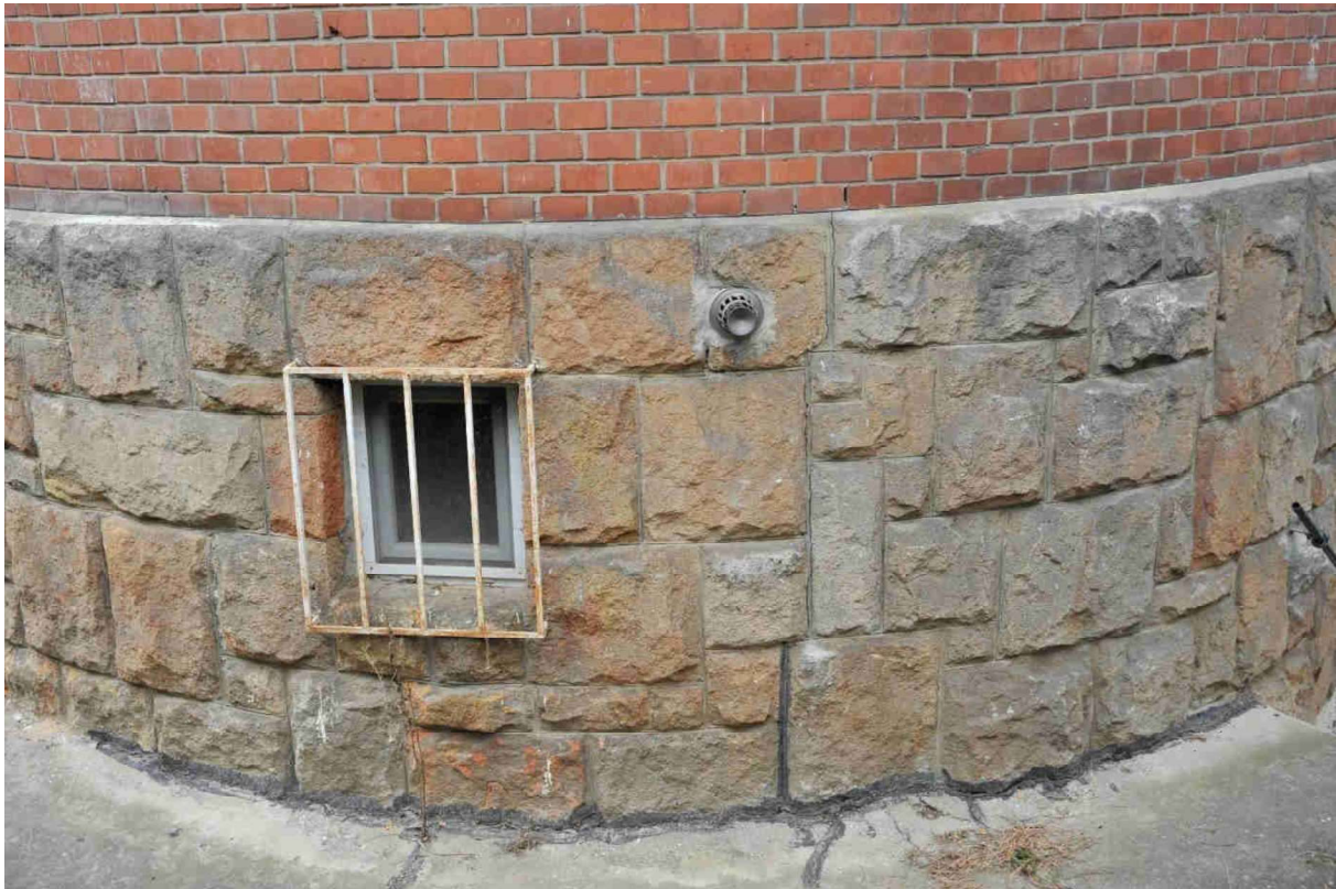
37. kép Lábazat a keleti homlokzaton
