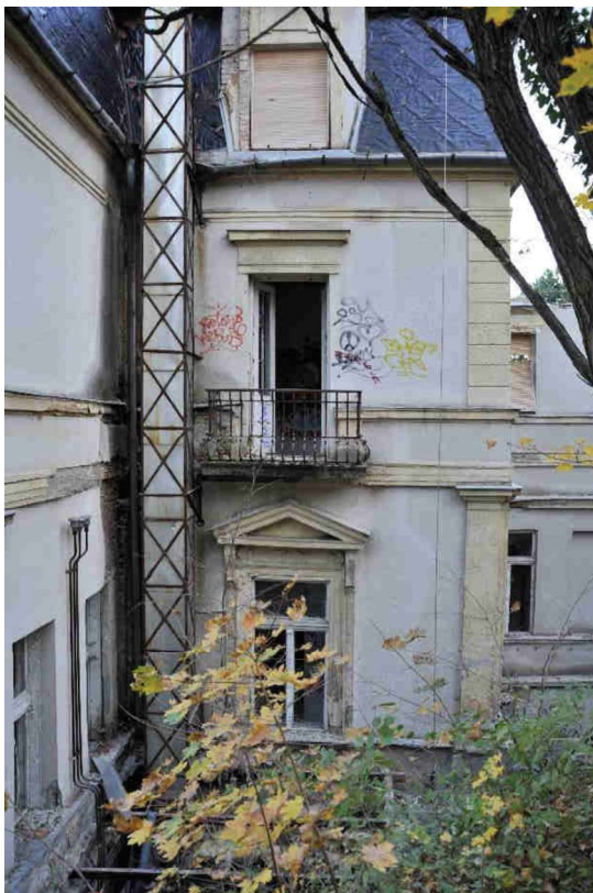
13. kép Nyugati homlokzat déli szakasza
