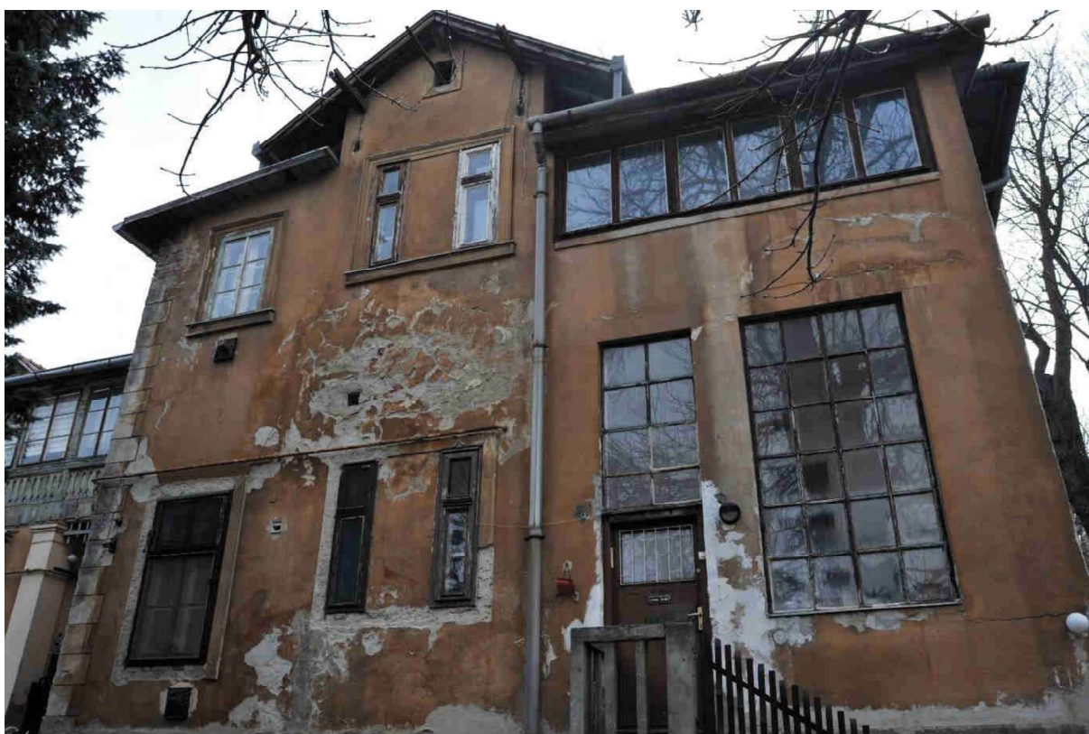
28. kép Északkeleti homlokzat északi szakasza
