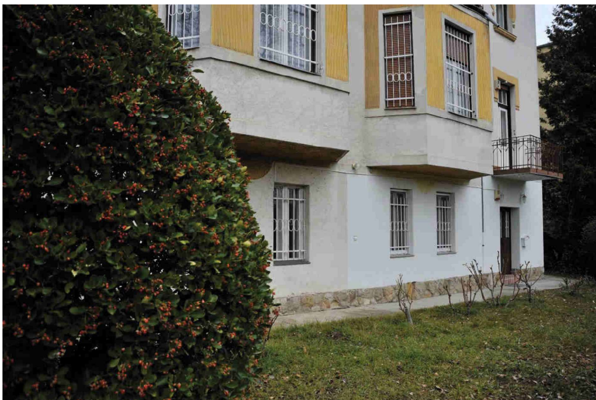
14. kép A keleti homlokzat földszinti homlokzatszakasza dél felől
