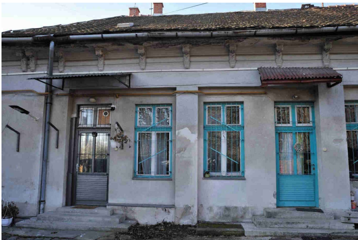
19. kép Északi homlokzat, középső szakasz
