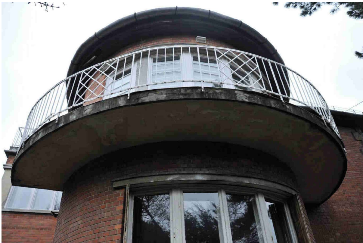
35. kép Erkély a keleti homlokzaton
