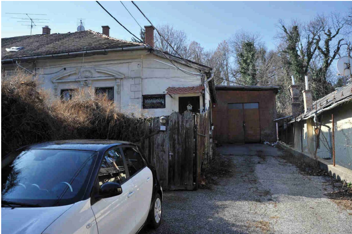
24. kép Az épület nyugati oldalának megközelítése
