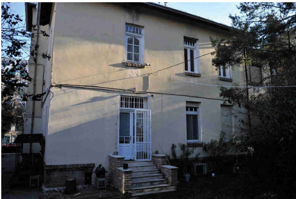
28. kép Délnyugati homlokzat
