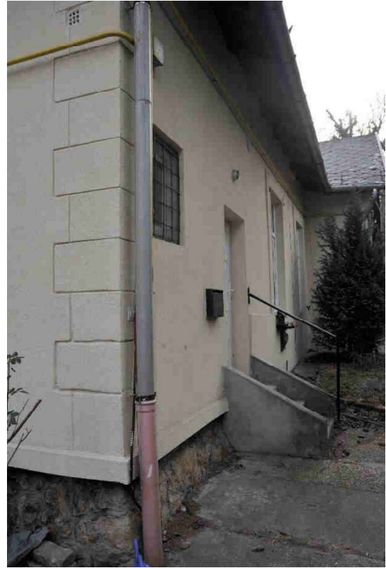
51. kép Melléképület, északi sarok
