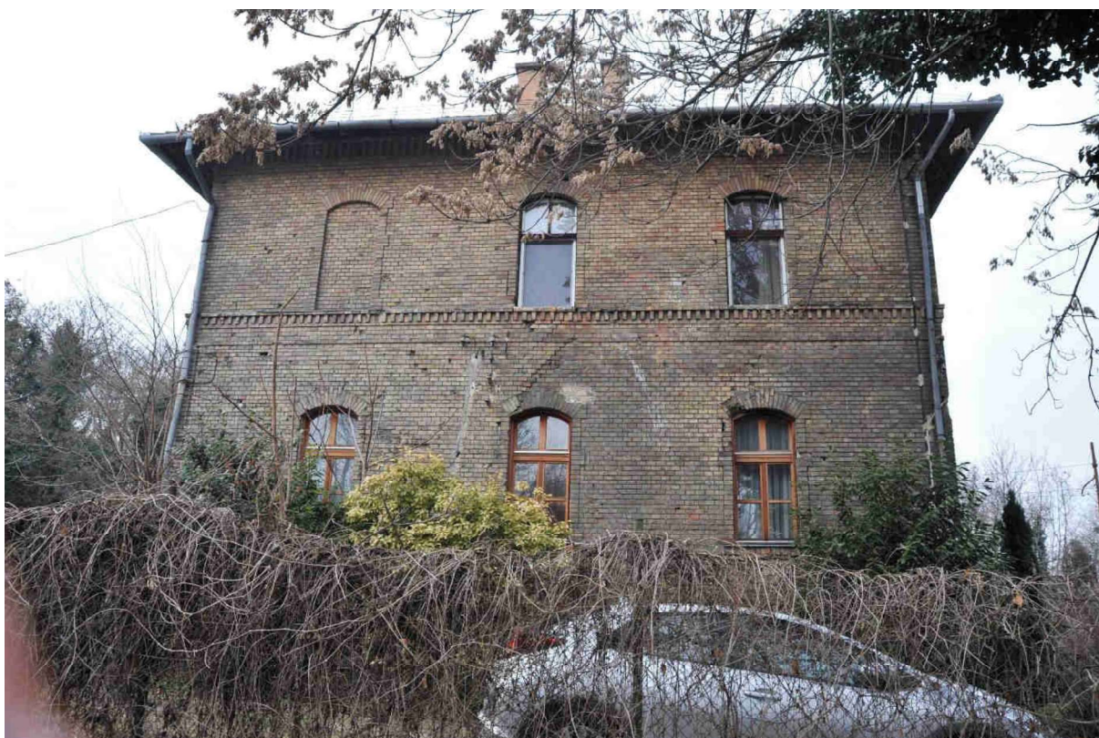
13. kép Keleti homlokzat
