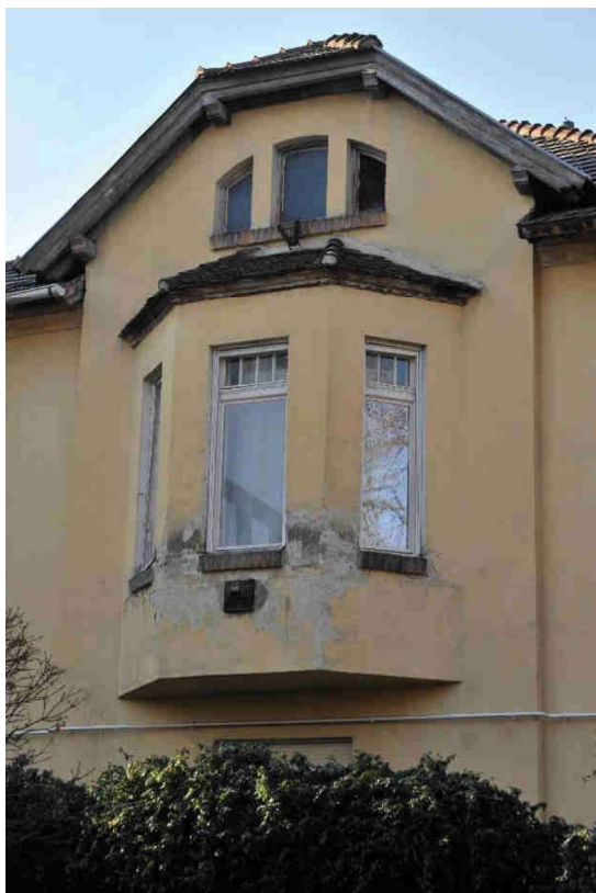
21. kép Zárterkély az északkeleti homlokzat középtengelyében
