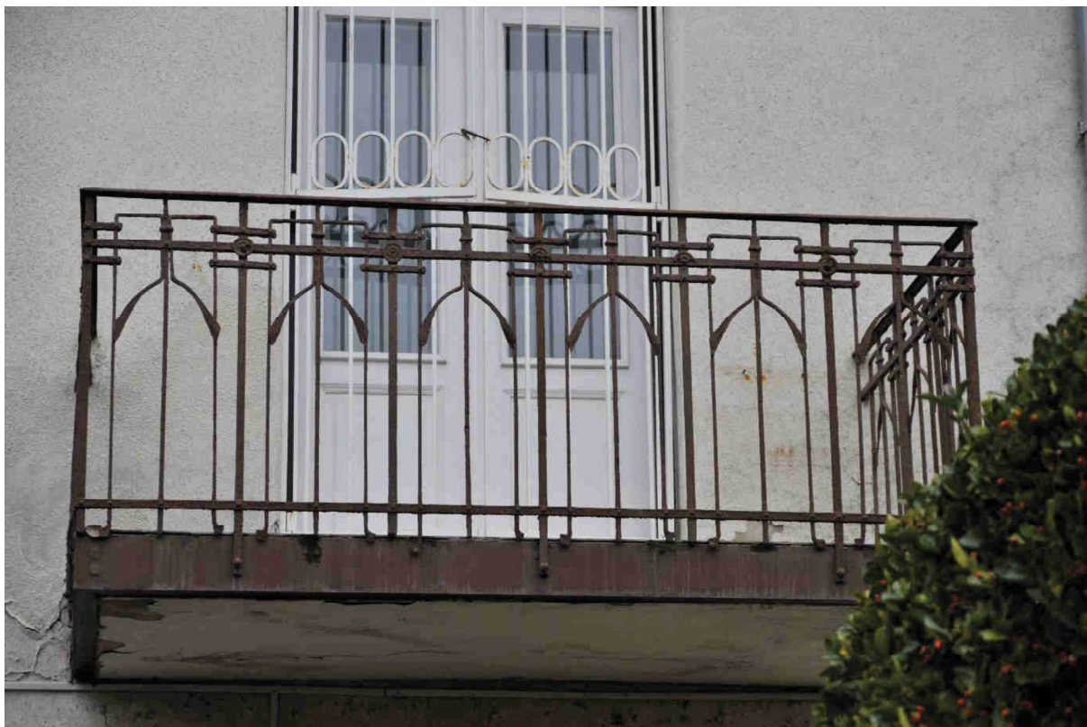
7. kép Keleti homlokzat, erkélykorlát
