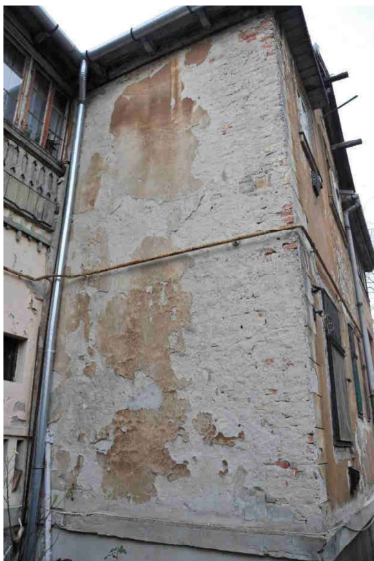
33. kép Az északkeleti homlokzat északi, előrelépő részének oldalhomlokzata
