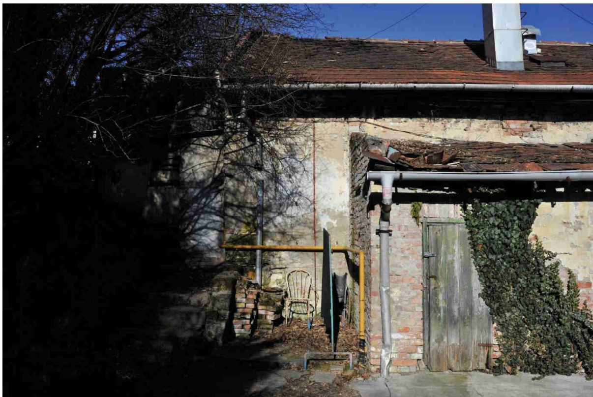
36. kép Belső udvar, keleti homlokzat, részlet
