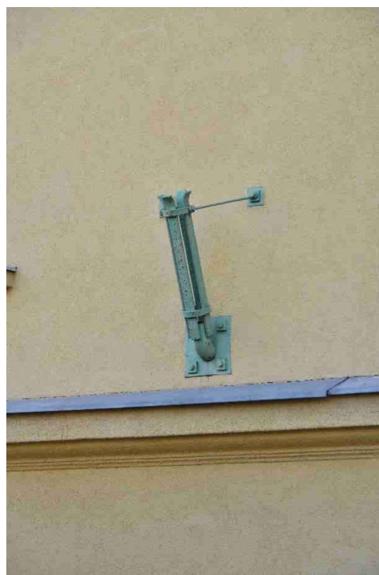
24. kép Zászlórúdtartó a főhomlokzaton
