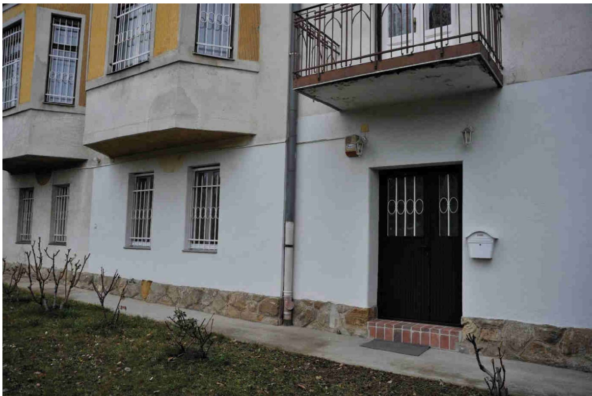
15. kép A keleti homlokzat földszinti homlokzatszakasza észak felől
