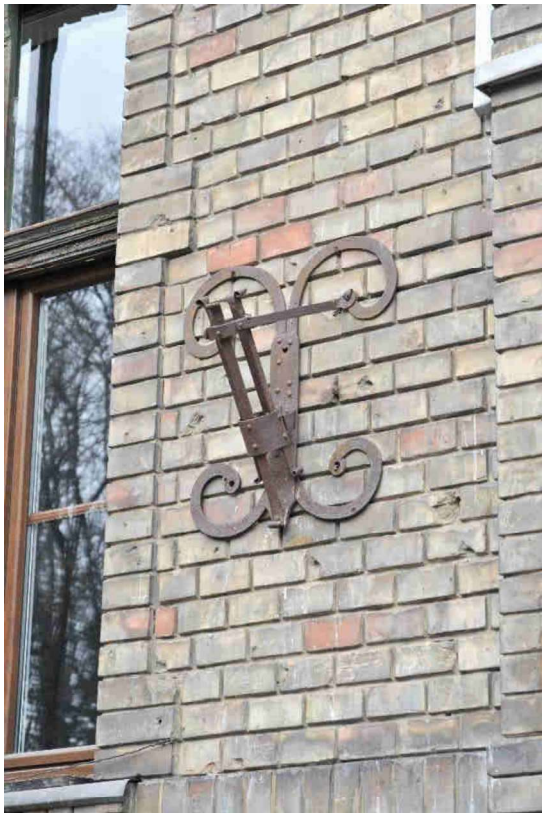
12. kép Zászlórúd-tartó a főhomlokzaton
