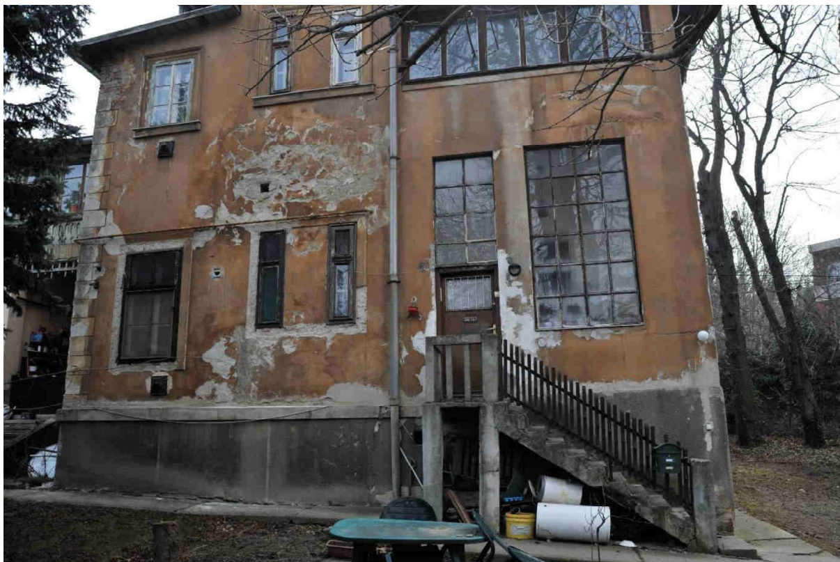
29. kép Északkeleti homlokzat északi szakasza
