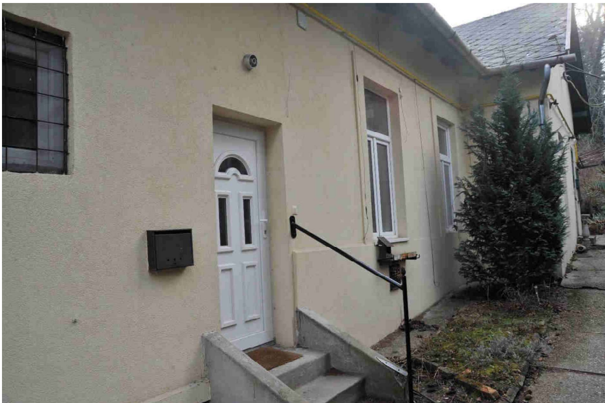
52. kép Melléképület északnyugati homlokzat
