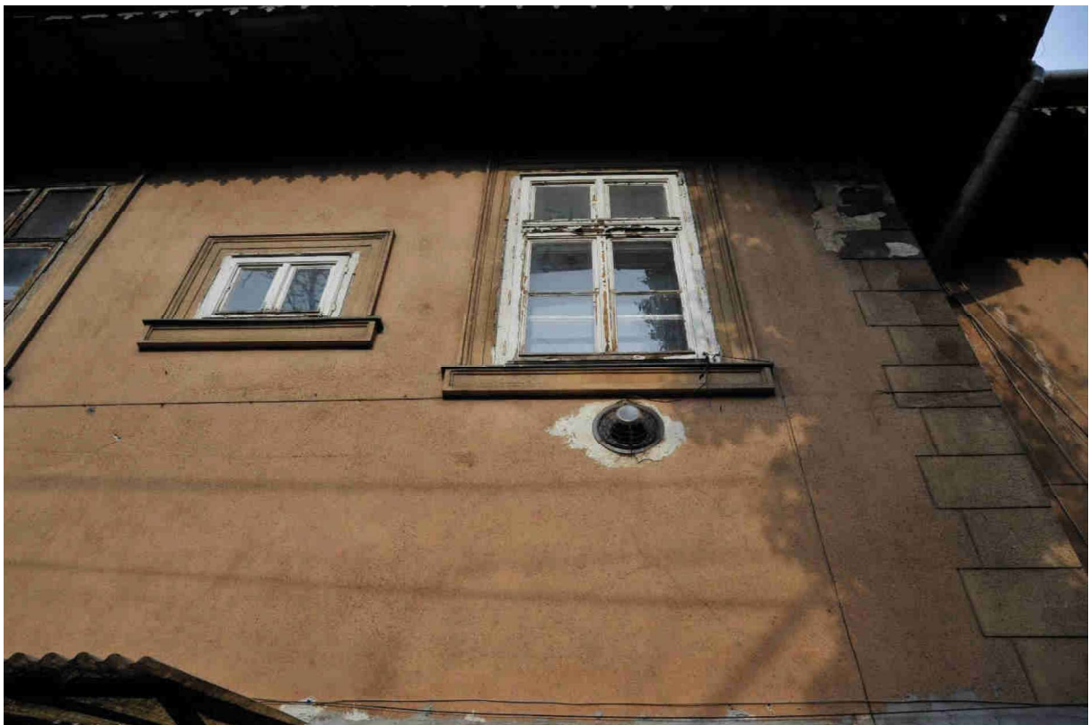
19. kép Az épülettel egykorú ablakok a délnyugati homlokzat emeletén
