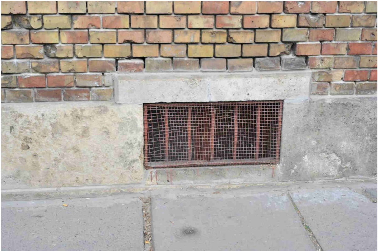
11. kép Mészkö lábázat és pincszellőző
