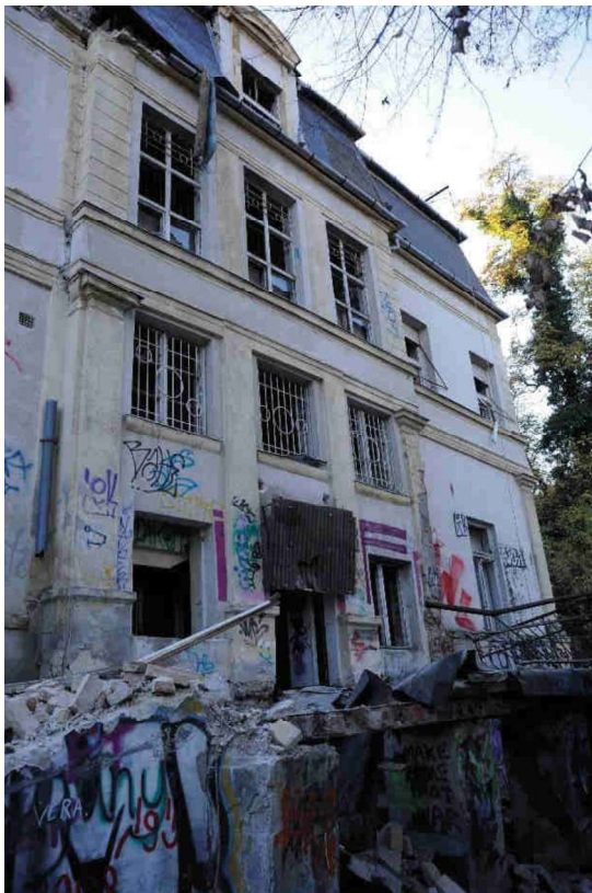
2. kép Északi homlokzat, részlet
