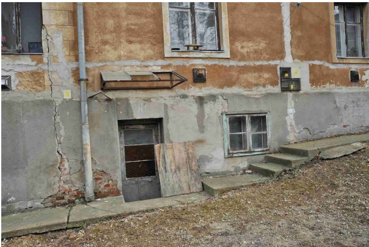
23. kép Északnyugati homlokzat alsó szakasza
