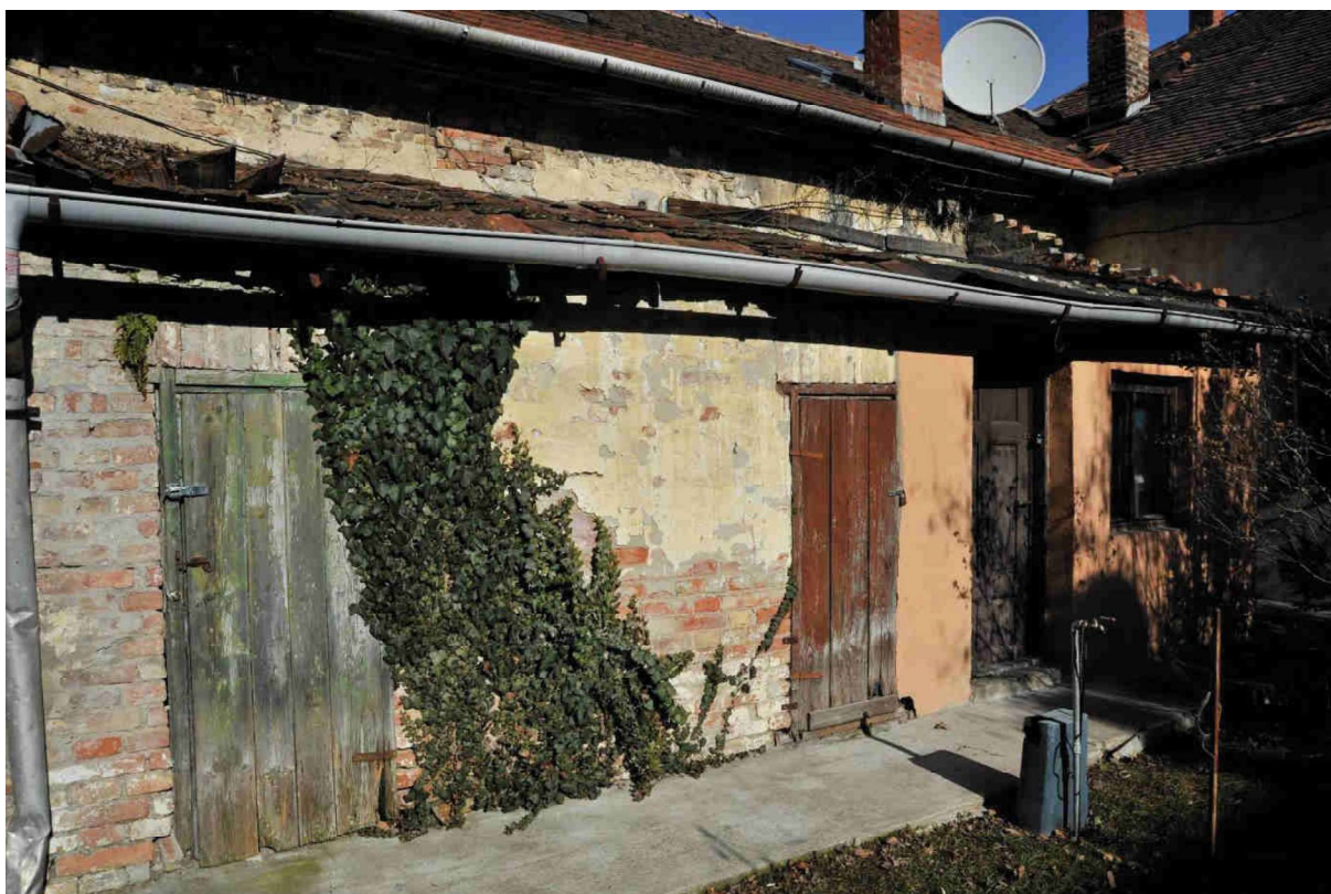
37. kép Belső udvar, keleti homlokzat, részlet
