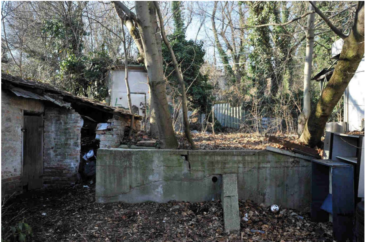
44. kép Melléképület, hátsó (déli) kert, betontámfal
