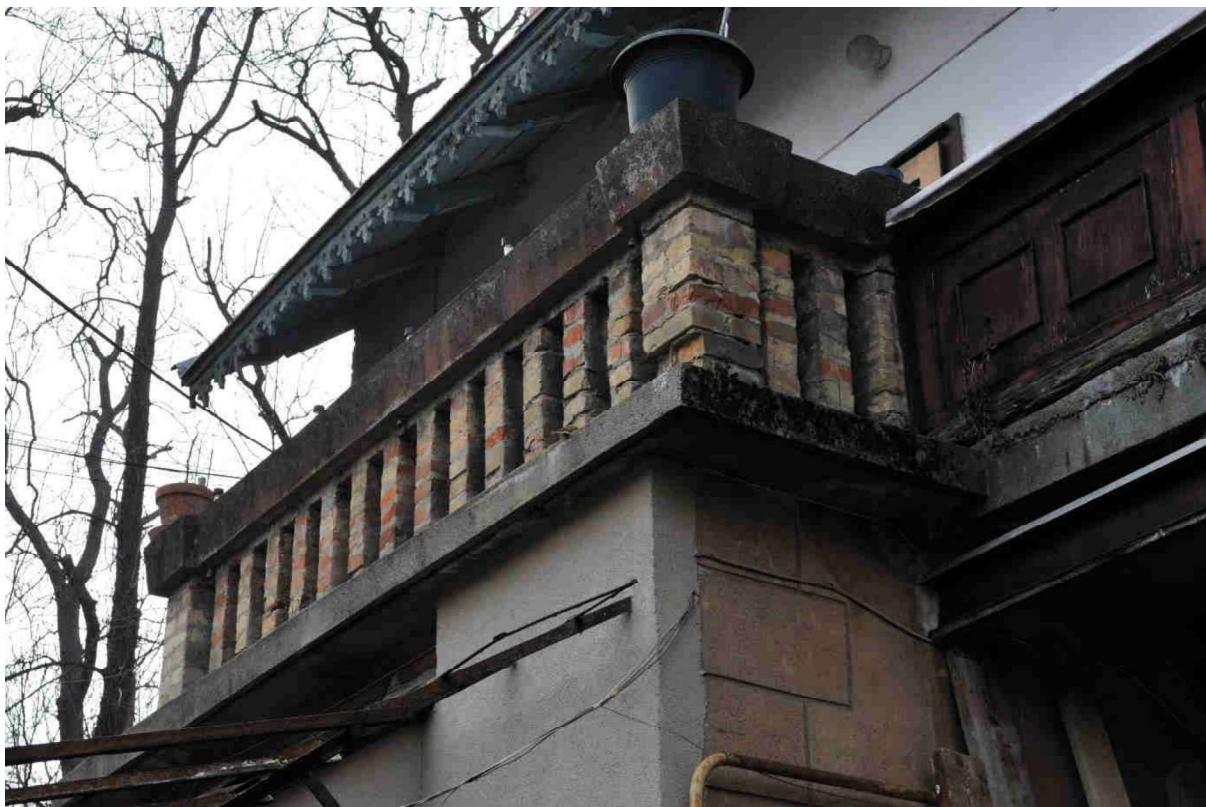
42. kép Délkeleti homlokzat, emelet
