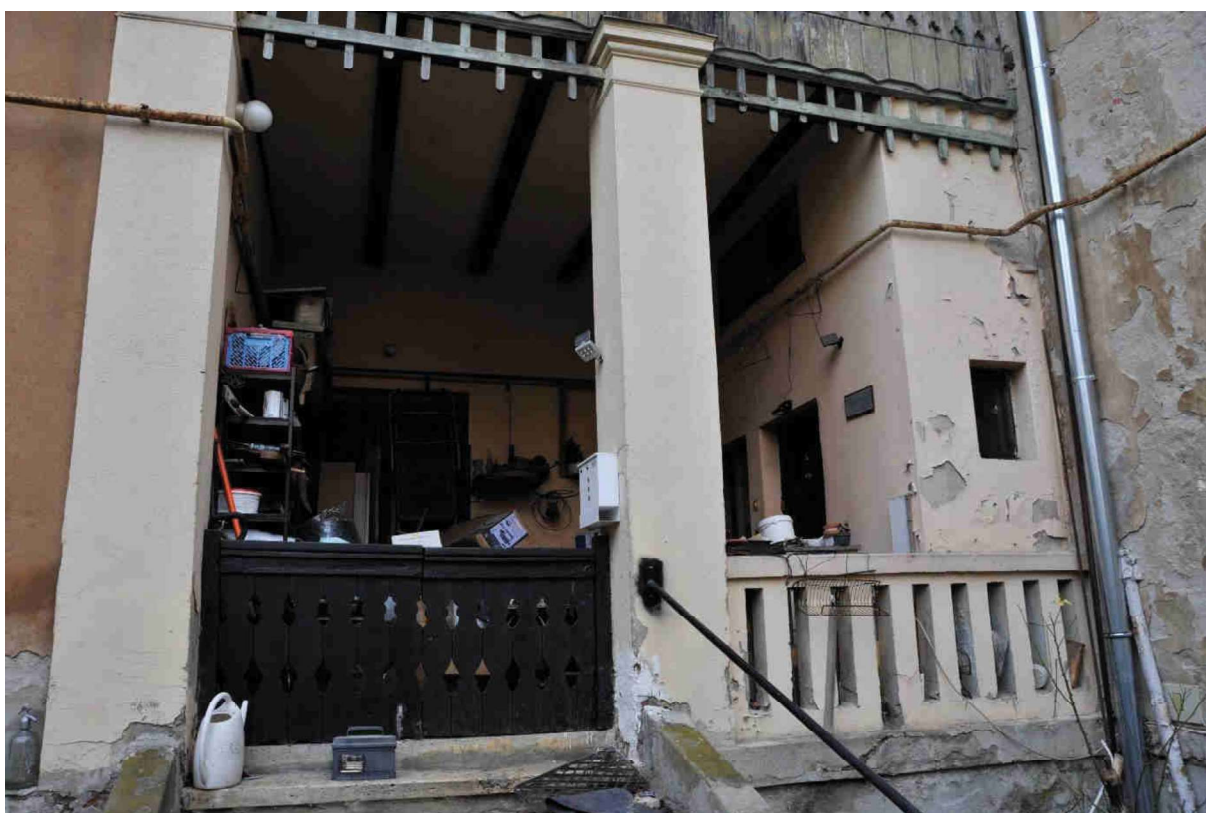
37. kép Veranda az északkeleti homlokzaton
