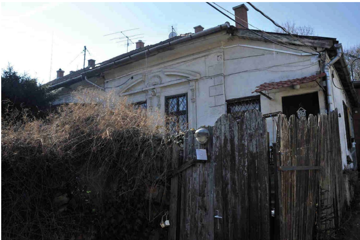
25. kép Északi homlokzat, jobb oldali szakasz
