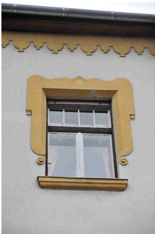
8. kép Keleti homlokzat, ablak, keretezése és zárópárkány
