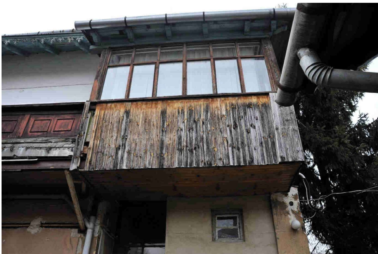
45. kép Délkeleti homlokzat, emelet
