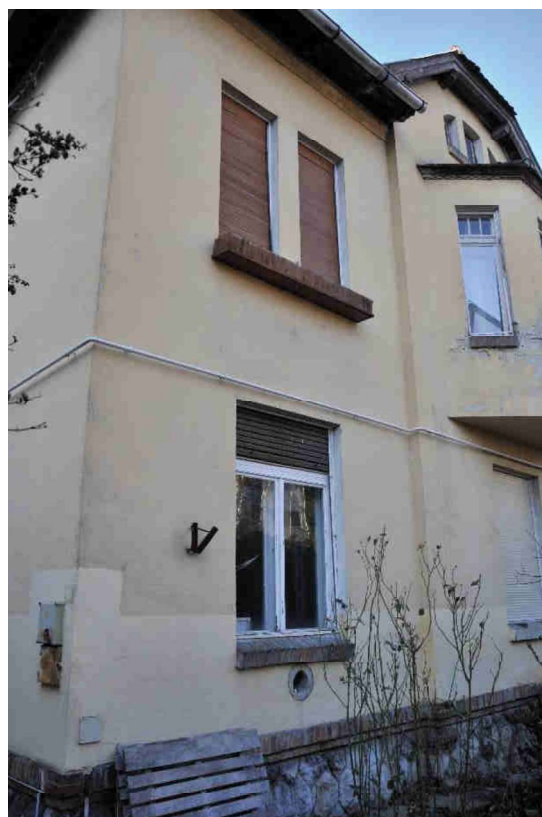
37. kép Utcai homlokzat, bal oldali szakasz
