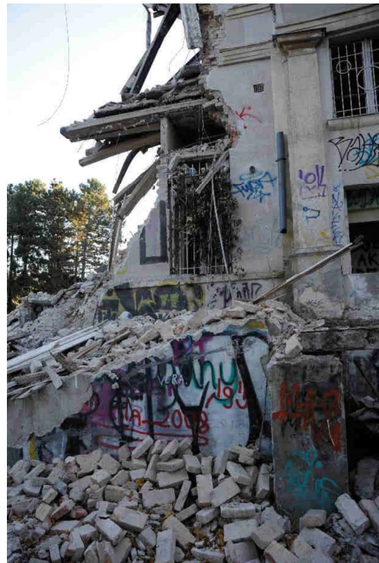
3. kép Északi homlokzat, részlet
