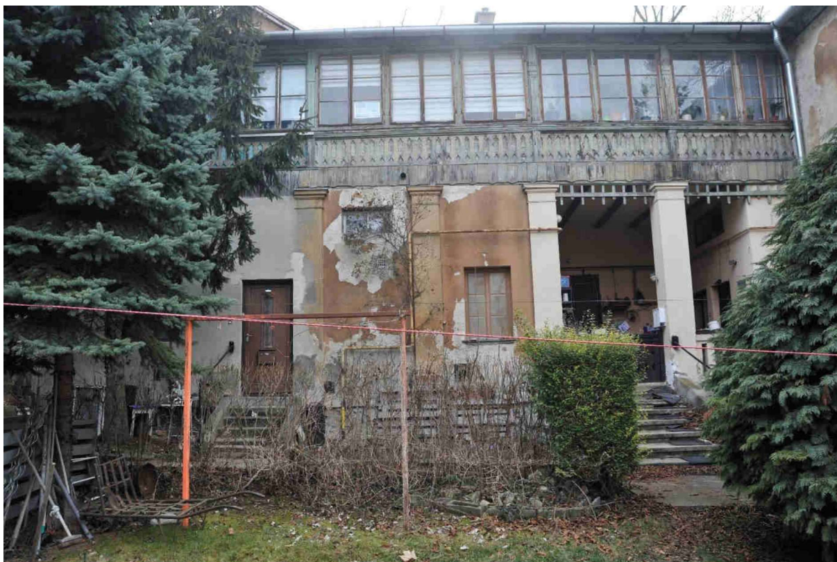
35. kép Északkeleti homlokzat középrésze
