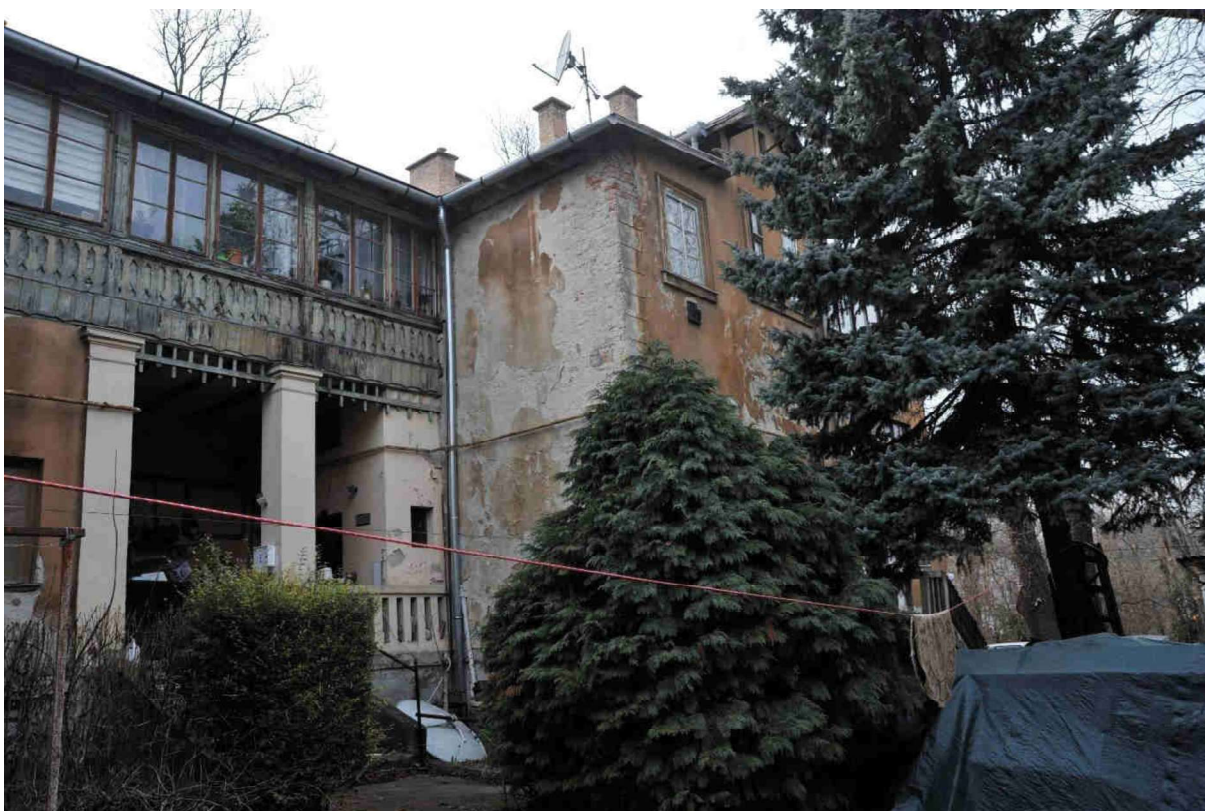
32. kép Északkeleti homlokzat az előkert felől, összkép
