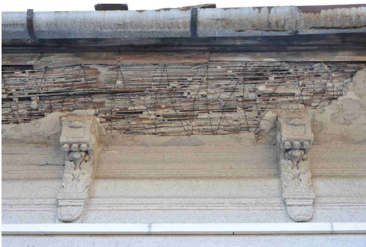
23. kép Északi homlokzat, eresz és konzolok
