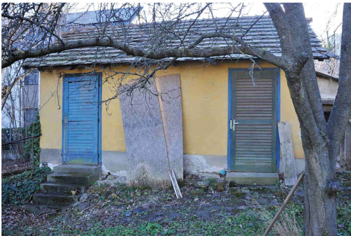
26. kép Kerti melléképület
