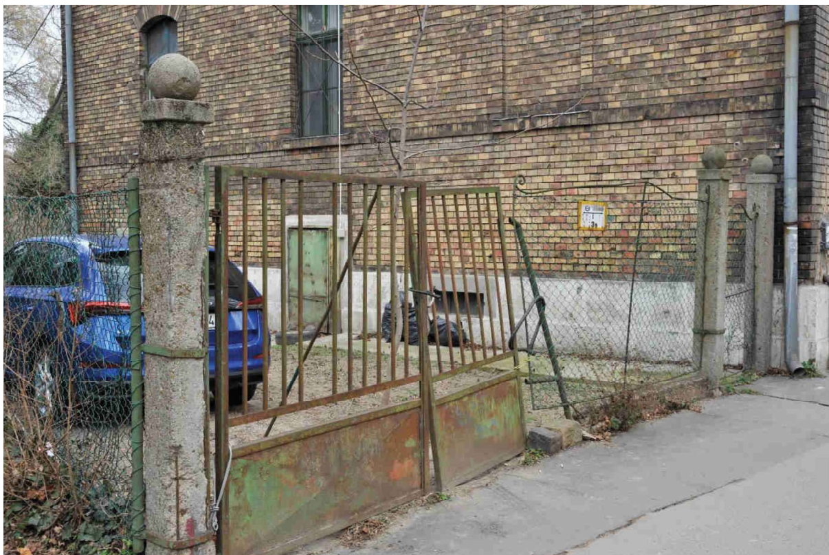
22. kép Kapu és kerítés az épülettől nyugatra
