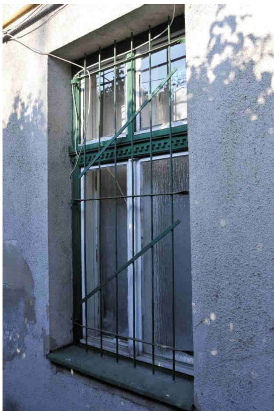
30. kép Ablak a keleti homlokzaton
