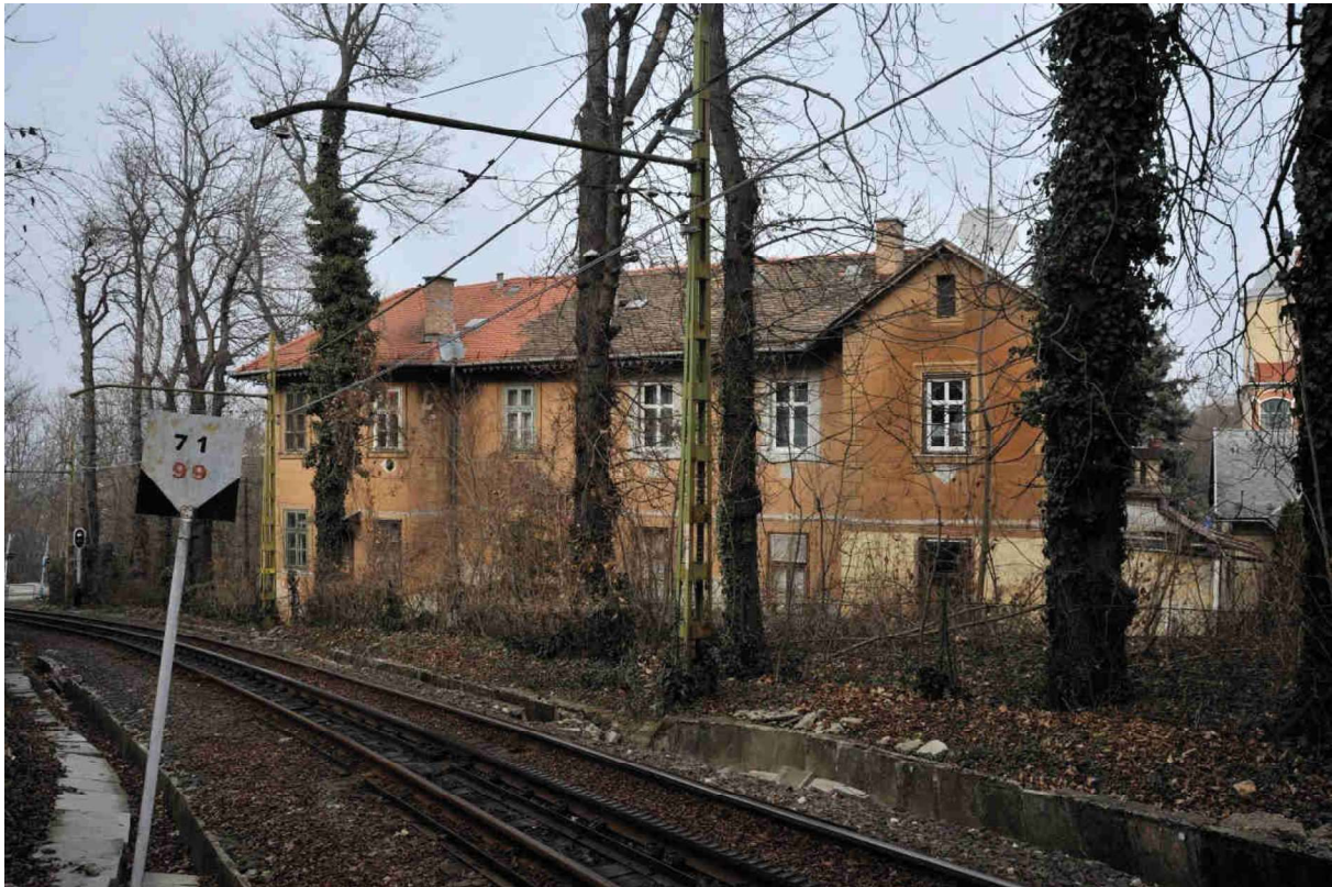
8. kép Főépület. délnyugatii homlokzat a fogaskerekű vasút felől
