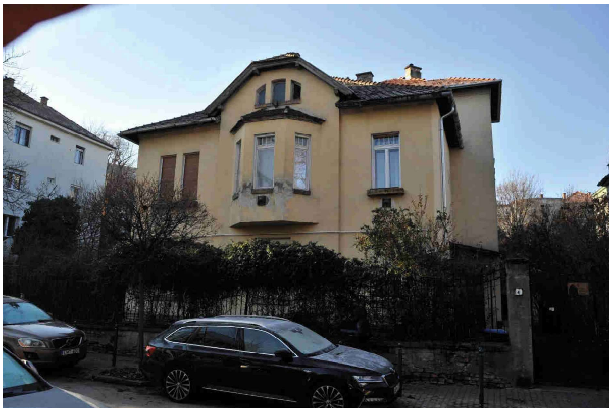
20. kép Északkeleti (utcai) homlokzat
