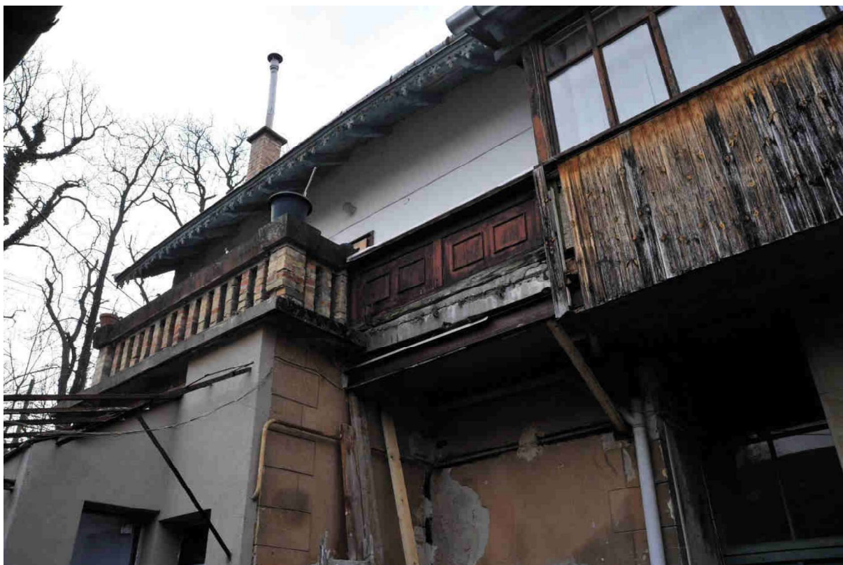
43. kép Délkeleti homlokzat, emelet
