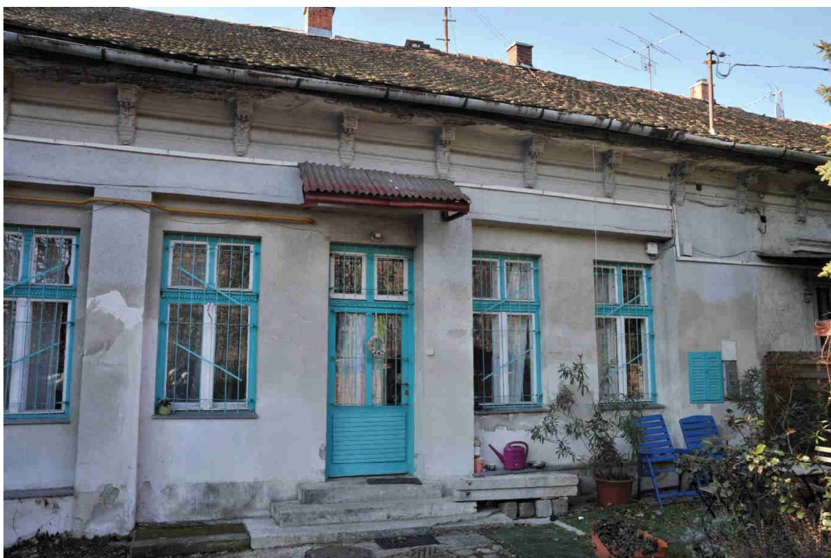
20. kép Északi homlokzat, középső szakasz
