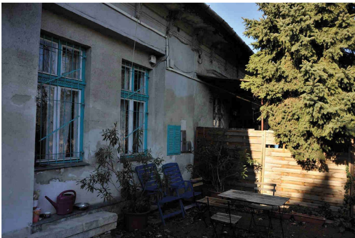
21. kép Északi homlokzat jobb oldali szakasz
