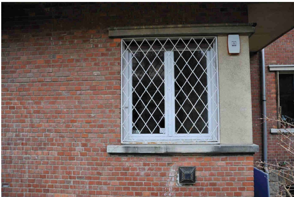
46. kép Ablak a déli homlokzaton
