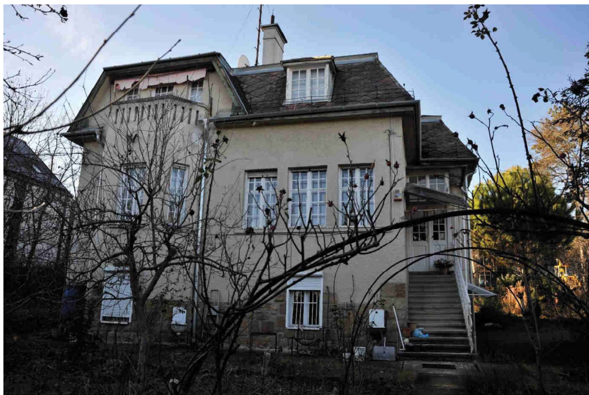
8. kép Keleti homlokzat
