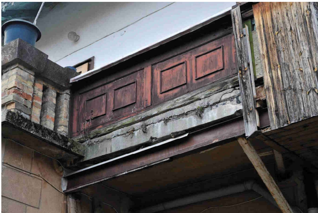
44. kép Délkeleti homlokzat, emelet
