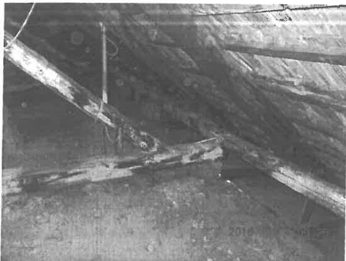
5. kép Kötőgerenda és szaru valamint talpszelemen átázása, kifordulása.
