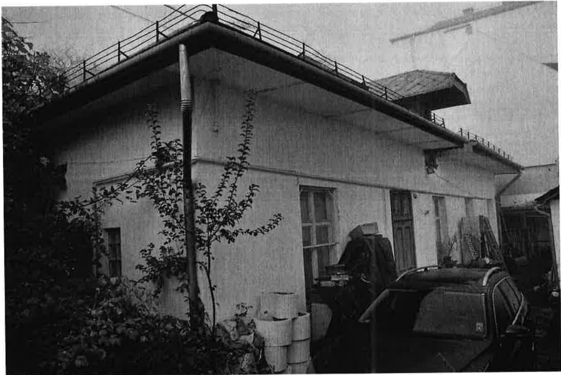
5. kép A nagyobb melléképület északkeleti homlokzata
