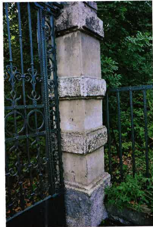
11. kép Jobb oldali kapupillér, középső szakasz
