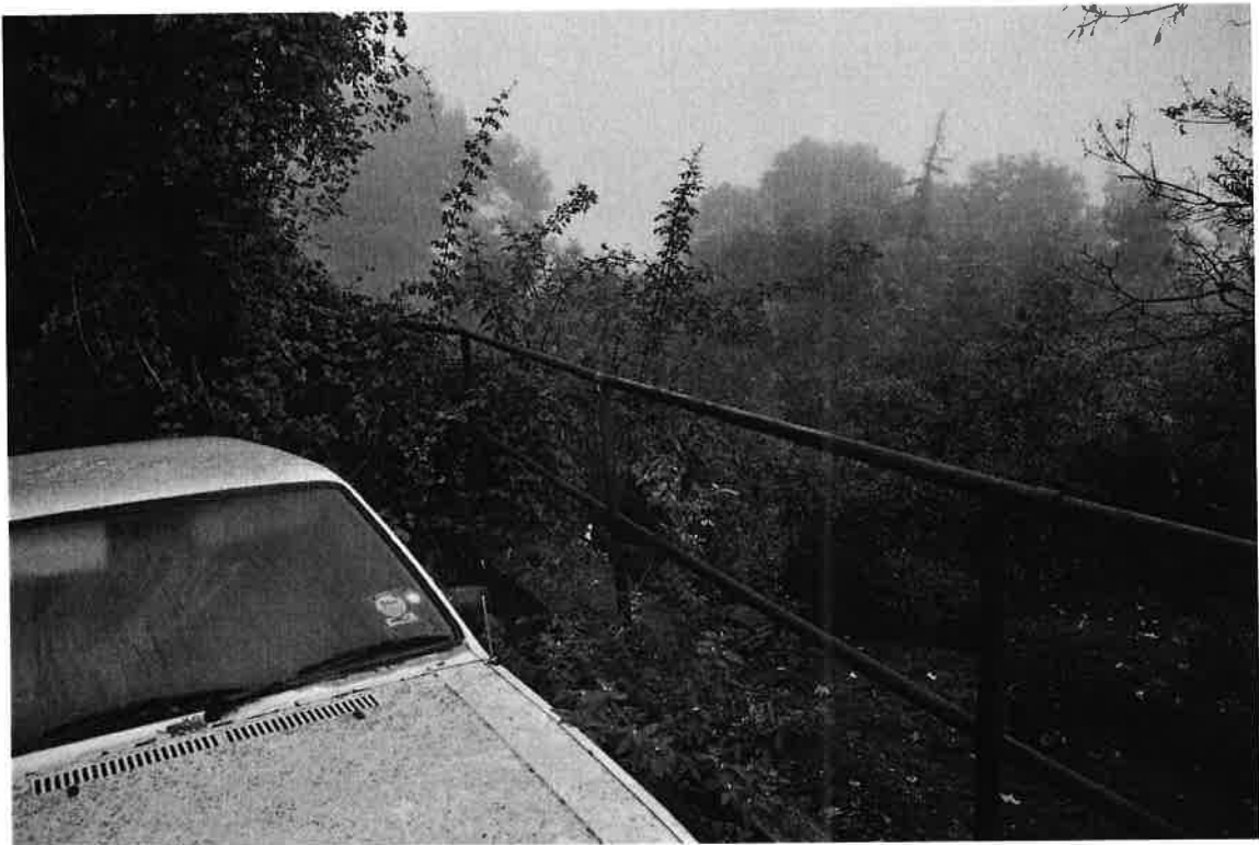
6. kép Vascsőkorlát a mellvédfal felett, a melléképületekhez vezető rámpa mellett
