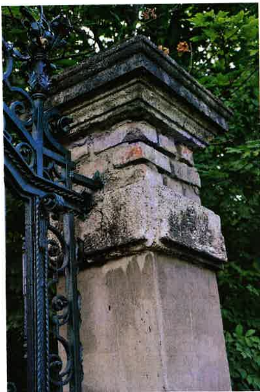
10. kép Jobb oldali kapupillér, felső szakasz
