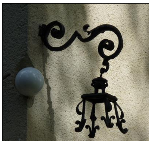
54. kép kovácsoltvas épületdíz („lámpatartó”)
