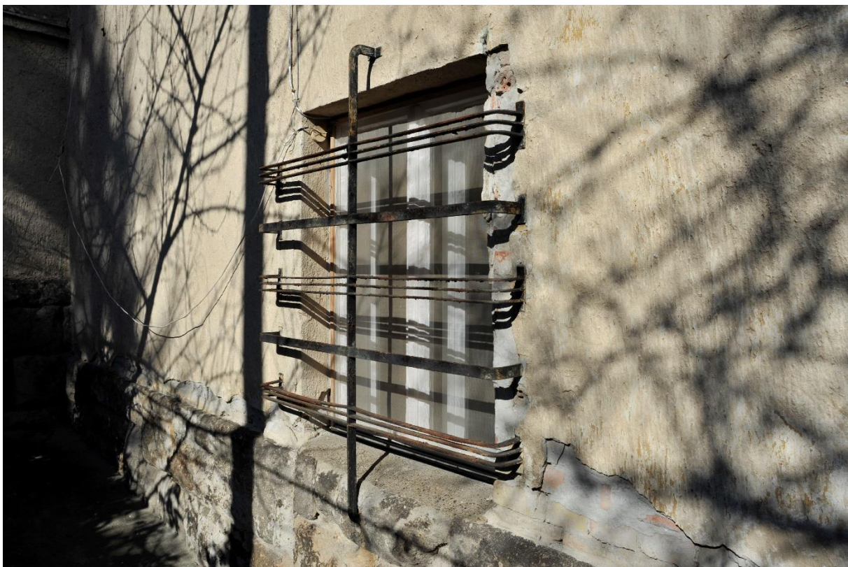
31. kép Az egykori házmesterlakás ablaka a pincszint délnyugati homlokzatán
