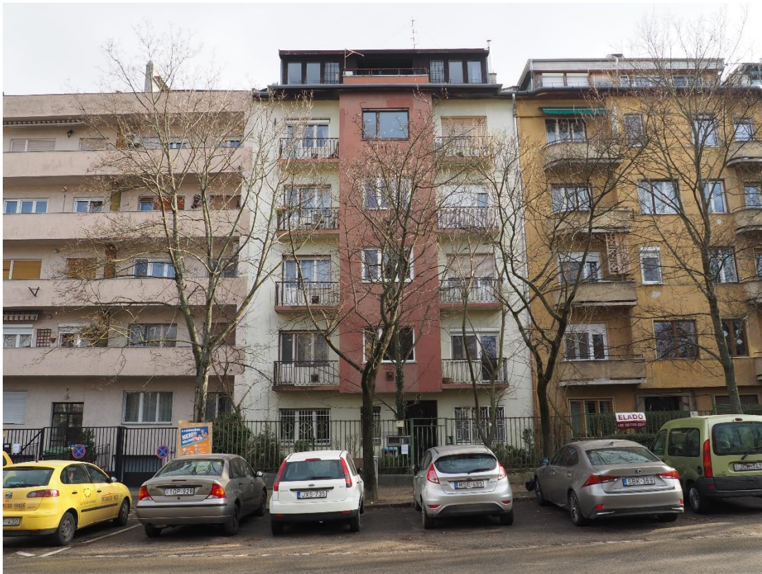
6. kép Németvölgyi út 28/B, 2021
