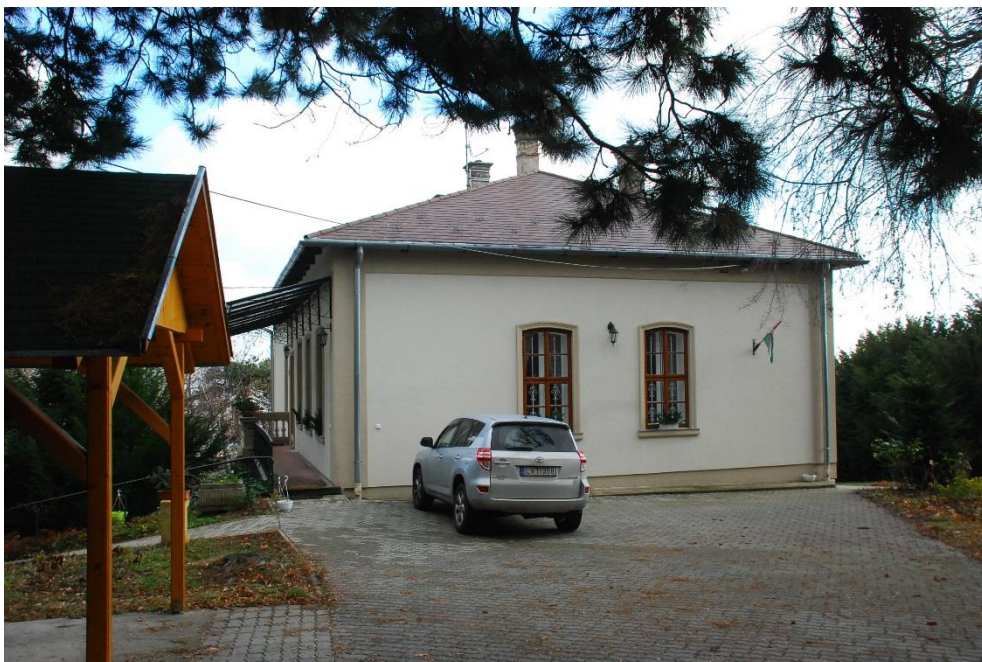
Nézet a hátsó homlokzat felől, 2018
