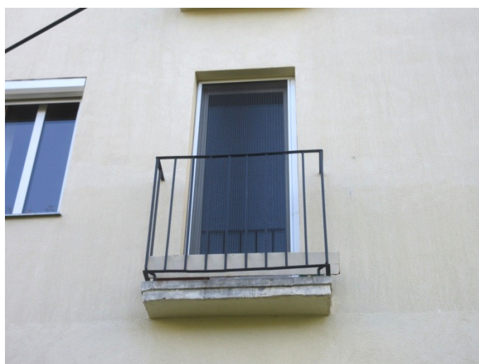
82.-84. Emeleti homlokzati nyílászárók – a nyíláskiosztások építéskoriak, de a bennük lévő ablakok, ajtók zöme már újabb nyílászáró
