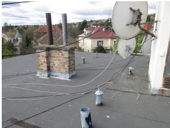
192.-196. A tetőfelépítmény és a lapostető nézetei - az épület eredetileg is lapostetővel készült, a tetőfelépítmény épülete eredeti építéskori szerkezet. A jelenlegi tetőszigetelés 2020-ban készült
