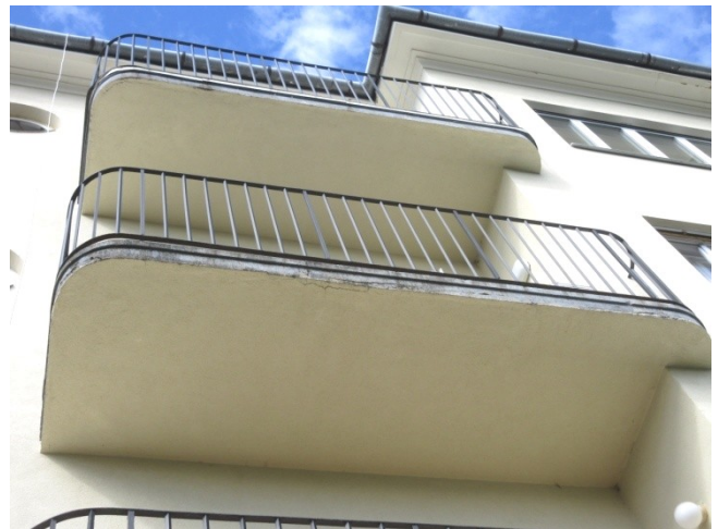
37.-39. A homlokzat bal (D-i) oldali szakaszának II. és III. emeleti részlete - a nyíláskiosztások és erkélyek építéskoriak. A nyílásokban lévő páros-ablakok tokkeretei eredetiek, de a bennük lévő nyílászáró újabb szerkezetek. A két körablak nyílászárója eredeti építéskori
