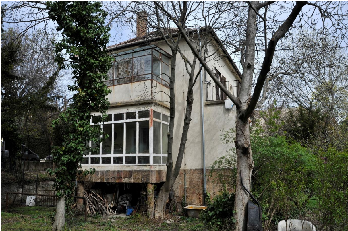
19. kép Az épület déli homlokzata
