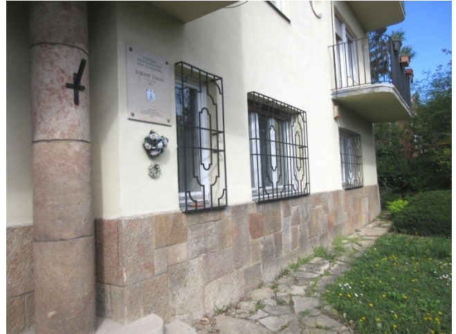
27.,28. A főhomlokzat bal (D-i) és jobb (É-i) homlokzati részének lábazati szakasza – a kőoszlopok és a rusztikus temeskő lábazati burkolat eredeti építéskori, történeti értékű kialakítás és szerkezet
