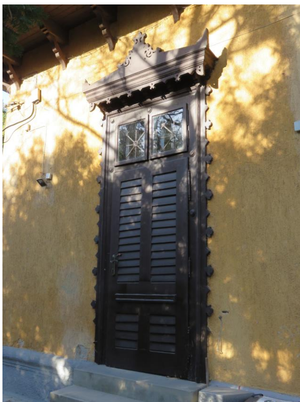
28. kép Fűrészelt díszű ablakkeretezés és doboz szemöldökdísz az oldalhomlokzaton
