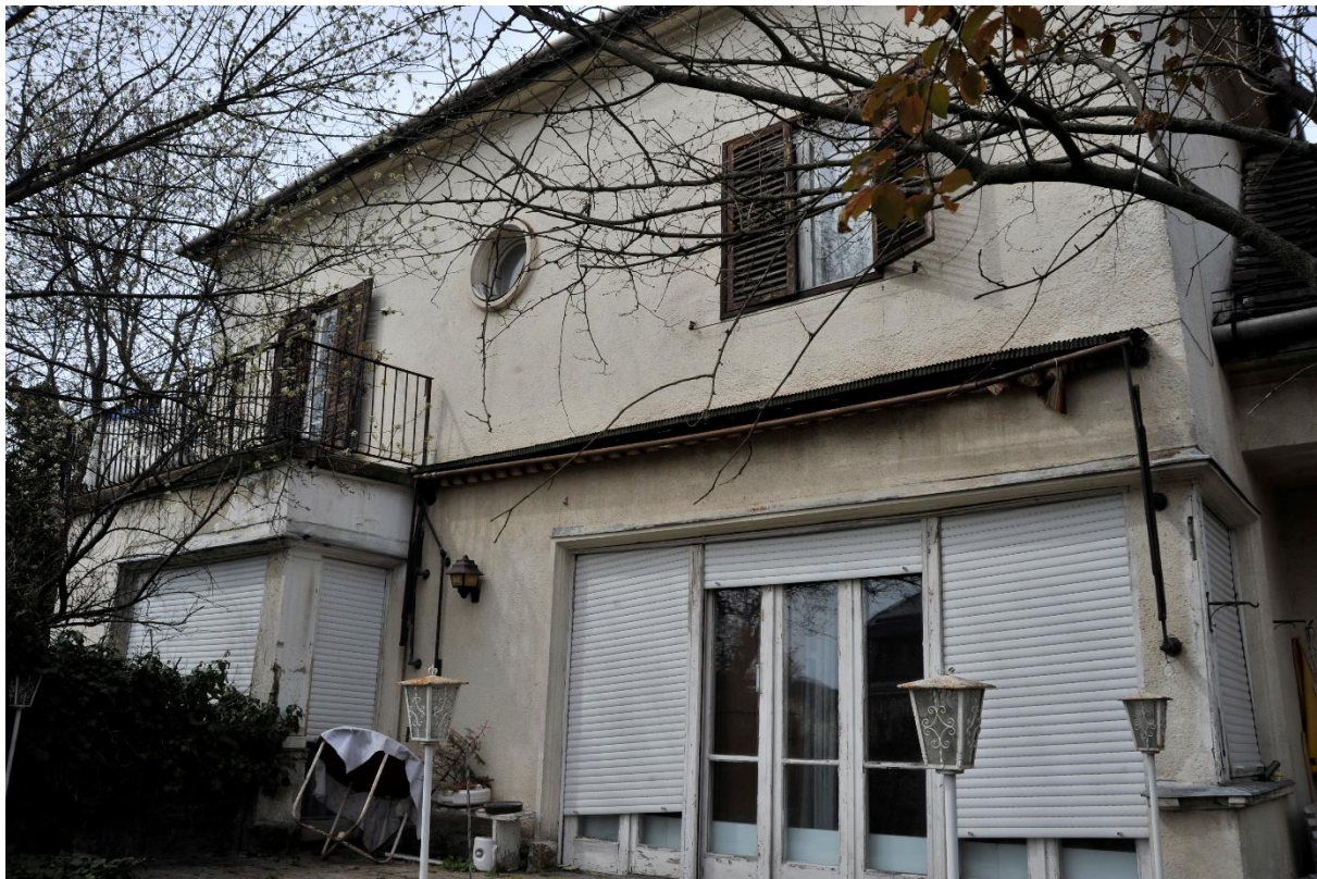
13. kép Keleti homlokzat, részlet
