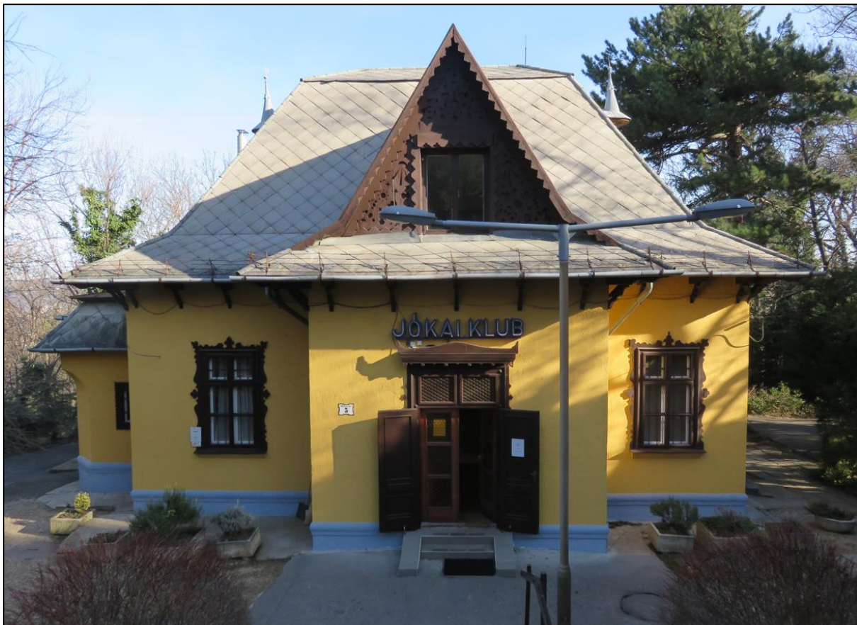
1. kép Főhomlokzat az utca (délnyugat) felé
