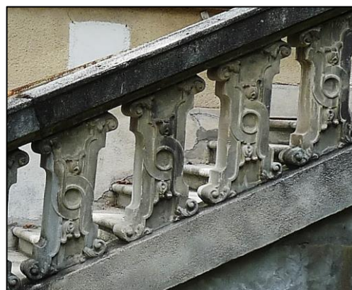
49. kép épületre jellemző műkő lépcsőkorlát díszítése
