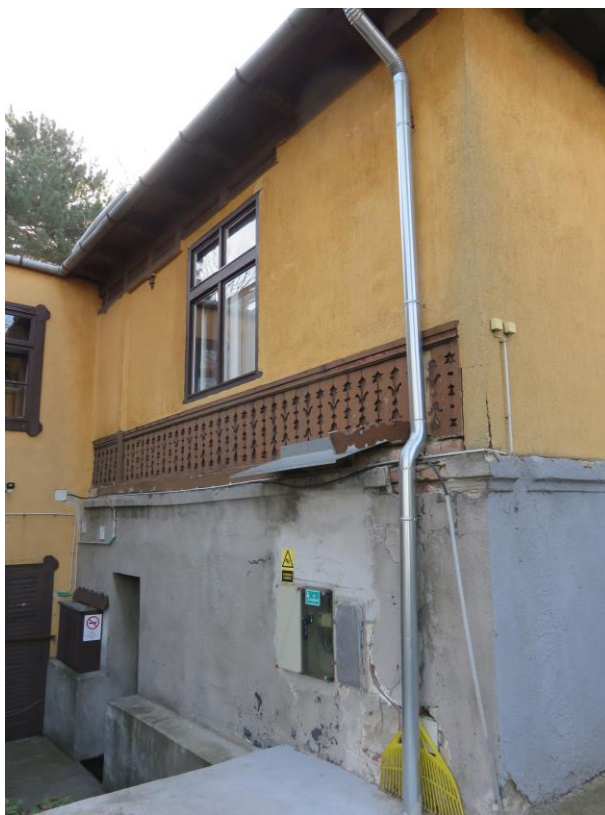
11. kép A villaépület északi sarka, a beépített verandával
