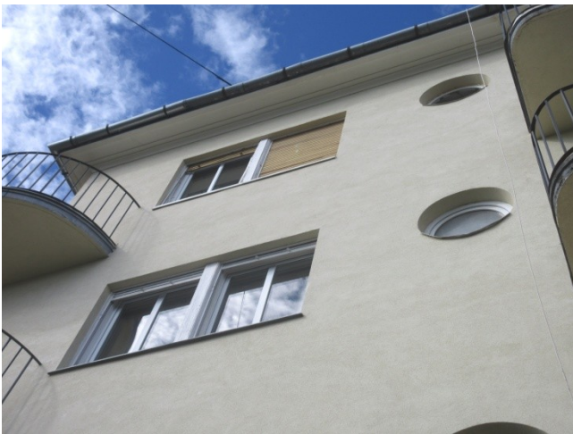
37.-39. A homlokzat bal (D-i) oldali szakaszának II. és III. emeleti részlete - a nyíláskiosztások és erkélyek építéskoriak. A nyílásokban lévő páros-ablakok tokkeretei eredetiek, de a bennük lévő nyílászáró újabb szerkezetek. A két körablak nyílászárója eredeti építéskori
