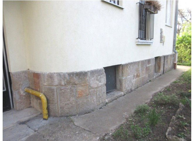
71.,72. A hátsó homlokzat ívesen kialakított terméskő lábázatának részletei - történeti értékű kialakítás
