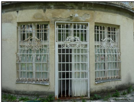
42. kép Északi homlokzat részlet
