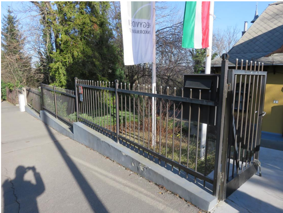
38. kép Az utcai kerítés nem képvisel helyi építészeti értéket
