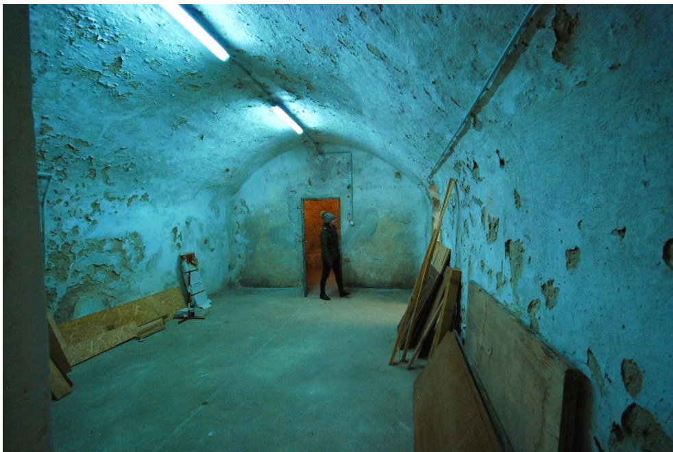
A kétraktusos pince dongaboltozatos helyiségei, a sziklába vájt végük előtti óvóhely-válaszfalakkal, 2018.
