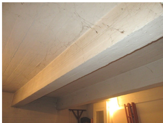
210.-214. Az egykori óvóhely bejárata és a helyiség nézetei - eredeti építéskori kialakítás, vasbeton szerkezeti falak és alubordás vb. födém
