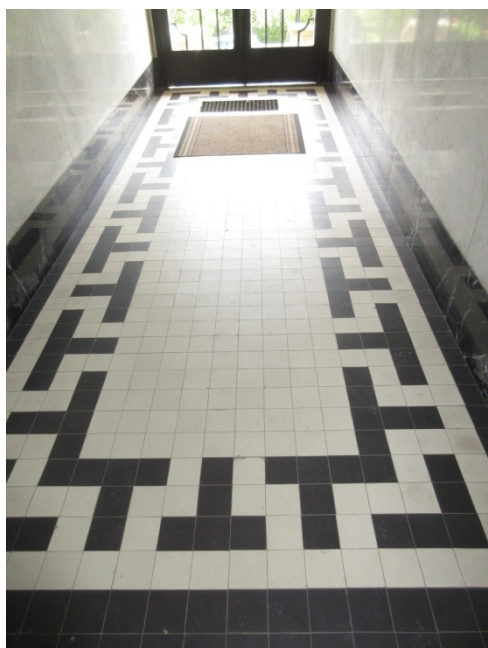
106.-109. A kapualj padlóburkolatának és födémének nézetei a lépcsőház és az utca felé – a tükörbe rakott geometrikus mintázatú fekete-fehér márványmozaik (mettlachi) padlóburkolat és az ovális tükörrel díszített síkmennyezet a lámpával eredeti építéskori, történeti értékű elemek
