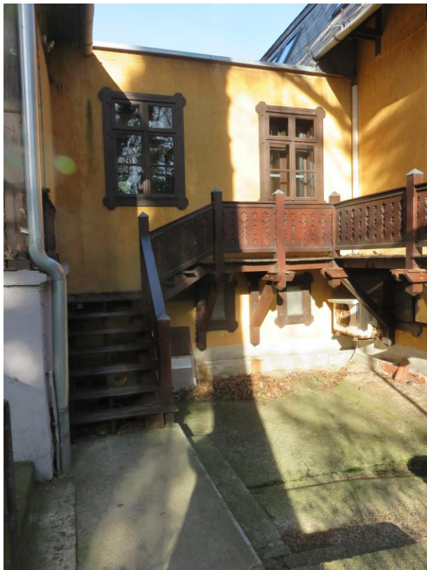
20. kép A villaépület és a toldaléképület közötti nyaktag a keleti oldalról
