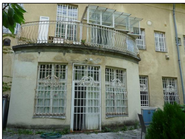
40. kép Északi homlokzat részlet
