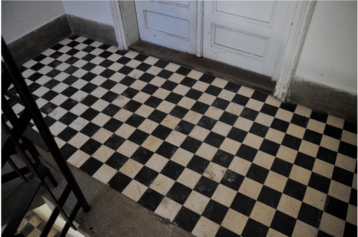
42. kép Mettlachi padlóburkolat a földszinti lakás bejárata előtt
