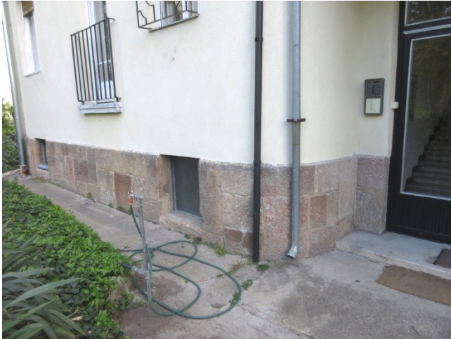
71.,72. A hátsó homlokzat ívesen kialakított terméskő lábázatának részletei - történeti értékű kialakítás
