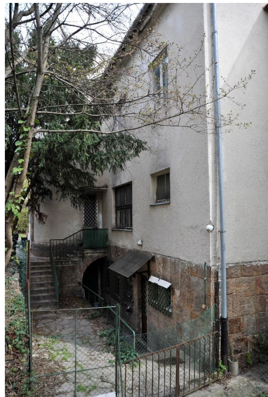
21. kép Az épület nyugati homlokzata, részlet
