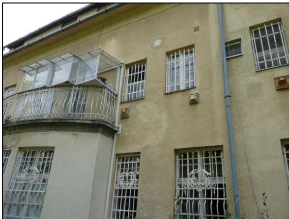
39. kép Északi homlokzat részlet
