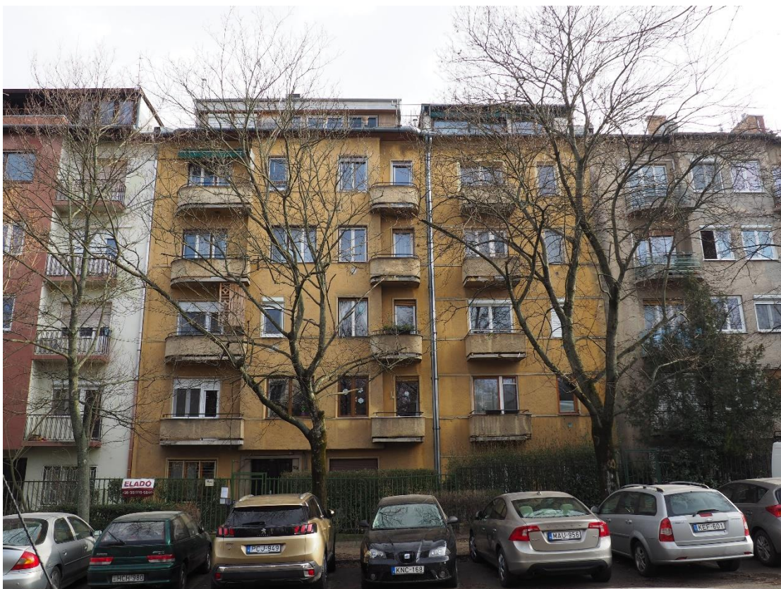
7. kép Németvölgyi út 30/A-B, 2021
