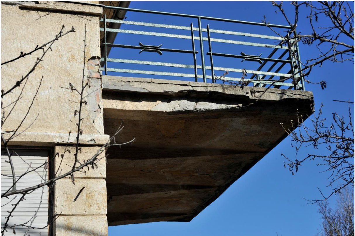
28. kép Szerkezeti problémák az emeleti erkélyen
