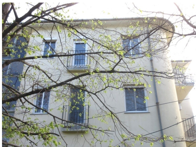
79.-81. A hátsó homlokzat emeleti szintjeinek részletei – építészeti, történelmi értékű kialakítás
