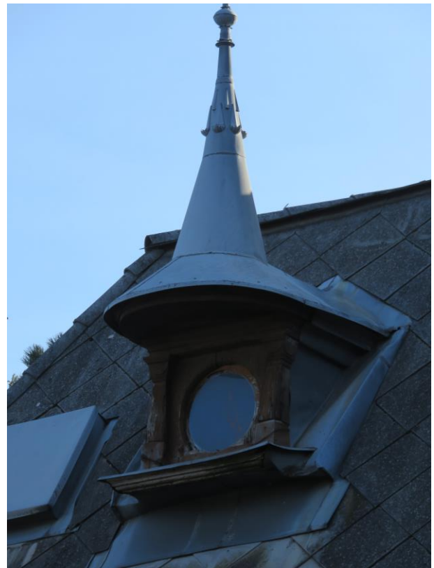
27. kép Padlásszellőző az északnyugati oldalon
