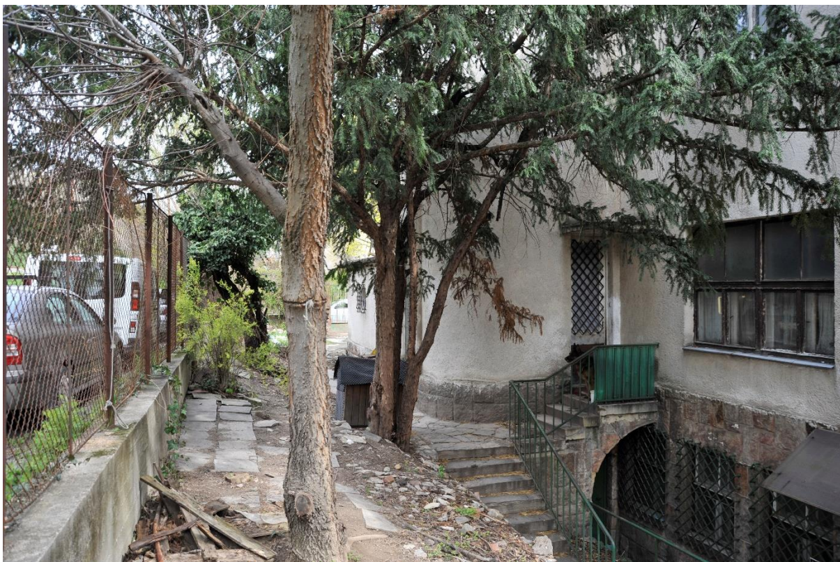
22. kép Az épület nyugati homlokzata és az oldalkert
