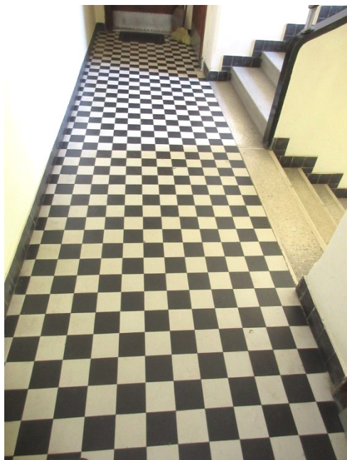
154.,155. Az I. emeleti (magasföldszinti) pihenő padlóburkolata és födéme – a fekete-fehér márványmozaik lapburkolat építéskori burkolat
