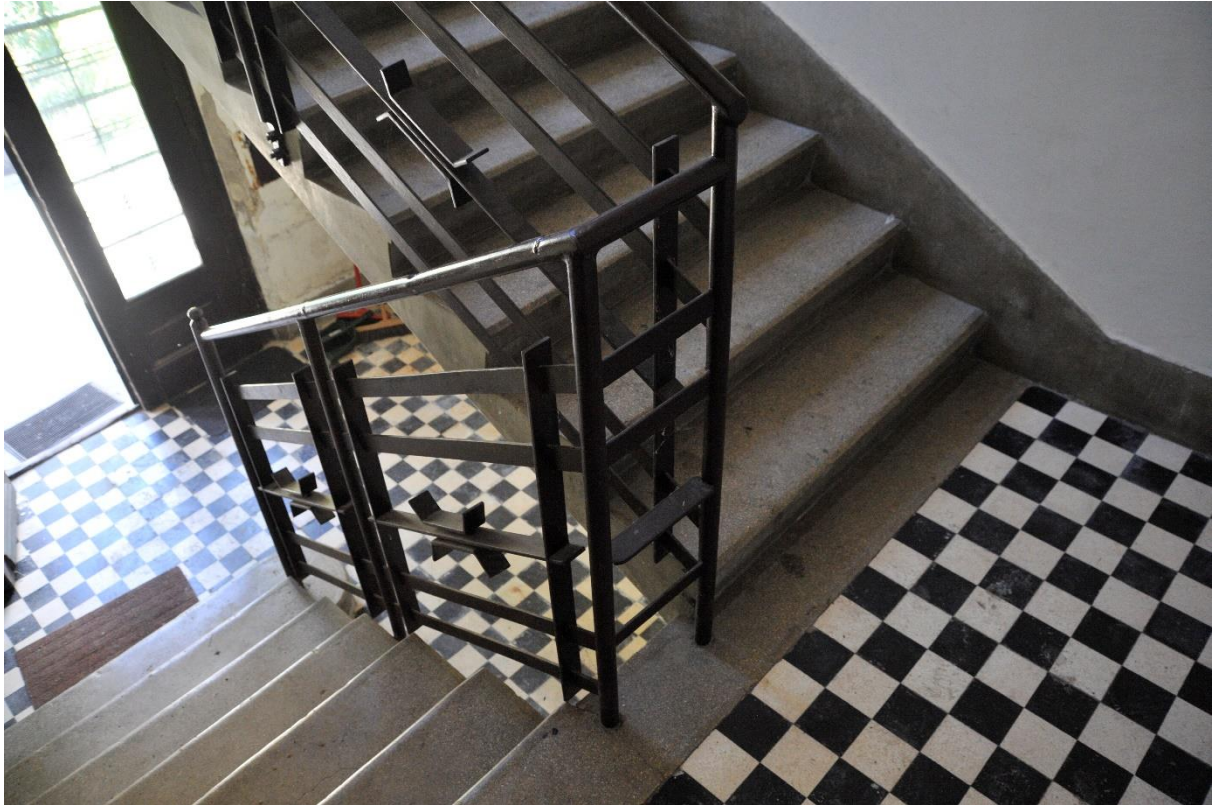
40. kép Lépcsőház, földszinti pihenőlemez és korlát
