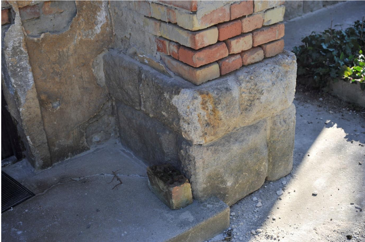
21. kép Mésző lábázat és lehullott vakolat az északnyugati homlokzaton a bejárat mellett
