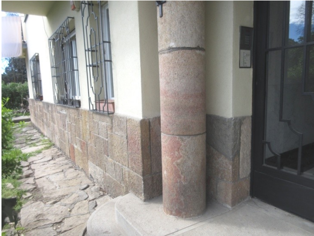
27.,28. A főhomlokzat bal (D-i) és jobb (É-i) homlokzati részének lábazati szakasza – a kőoszlopok és a rusztikus temeskő lábazati burkolat eredeti építéskori, történeti értékű kialakítás és szerkezet
