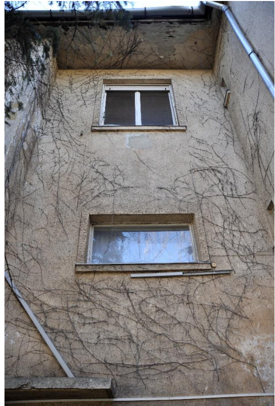
15. kép Északkeleti homlokzat, részlet
