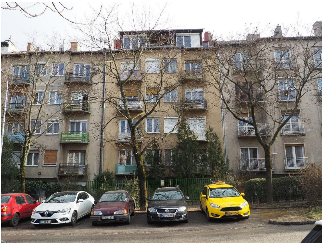
9. kép Németvölgyi út 32/B, 2021
