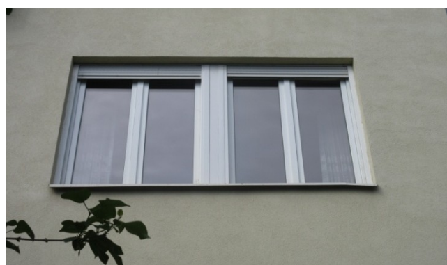
24.-26. A zárterkélyes középrizalit nézete és az I., II. és III. emeleti ablakok részletei – az ablaknyílások építéskoriak, de a bennük lévő páros elhelyezkedésű, egyrétegű, középen felnyíló ablakok újabb nyílászárók
