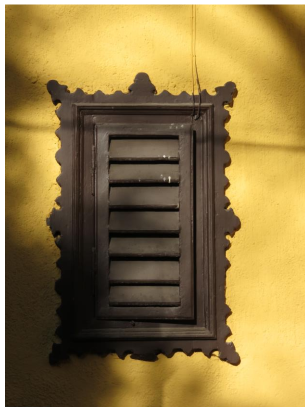
29. kép Fűrészelt díszű ablakkeretezés és doboz szemöldökdísz az oldalhomlokzaton
