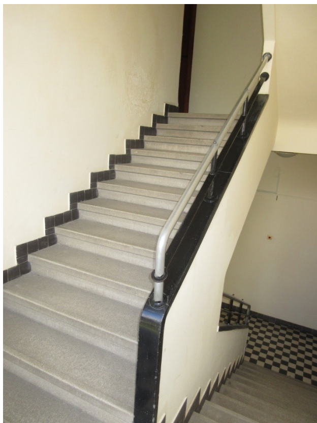
172.,173. A II. és III. emelet közötti lépcsőforduló nézete az udvarra nyíló ablakkal és a III. emeletre érkező lépcsőkar - eredeti építéskori, történeti értékű kialakítás és szerkezetek, burkolat, nyílászáró
