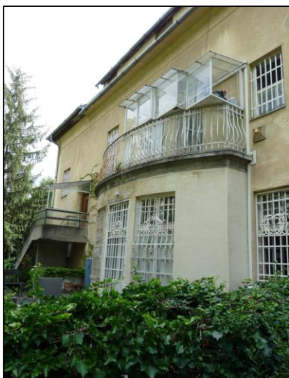
37. kép Északi homlokzat részlet
