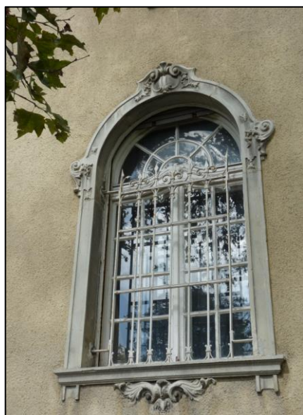
58. kép Nyílászáró részlet
