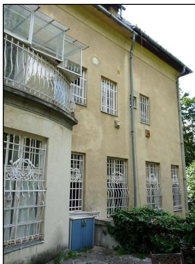
38. kép Északi homlokzat részlet
