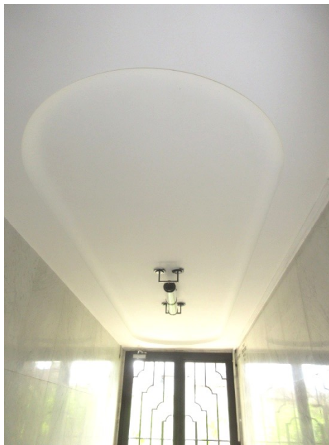
106.-109. A kapualj padlóburkolatának és födémének nézetei a lépcsőház és az utca felé – a tükörbe rakott geometrikus mintázatú fekete-fehér márványmozaik (mettlachi) padlóburkolat és az ovális tükörrel díszített síkmennyezet a lámpával eredeti építéskori, történeti értékű elemek
