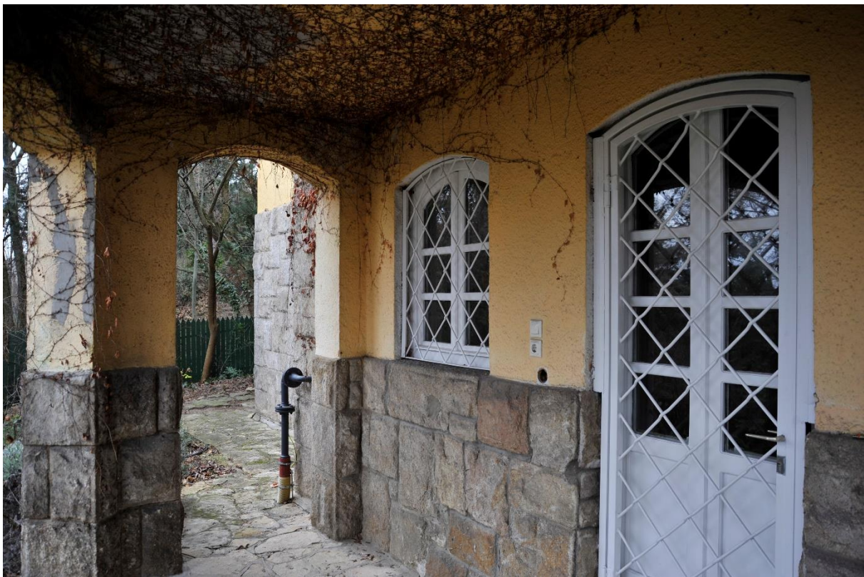
13. kép A keleti homlokzat emeletterasa alatti tér és homlokzatszakasz
