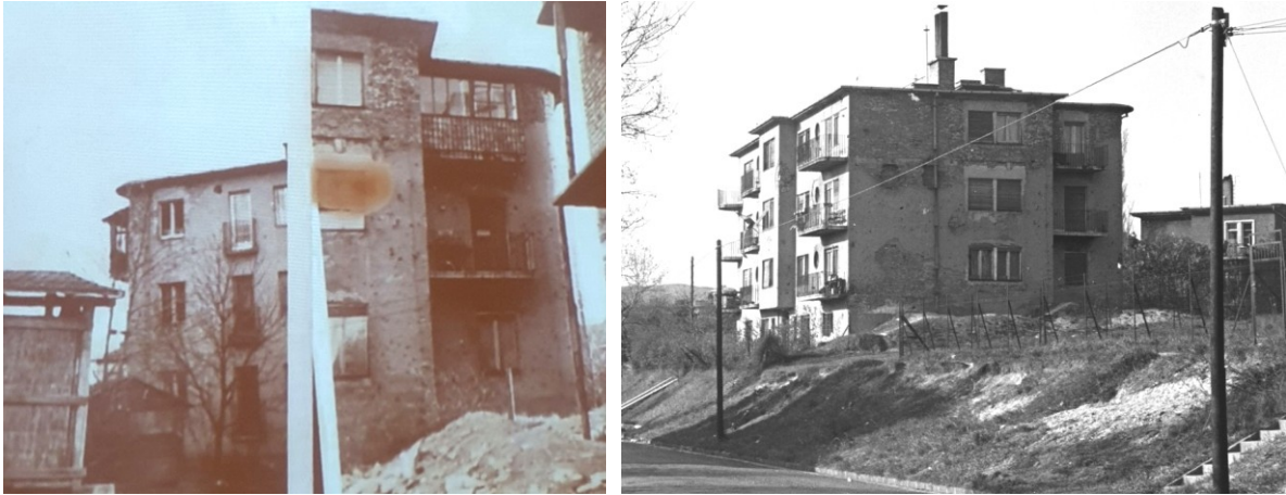
Az épület DK-i oldalhomlokzatának részlete 1945 után és a lakóház nézete 1960-ban
