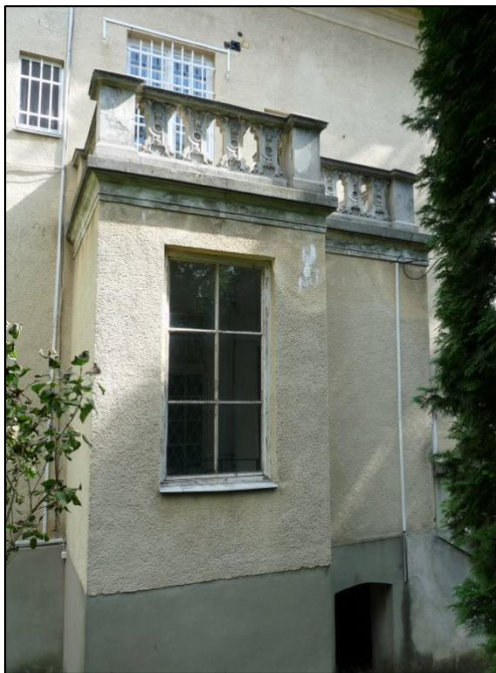
30. kép Keleti homlokzat részlet
