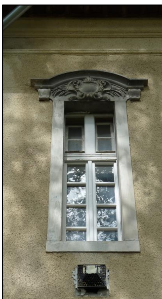
57. kép Nyílászáró részlet
