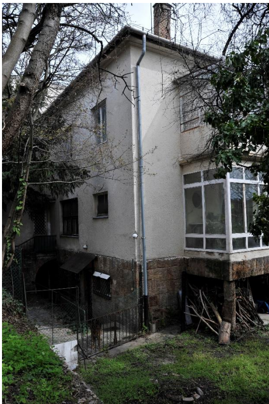
20. kép Az épület nyugati homlokzata, részlet
