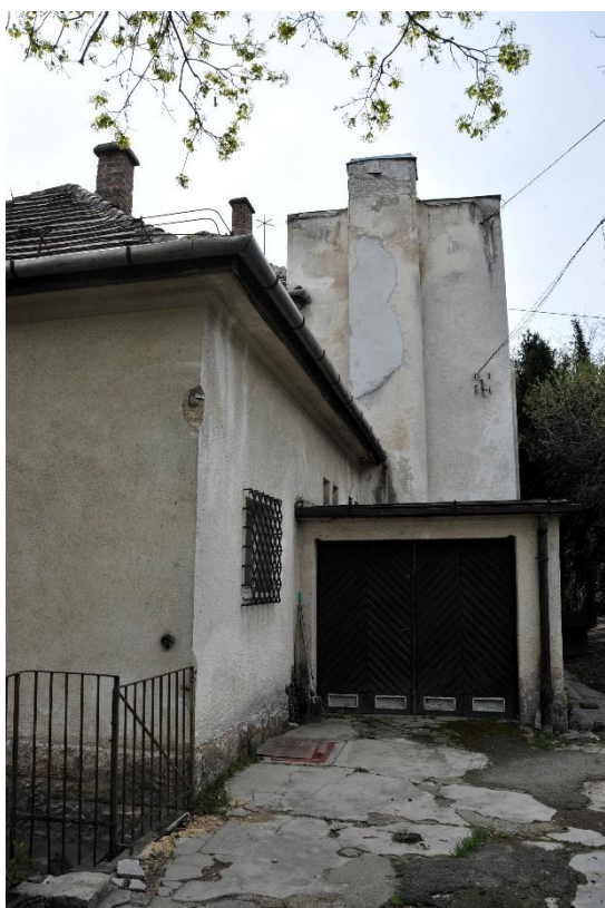
25. kép Északi és nyugati homlokzat
