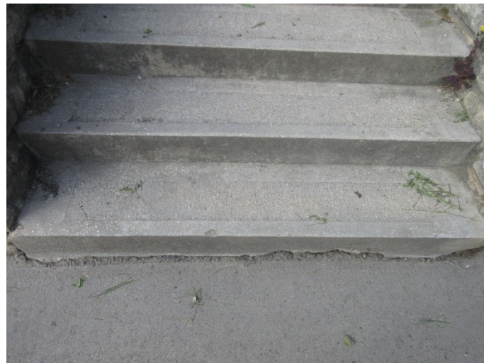
12.-16. A Stromfeld út szintjéről a lakóház bejáratához vezető műkö tereplépcső részletei - építéskori, történeti értékű szerkezet
