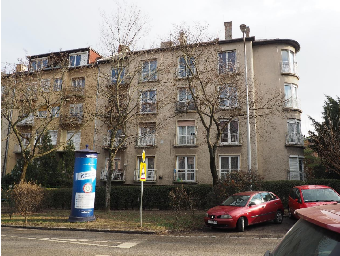
10. kép Németsvölgyi út 34. 2021
