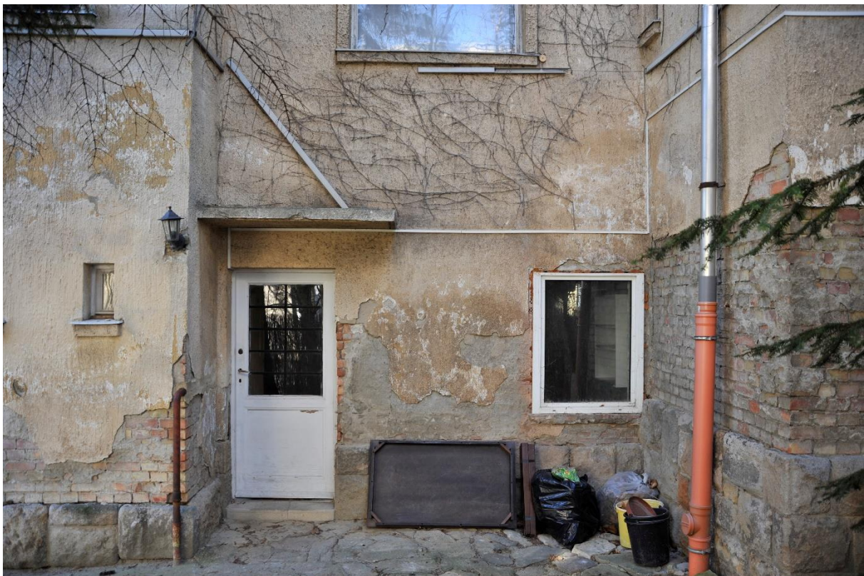
16. kép Északkeleti homlokzat, pincszinti homlokzatszakasz
