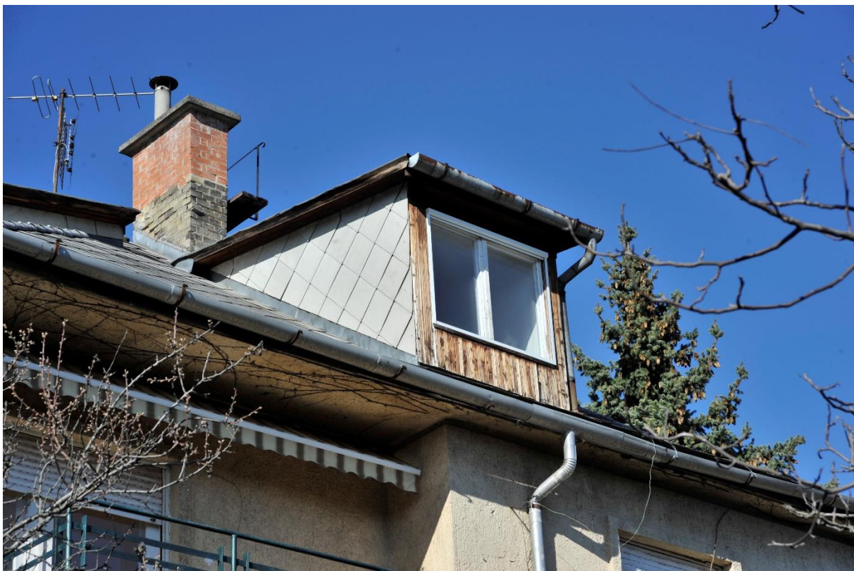
25. kép Későbbi tetőtérbeépítés tetőablaka a délkeleti homlokzat felett
