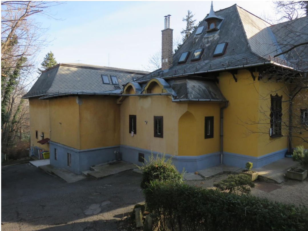
8. kép Az épület nyugat felől
