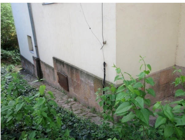
57.-62. Az oldalhomlokzat nyílászáróinak és lábázatának részletei – a terméskő lábázat és a nyíláskiosztások, valamint az erkélyek építéskori szerkezetek, a nyílászárók közül csak kevés építéskori maradt, legtöbbjük már újabb szerkezet
