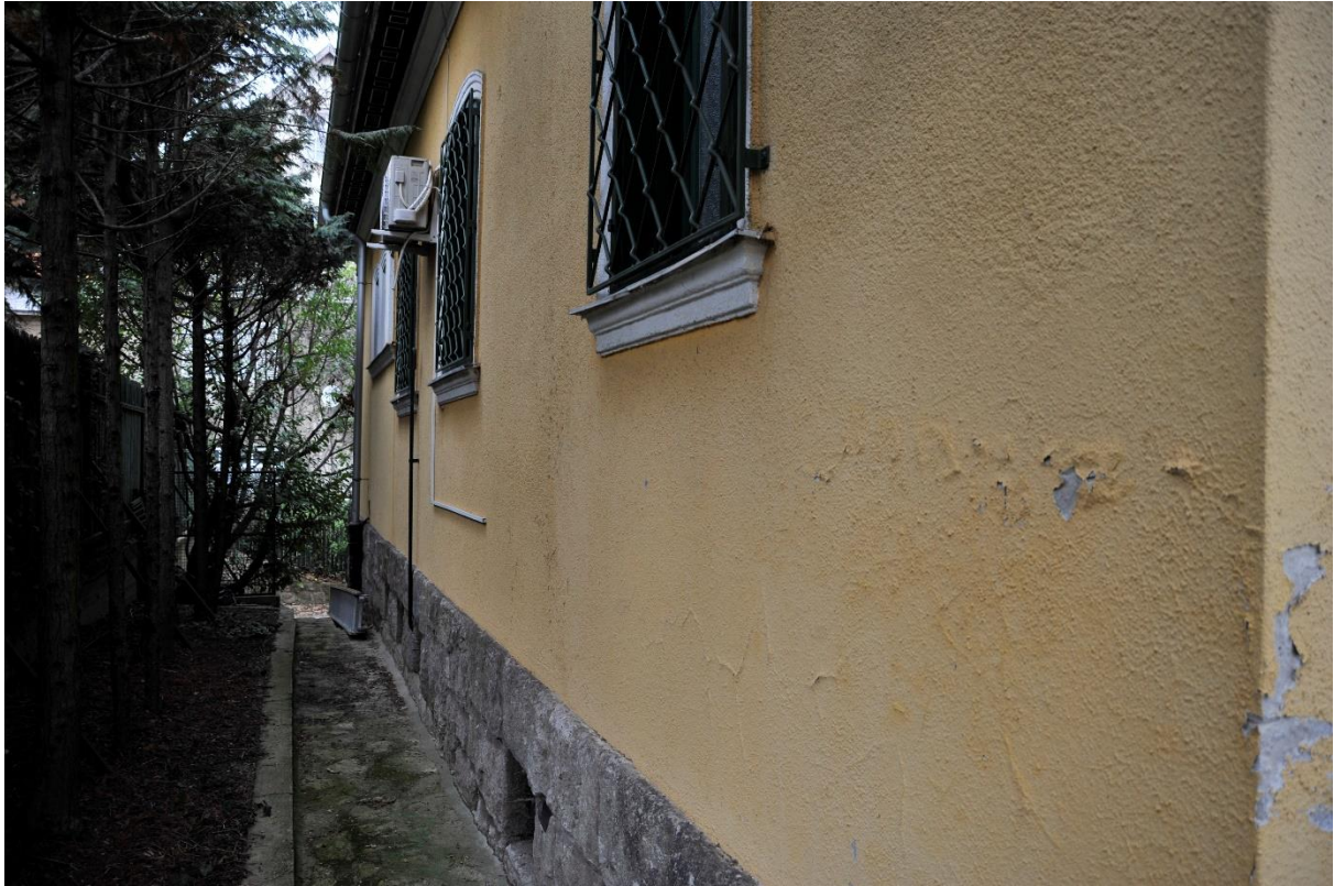
14. kép Nyugati homlokzat
