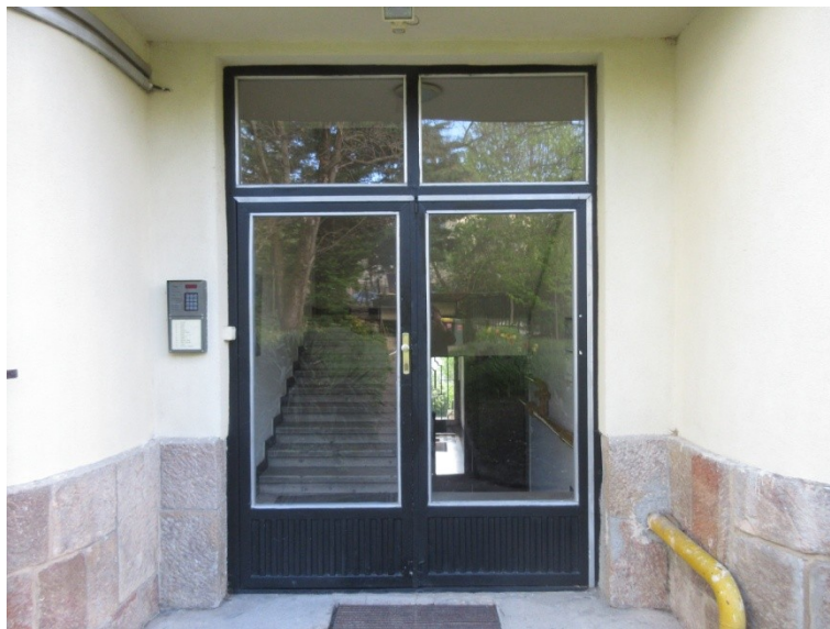
77.,78. A hátsó homlokzat középtengelyében elhelyezkedő bejárat és lépcsőházi üvegfal – a fém-üveg szerkezetű felülvilágító, kétszárnyú bejárati ajtó és a fölötte húzódó osztott felületű, fém-üveg szerkezetű lépcsőházi ablak építéskori, műemléki értékű nyílászárók
