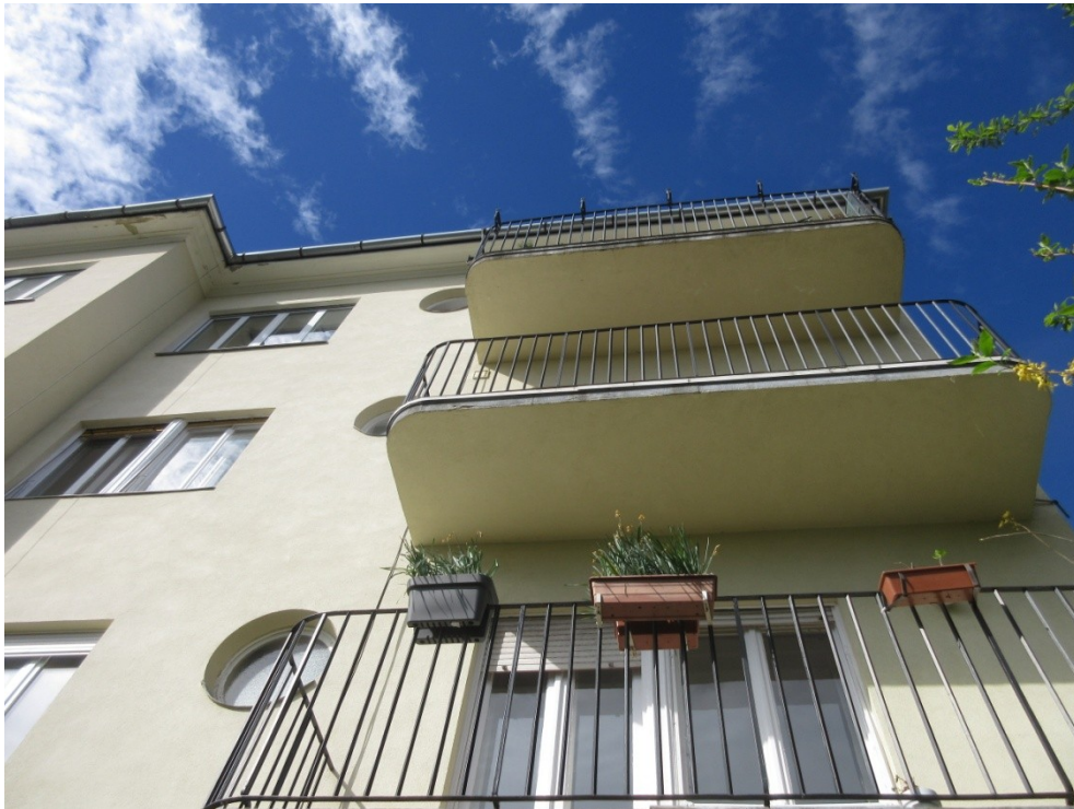
47.,48. A homlokzat jobb (É-i) oldali szakaszának II. és III. emeleti részlete - a nyíláskiosztások és erkélyek építéskoriak. A II. emeleti páros-ablak eredeti építéskori, a négyosztatú III. emeleti ablak új, az eredeti ablakoktól eltérő osztású nyílászáró. A körablakok eredetiek, az erkélyre nyíló nyílászárók új szerkezetek
