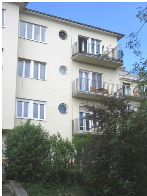
7.-9. A főhomlokzat függőleges tengelyeinek részletei – a földszinten 7, az emeleteken pedig 5 tengelyes homlokzat eredeti építéskori, történeti értékű kialakítású és megjelenésű
