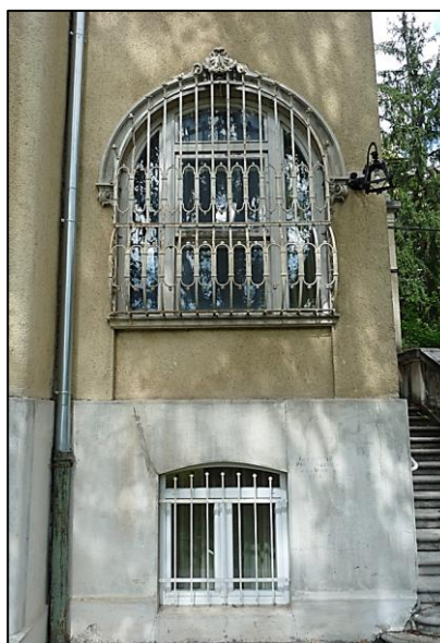
59. kép Nyílászáró részlet
