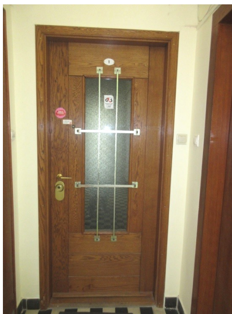
174.-177. A III. emeleti lépcsőpihenő DK-i és ÉNy-i oldalának nézetei a lakásbejárati ajtókkal – eredeti építéskori, történeti értékű kialakítás és burkolatok, a DK-i lakásbejárati ajtó új, az eredeti ajtóhoz nem illeszkedő nyílászáró, az ÉNy-i ajtó is új, de a régi mintájára készült nyílászáró
