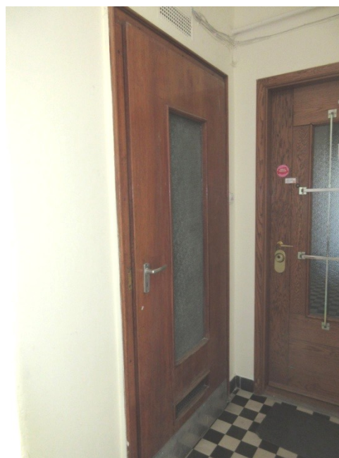
178.-180. Az ÉK-i oldalfalon nyíló lakásbejárati ajtó és az ÉNy-i oldalfalon lévő tároló-ajtók – az ÉK-i lakásbejárati ajtó új, az eredeti ajtókhöz viszonylag igazodó nyílászáró, a két tároló ajtó eredeti építéskori, történeti értékű nyílászárók
