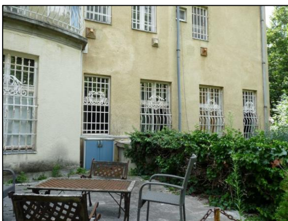
41. kép Északi homlokzat részlet
