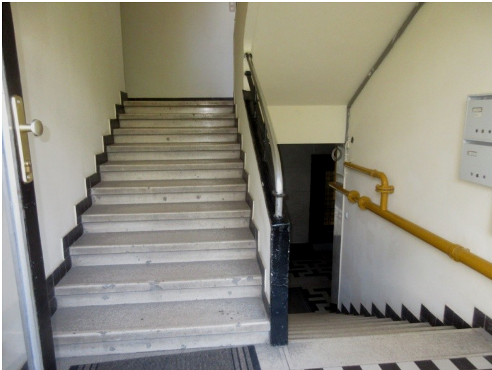
146. A földszintről az I. emeletre (magasföldszintre) haladó és érkező lépcsőkar – történeti értékű kialakítás és szerkezet
