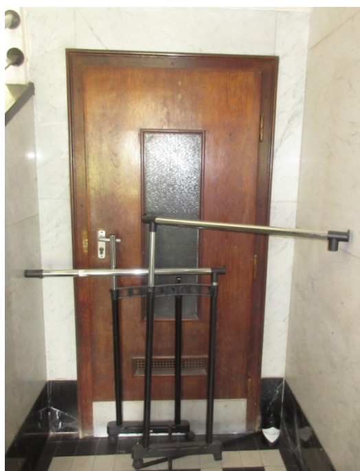
118.-120. A földszinti pihenő DNY-i oldalfalán elhelyezkedő tárolókba vezető ajtók – eredeti építéskori, történeti értékű nyílászárók
