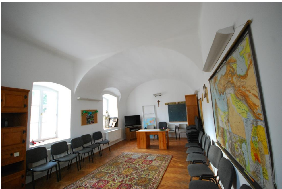
Dongaboltozatos helyiség a földszint déli traktusában, 2018.
