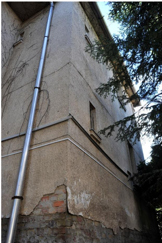
22. kép Északkeleti homlokzat, részlet
