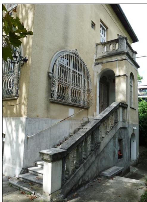
29. kép Keleti homlokzat
