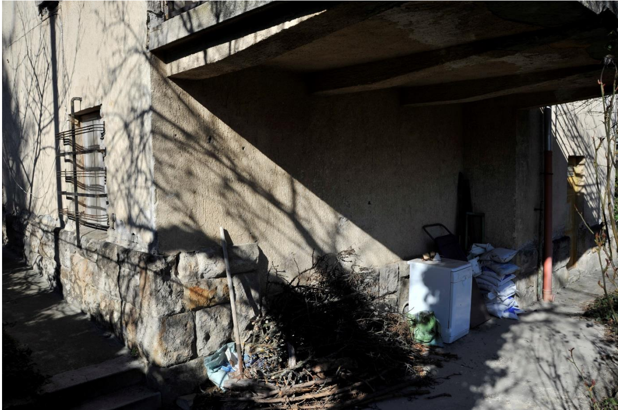
30. kép Délkeleti homlokzat pinceszinti szakasza
