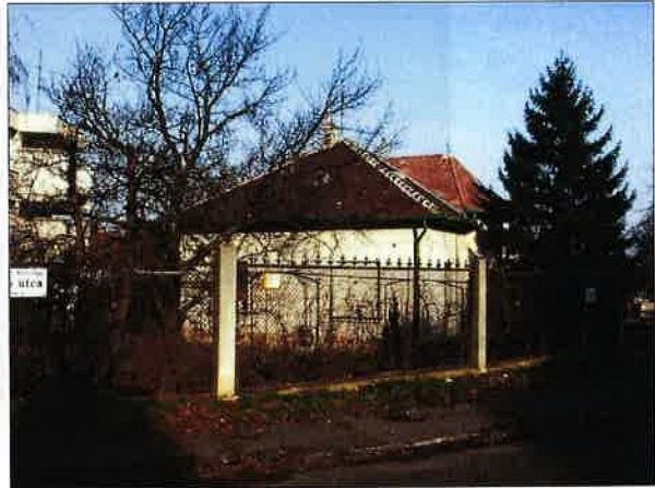
30. ábra Az épület DNy-i homlokzata
