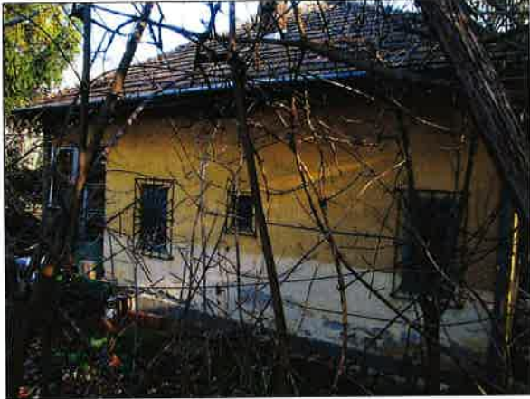
14. ábra Az épület ÉNy-i oldalhomlokzata
