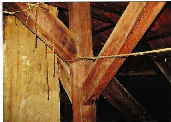
22. ábra Gerenda-csomópont a padlástérben
