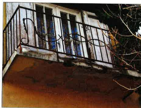
15. ábra Emeleti erkély a főhomlokzaton
