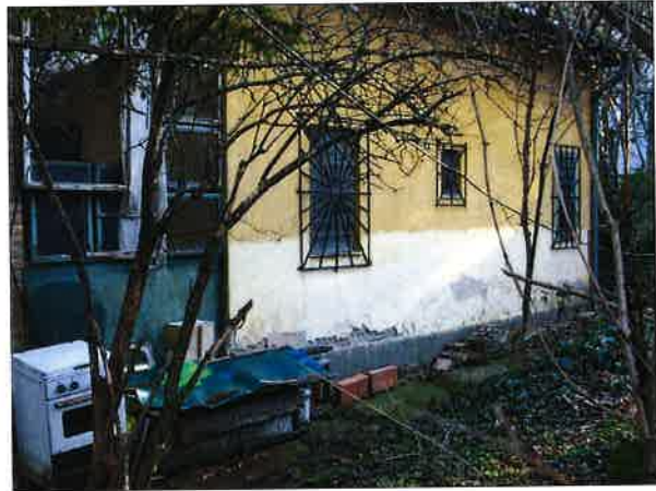
36. ábra Az ÉNy-i homlokzat
