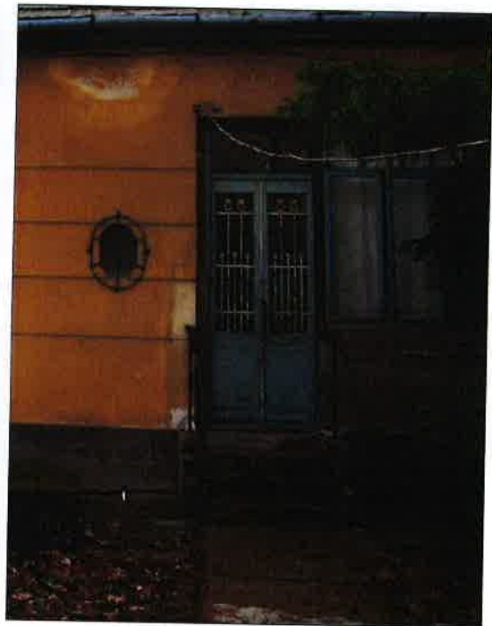
32. ábra Az épület bejárata
