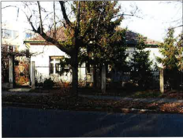
29. ábra Az épület DK-i homlokzata
