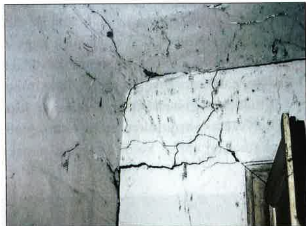
20. ábra Sarokrepedés
