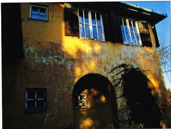
16. ábra Az épület DNy-i oldalhomlokzata
