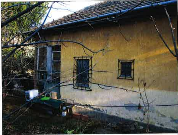
35. ábra Az ÉNy-i oldalhomlokzat részlete
