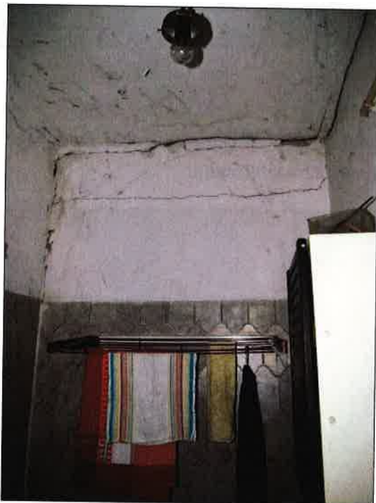
23. ábra Mennyezeti repedések a fürdőszobában
