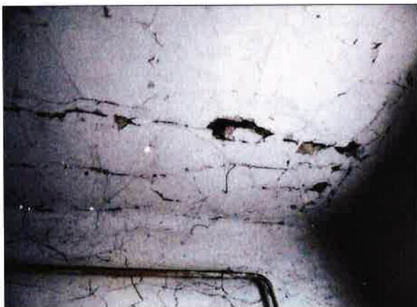
21. ábra Mennyezeti repedések
